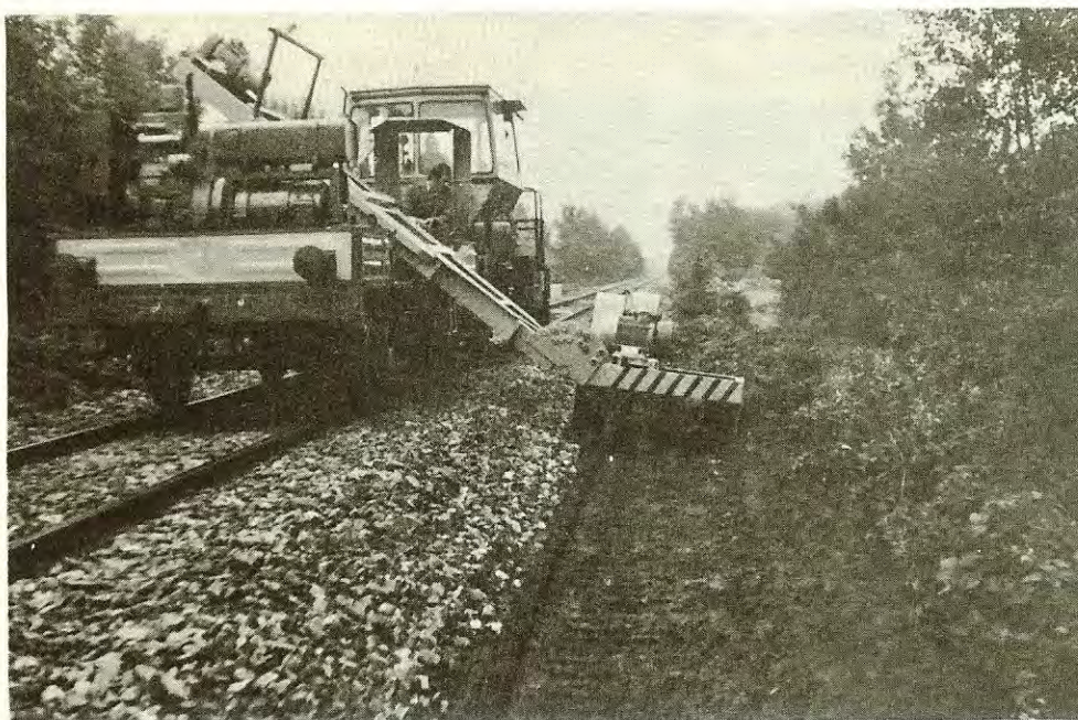
6. ábra: LPP-50 padkavágás közben a - A végzett munkák ábrázolása
