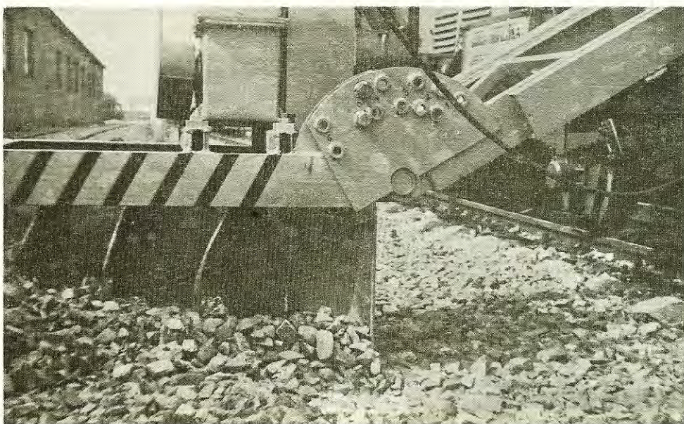
7.ábra: A vágányköz süllyesztése LPP-50 segítségével
