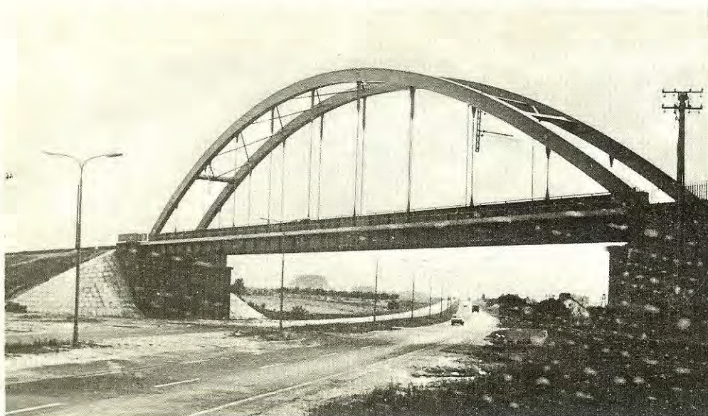
19.ábra: 75 m fesztávolságu, Langer-típusú főtartóju völgyhid
