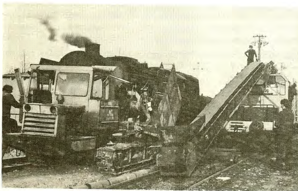
9. ábra: Mélyszivárgók építése állomáson ETC kotrógéppel
