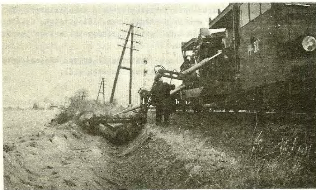
1.ábra: A Pp-500 típusu profilvágó gép munka közben, szabványárok tisztításakor
