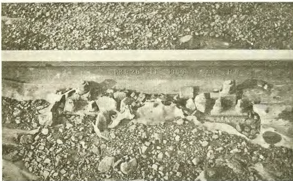
3.ábra: Ágyazat szénpor okozta elszennyeződése
