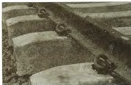
Pandrol rendszerű sínleerősítés
