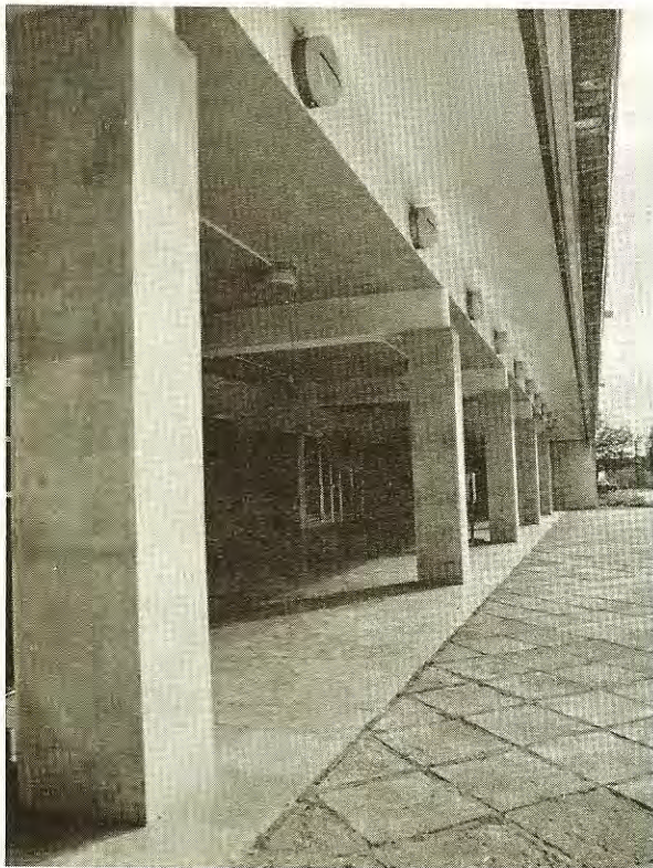
Vágány felőli homlokzat
