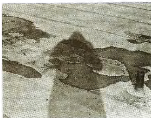
4.kép A tetőösszefolyó környékén áll a víz. A páraszellőző sapkája hiányzik.
