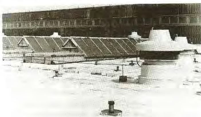
6.kép Előtérben a motoros szellőző rabicköpenye, illetve a páraszellőző bitumenkiöntése, háttérben a felülvilágítók előtti pódiumok NEOACID fedése.
