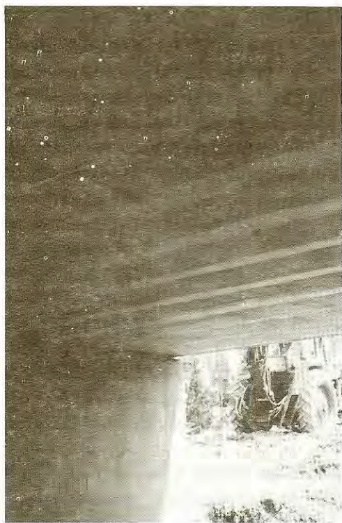
A Kácsi-patak feletti híd áthidaló szerkezetének alsó síkja
