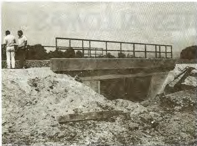
Kácsi-patak feletti híd
