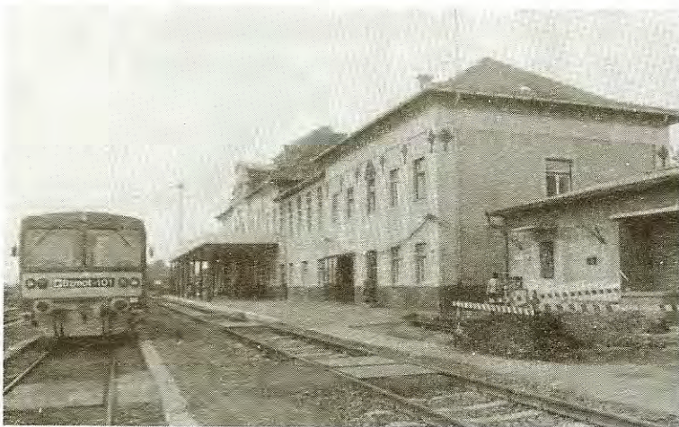
Szentos állomás felvételi épületének vasúti pálya felőli homlokzata
