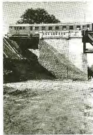
6. ábra Ideiglenes híd a hídfő építésénél
