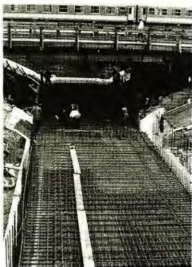
2.kép Az alaplemez vasszerelése
