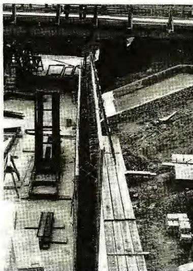
4.kép Két lépcsőkar közötti szakasz beállítva Előtte a forgatópad
