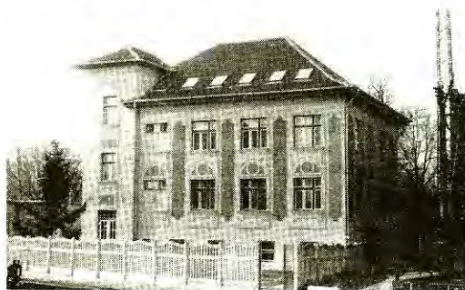
9. ábra A Kecskeméti Pályafenntartási főnökség 1987-88 évben felújított épülete
