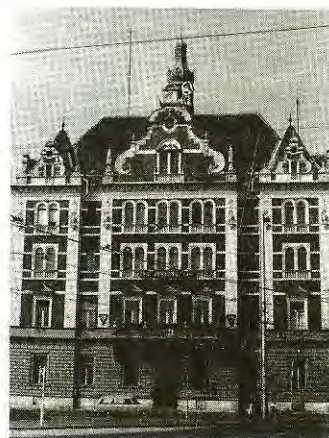
3. ábra A Szegedi Üzletigazgatóság jelenlegi épülete
