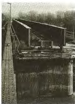
9. ábra A gerinclemezes szerkezet sarura eresztés előtt
