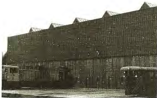
2.kép Vasúti gépjárató műhelycsarnok
