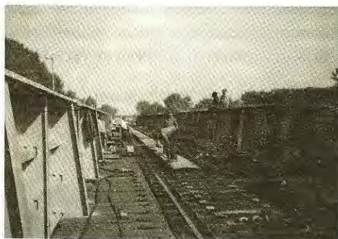
12. ábra A hídpálya készítése
