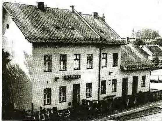
6. kép: Kispest állomás felvételi épülete, épült 1898-ban. Főjavítva 1981-ben, tatarozva 1987-ben.
