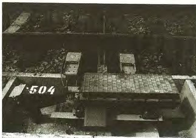
3. ábra Korszerű váltóállító készülék
