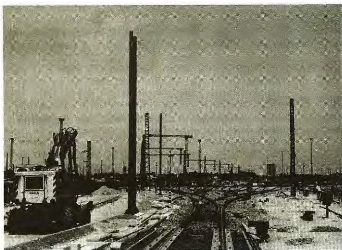
1. ábra Gurítófej építés alatt. (Előtérben a ZWUS vágányfék részlete)
