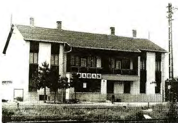
4. kép: Dabas állomás felvételi épülete, épült 1905-ben, főjavítva 1986-ban.
