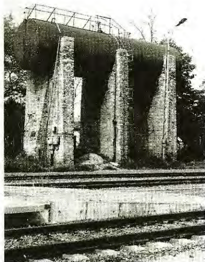
7. kép: Víztorony Ócsa állomáson.
