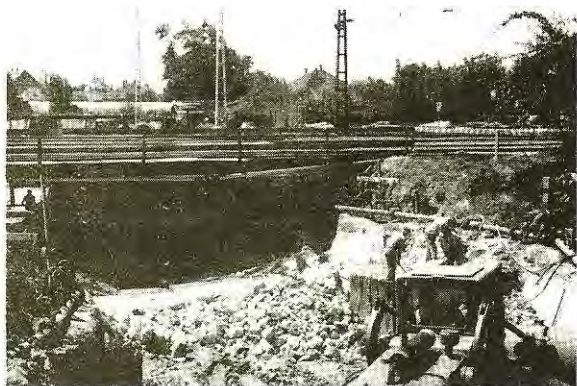
A gyalogos aluljáró építése
