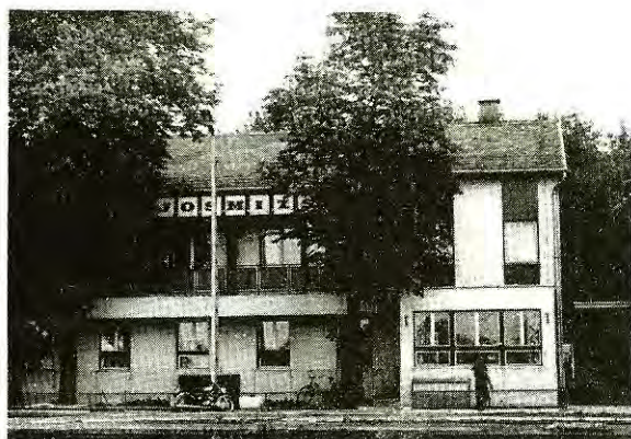
5. kép: Lajosmizse állomás felvételi épülete, épült 1905-ben, főjavítva 1986-ban.
