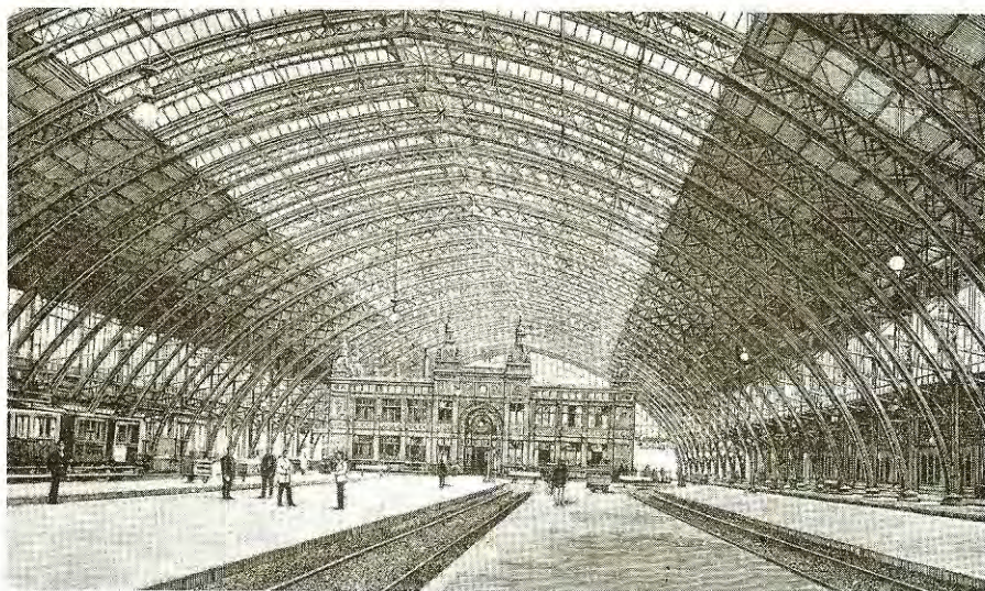
5. ábra Csúcsívben záródott az 1894-ben megnyitott, második Kölni pályaudvar vasszerkezetű csarnoka
