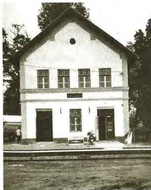
10. kép Balkány állomás felvételi épülete
