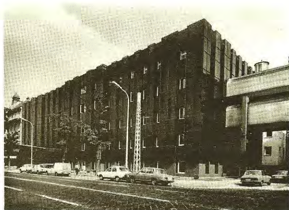
Budapest MÁV Kórház és Központi Rendelőintézet Gazdasági épület Építés bef.: 1986.
