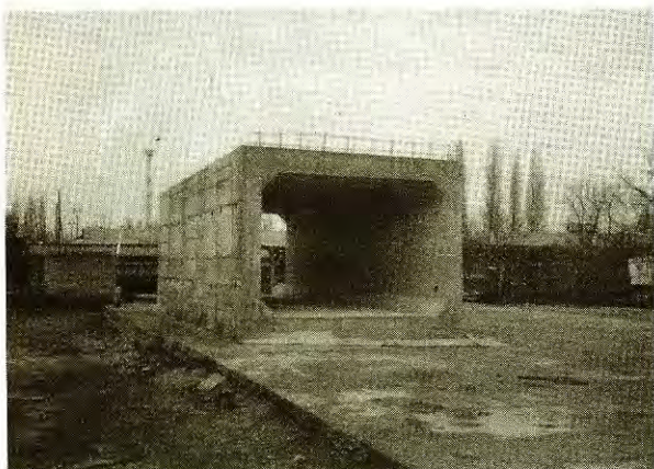
1. ábra A MAV Hídépítési Főnökség által gyártott vasbeton keretszerkezet
