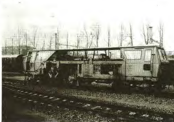
1. ábra ASP-400.1 automatikus aláverőgép, a műszaki diagnosztikára beépített mérőműszerekkel (leltári száma: 145)
