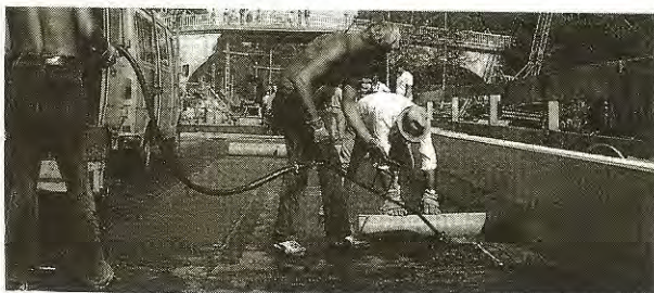
5. ábra Carbodur szigetelő lemez elhelyezése
