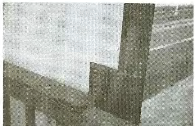
12. ábra Reklámtábla szakszerűtlen rögzítése
