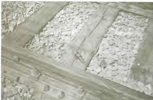
9. ábra Színdilatációs készülékben meglazult és kiesett hevedercsavar
