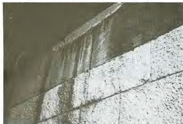
7. ábra A felüljáró elrepedt szerkezeti gerendája
