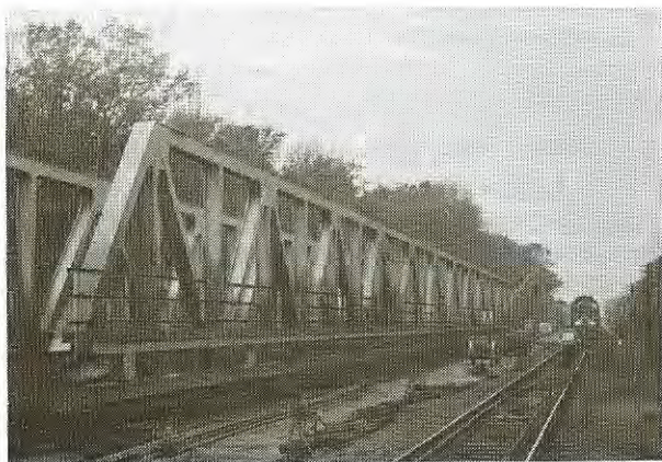
4. ábra A sárvári Rába-híd szerelése
