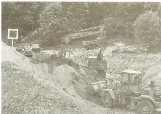
4. ábra MÁVÉPCELL Kft. mélyépítési munkahelye
