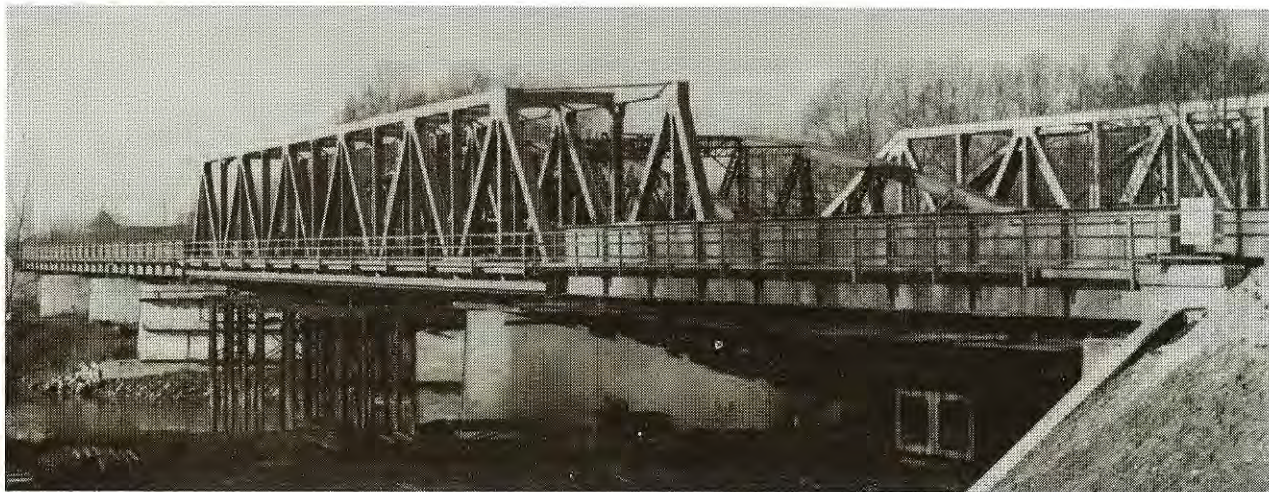
11.sz. kép A győri GySEV Rába-híd az építés befejezése előtt
