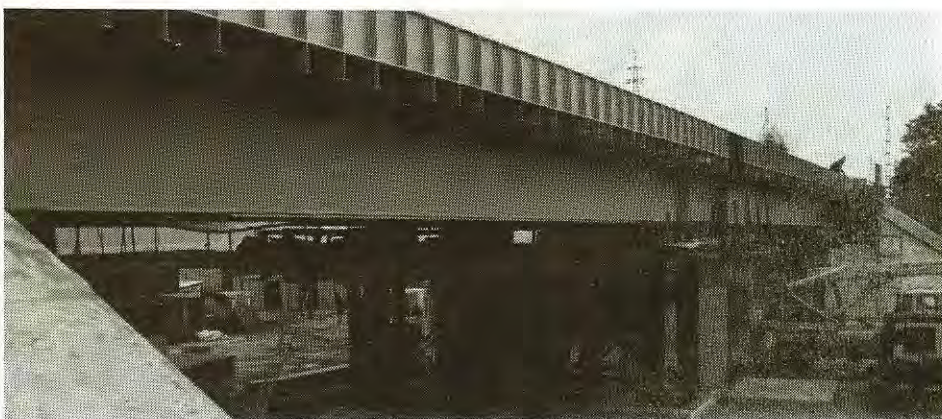
22.sz. kép Az MO-ás vasúti híd szerelés alatt
