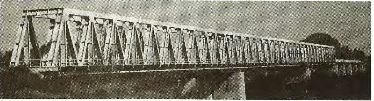
14.sz. kép A csongrádi vasúti Tisza-híd
