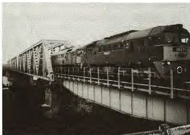
1. ábra: Tiszafüredi Tiszahíd próbatelhelése
