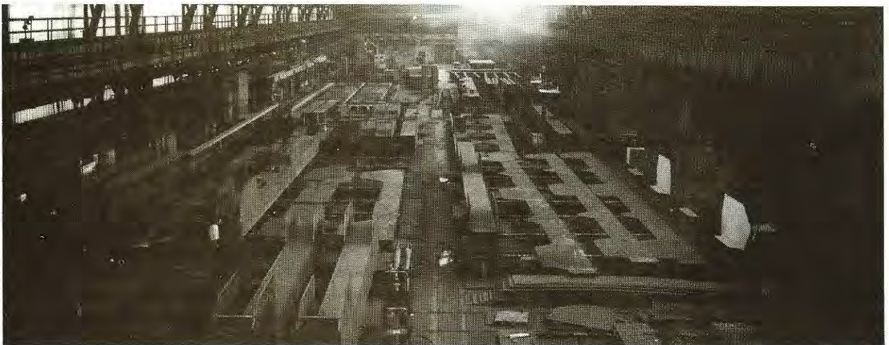
16.sz. kép A csongrádi Tisza-híd mederszerkezetének gyártás a Ganz- MÁVAG budapesti gyárában
