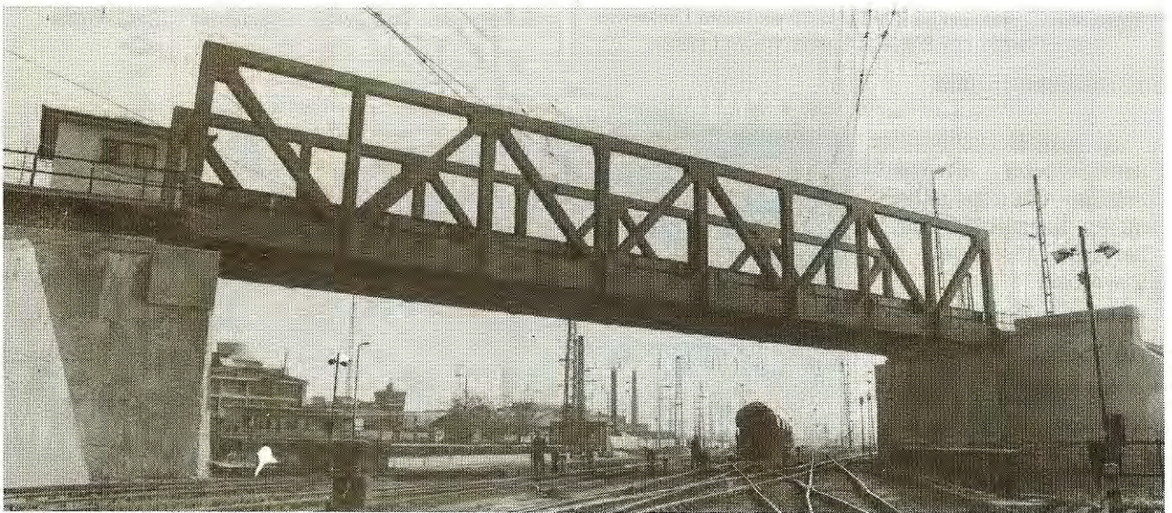
19.sz. kép Az Illatos úti-híd
