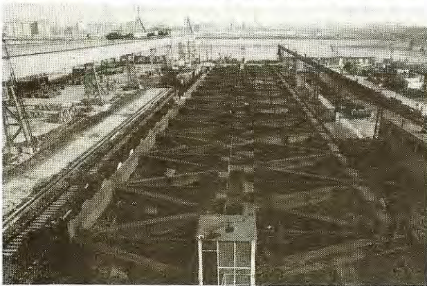
18.sz. kép A csongrádi Tisza-híd főtartóinak kifektetése a Ganz- MÁVAG lágymányosi előszerelő telepén
