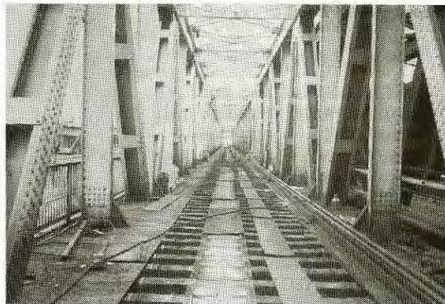
4. ábra: Hídacsere a Déli összekötő Vasúti hídon
