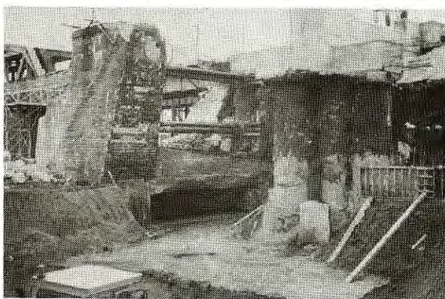
12. ábra: Fürt cölöppel kialakított hídfő
