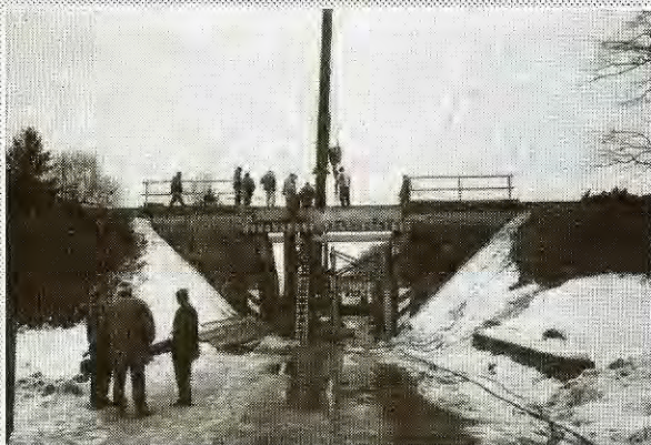
1. kép Régi híd bontása
