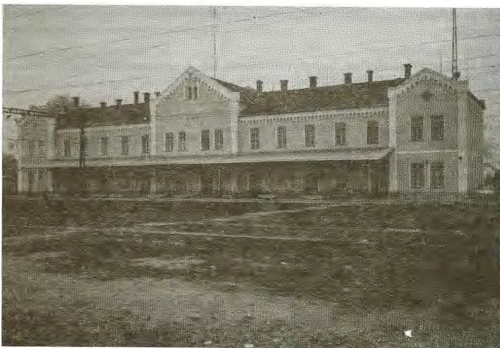
1. kép: Mezőtúr állomás felvételi épülete, vágányok felőli homlokzat, felújítás után
