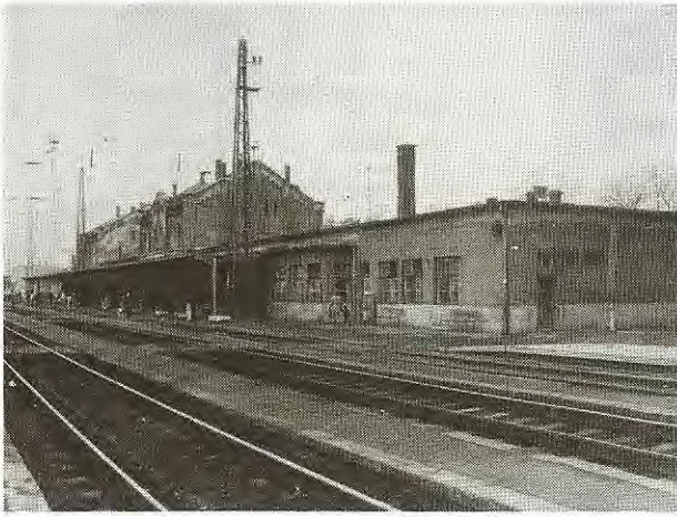
2. ábra Szerenc felvételi épület (felújítás előtti állapotban)
