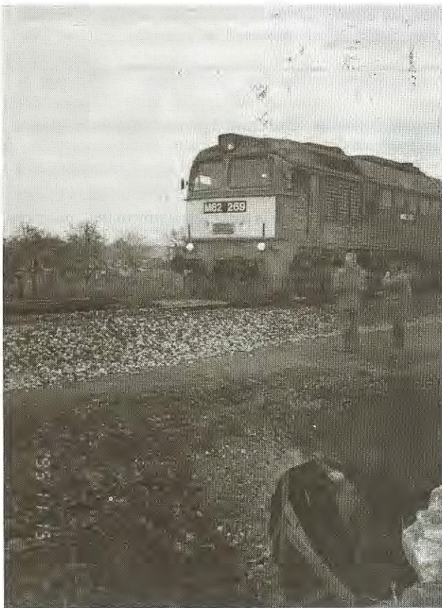
18. ábra A híd próbaterhelése
