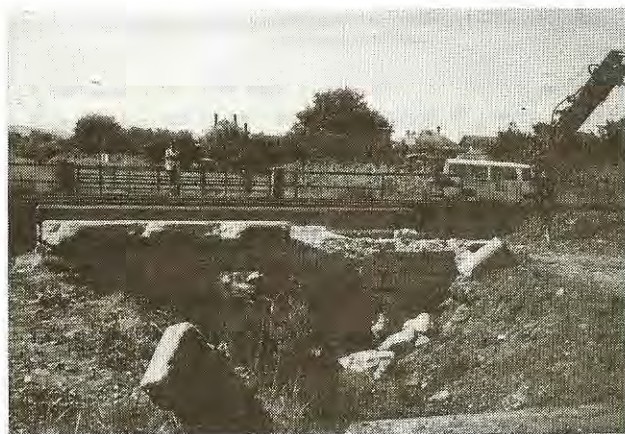
13. ábra A régi hídszerkezet bontása
