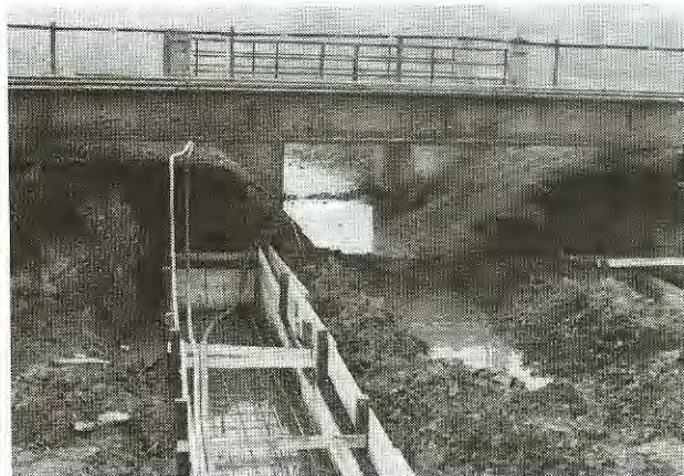
3. ábra Az épülő új híd
