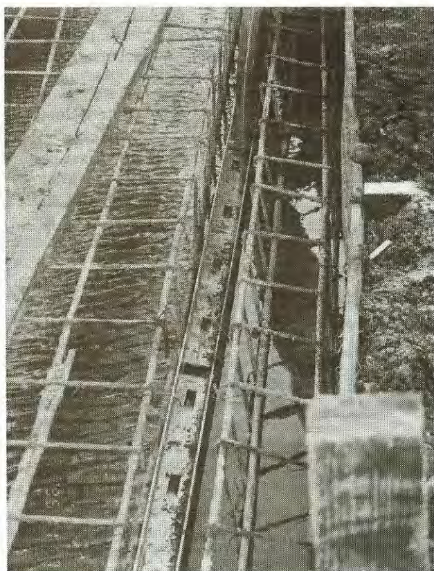
15. ábra Talpcsatorna kialakítása, elhelyezése
