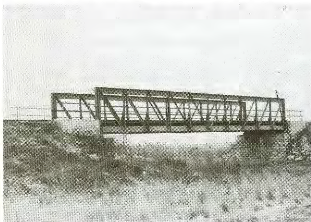
2. ábra A szakmári Malomér-híd
