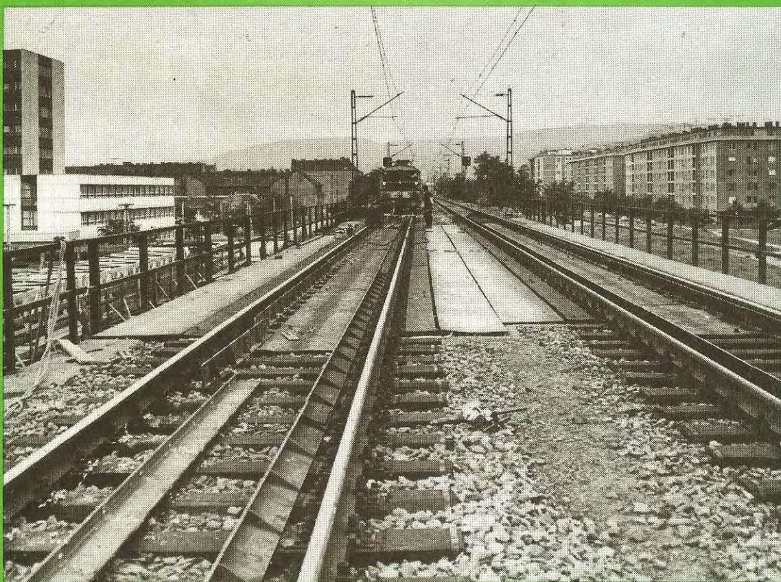
A Bp. Ferencváros-Kelenföld közötti Budafoki úti acélszerkezetű híd terelősíneinek szerelése
