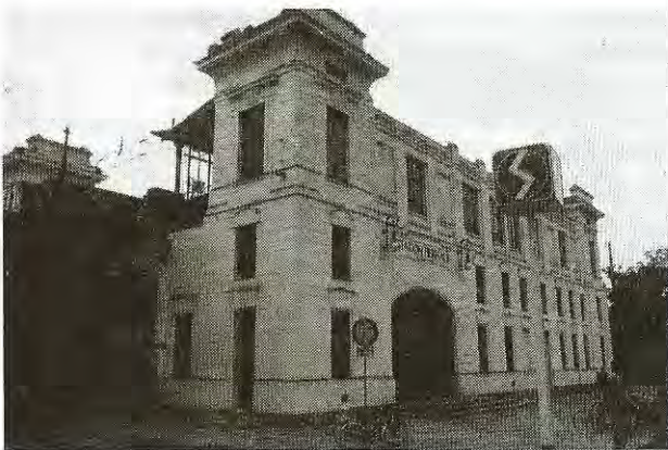
2-3. ábra S-Bahn állomás
