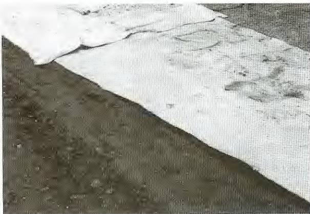
9. ábra. Netlon háló beépítése
