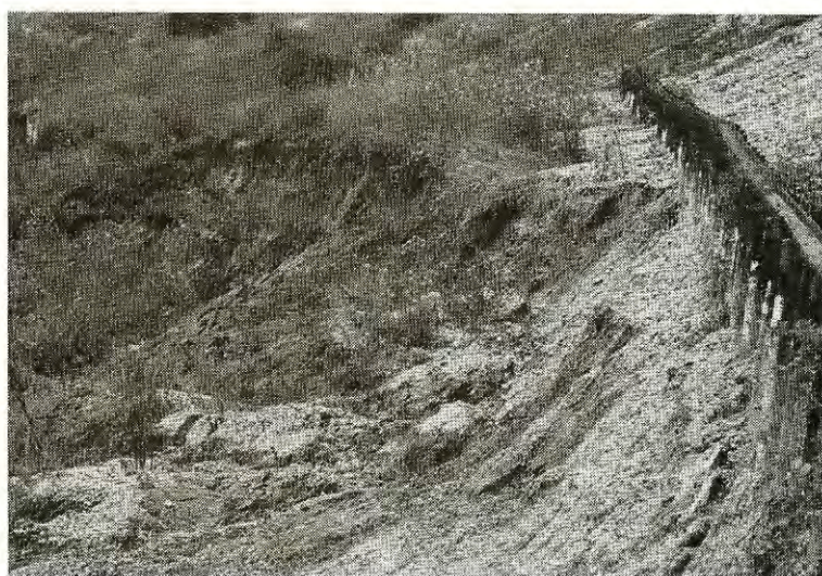
Nagyút-visontai vonal 96-102 közötti szakasza 1999. július 13-án
