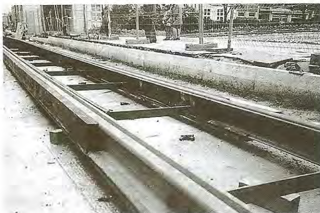
11a ábra: A cottbusi Altmarkt átépítése (Építési fénykép)
