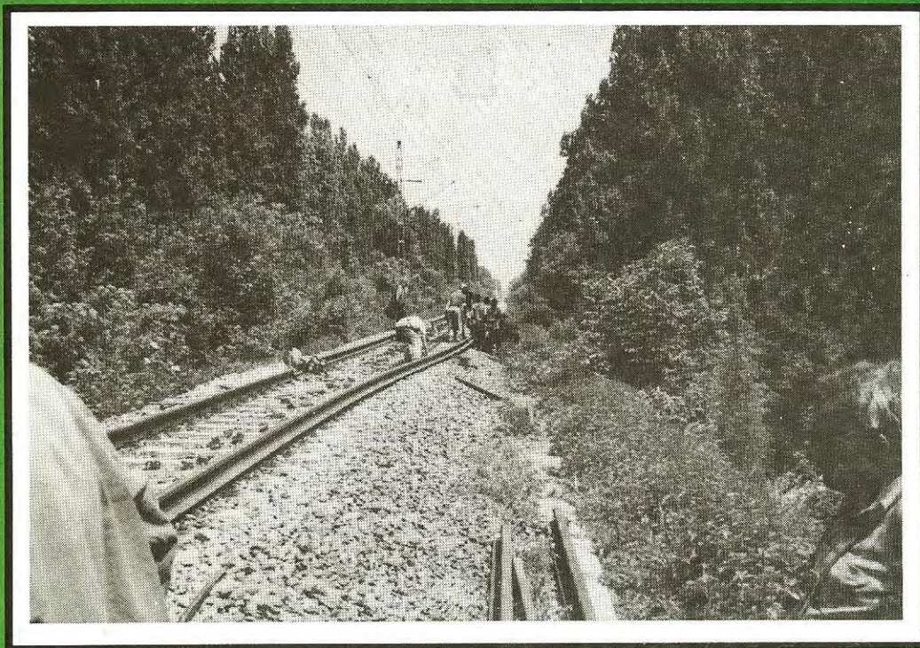
Előkészületek záróhegesztéshez Tokaj-Rakamaz között
