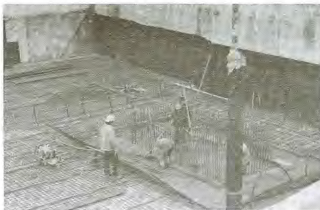
4. ábra: "Pariser Platz" beruházás, Berlin (Épület rezgésszigetelése ágyazó szőnyeggel)
