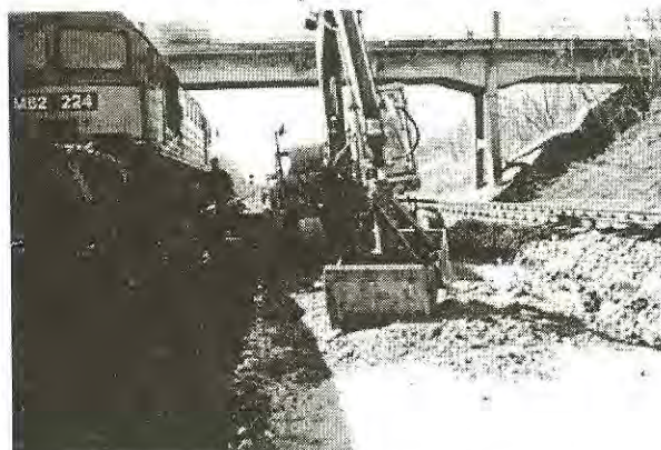
Előkevert consolid védőréteg elhelyezése
