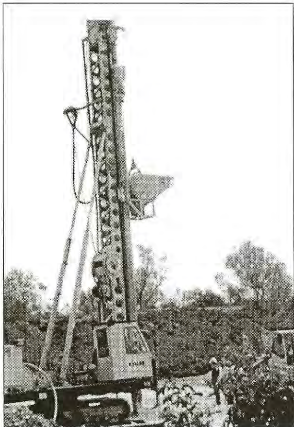
12. ábra. Vibro kavicscölöpgép a töltést végző homokrakodóval (283-288. szelv. között)
