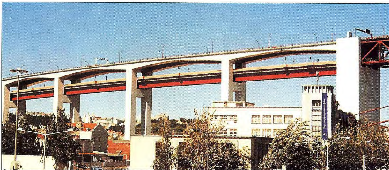
7. kép. A keleti oldali vasbeton feljáró híd egy része az újonnan beépített öszvérszerkezetű vasúti pályával
