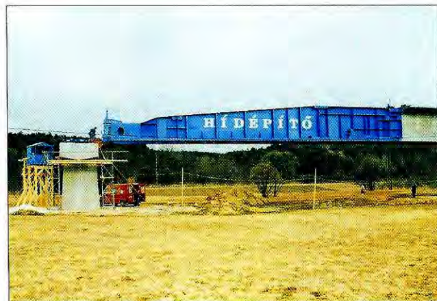
5. ábra. Szerelőcsőr az „A” híd elején
