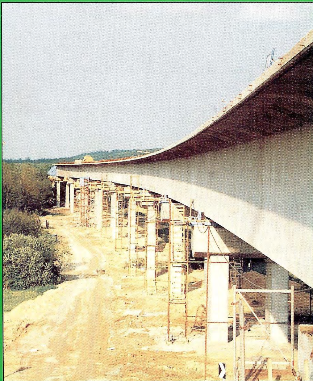
Az épülő völgyhíd íves szakasza
