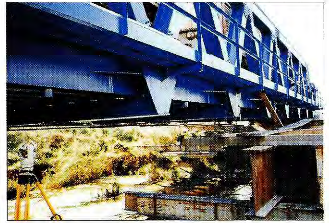
2. kép. Alsó csomópontok szárnylemezekkel
