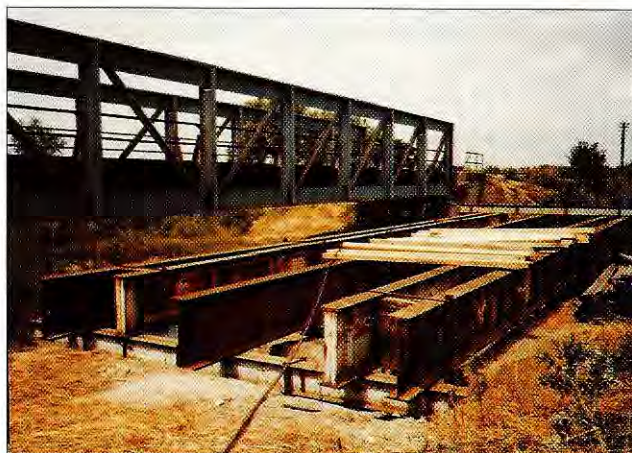
3. kép. Szerelőtér az új hídszerkezet összeállításához
