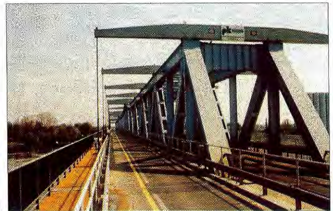
4. ábra. A megerősített és kiszélesített oldalpálya
