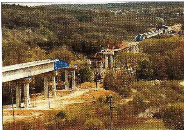
6. ábra. Magyar–szlovén vasútvonalon épülő völgyhíd a közbenső monolit részszel
