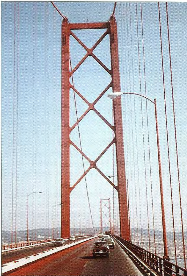
2. kép. A híd pilonjai és 2x2 sávos közúti pályája az eredeti kiépítésben (I. ütem)
