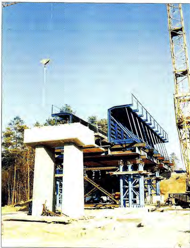
2. ábra. Gyártópad a H01 hídfőnél
