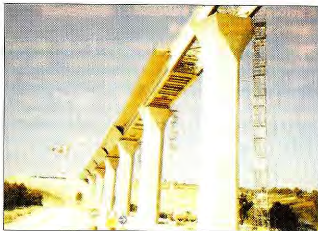
3. ábra. Pályatartó építése betolással
