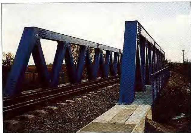
5. kép. Az új Gaja-patak híd.
