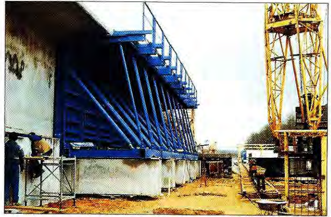
1. ábra. Gyártópad a H1 hídfőnél
