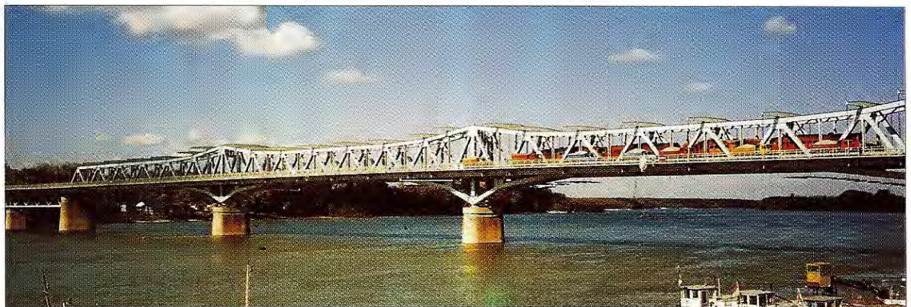
4. ábra. Baja Duna-híd konzol megerősítését követő próbaterhelés
