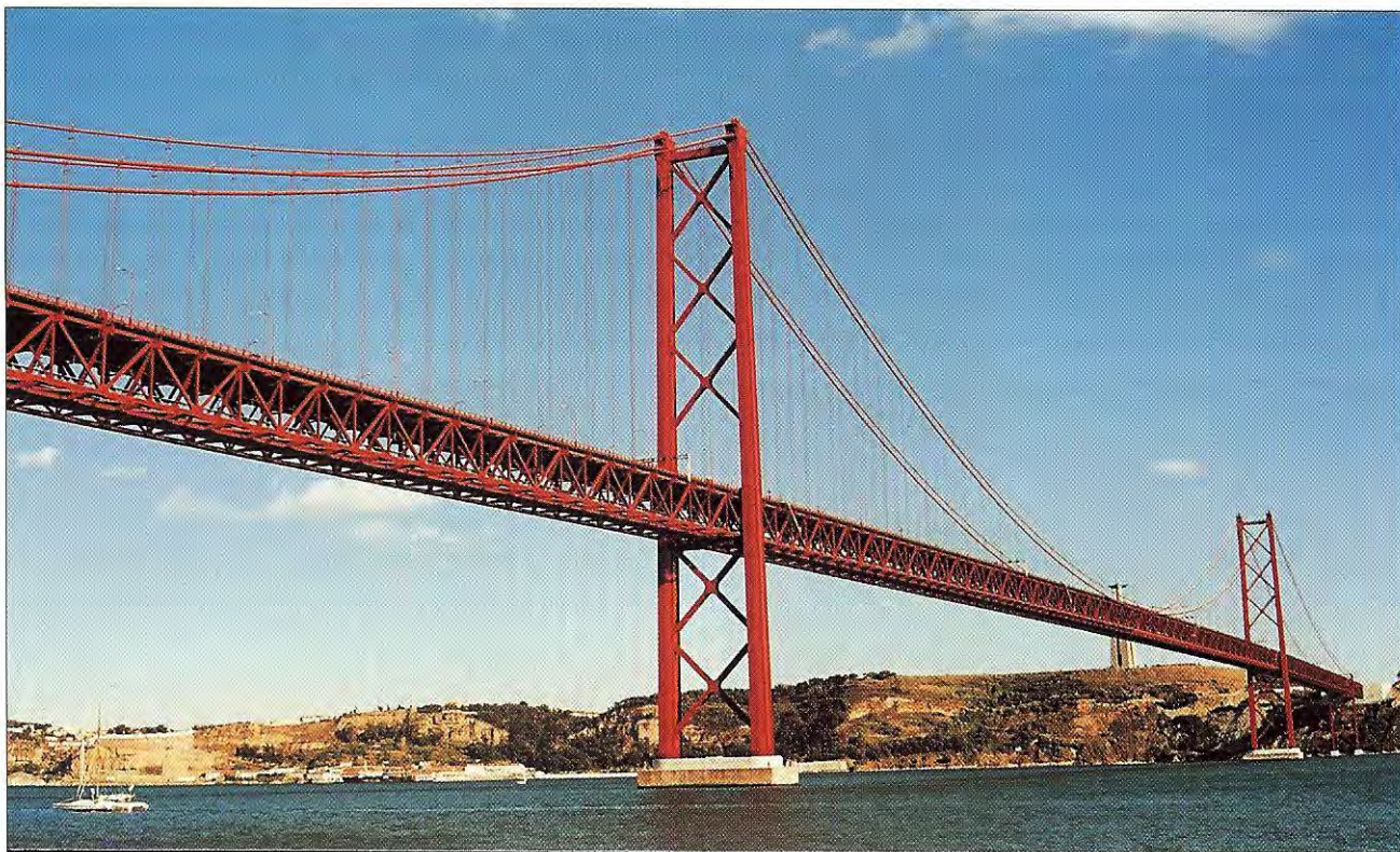
8. kép. A lisszaboni Tejo-híd átépítés után látképe (1999-ben)
