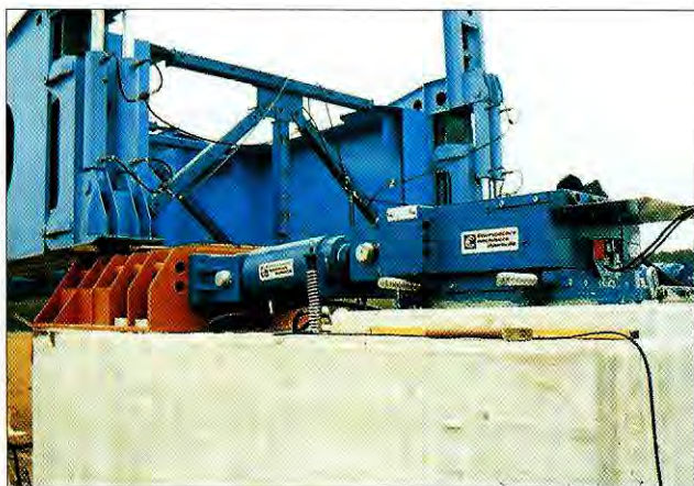
3. ábra. Emelő-toló sajtó rögzítése
