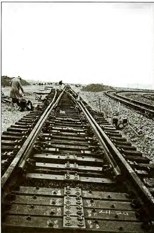
14. ábra. Nagysebességű kitérő beépítése a Transportation Technology Center területén (Colorádóban)
