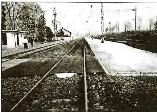
1. ábra. Szikszo állomás felújított peronja
