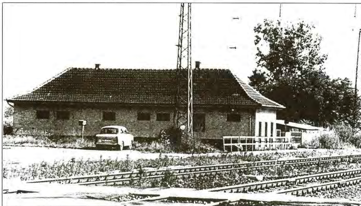
A felújítás előtti állapot
