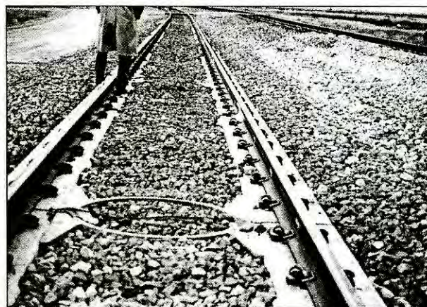
7. ábra. Acél kereszt-távartók a nyomtávolság biztosítására végett.
