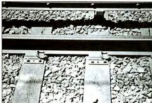
4. ábra. Pandrol rendszerű sínleszorítás acél alátétlemezekkel
