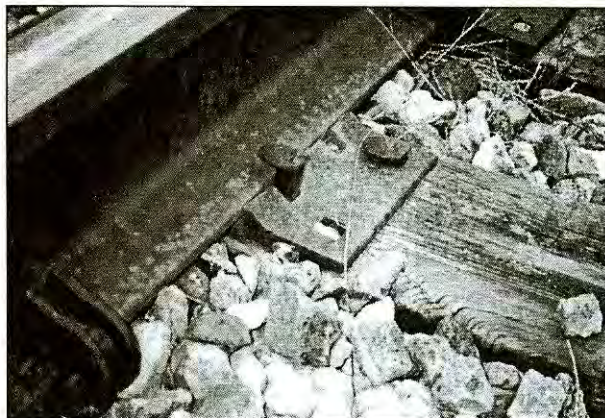
3. ábra. Kilazult sínszeges sínleerősítés
