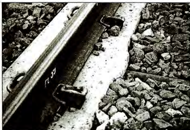
6. ábra. Vasbeton gerenda hosszaljakkal épített vágány
