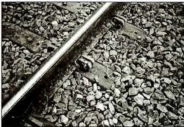
5. ábra. Rugalmas szorítógyűrűvel kialakított rugalmas sínleerősítés acélkeresztaljakon
