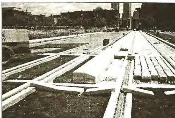
Aszfalt teherhordó rétegre fektetett, vasbeton gerenda hosszaljas vágány
