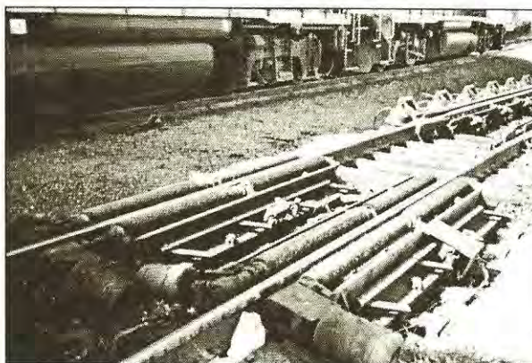
Gerendás rendszerű vágányfék Chicagonak a Belt Railways of Chicago nevű vasúttársaság által üzemeltetett egyik rendező pályaudvarán
