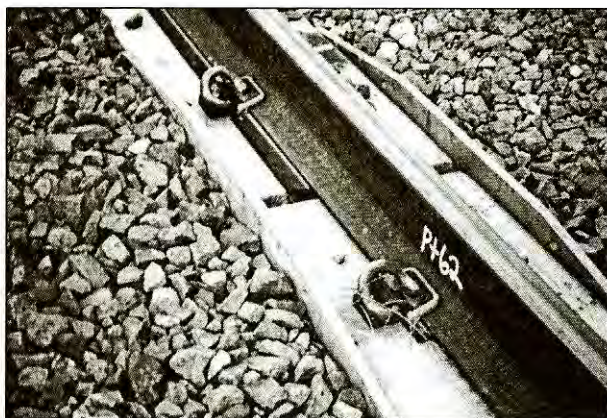
8. ábra. A vasbeton gerenda hosszaljak hevederes illesztése, a hosszalj gerendák nincsenek folytatólágossá téve.
