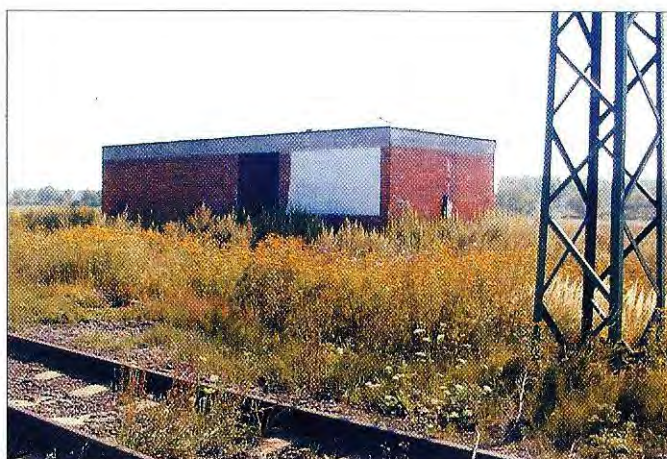
A kiágazásnál lévő biztosítóberendezési épület
