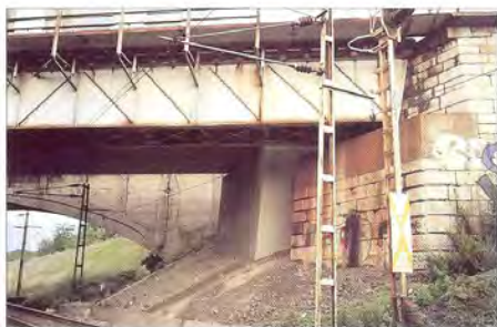
6. ábra. A 3 hidszerkezet végponti ellenfalai
