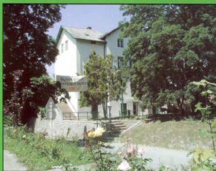
Zebegény állomás felújított felvételi épülete
