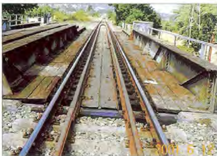
4. ábra. Új híderendák és új csatlakozó vágány
