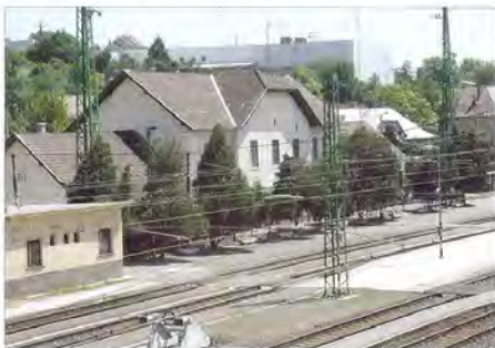
2. ábra. Szob felújított felvételi épülete a vágányok felől
