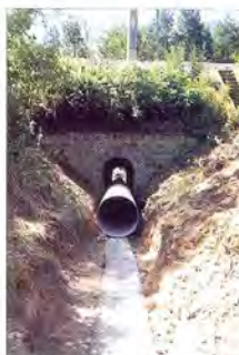
1. ábra. A VOEST-ALPINE cső behúzása (2001. június)
