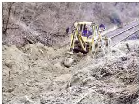
2. ábra. A lecsúszott föld eltávolítása a vágányról
