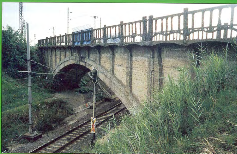
Az érdi 3 csuklós betonhíd
