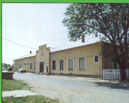
Kisbér állomás felvételi épülete
