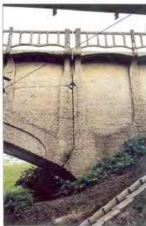
3. ábra. Támaszponti csukló a vasalt korlátkonzollal
