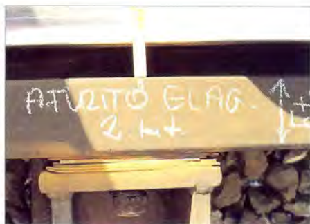
5. ábra. Almásfüzitő – elágazás 2. sz. kitérő bélélt vezető vasa 1999. január hóban
