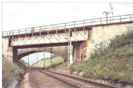
9. ábra. Távlati kép a jobb vágányú acélhíd felől
