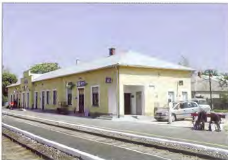
5. ábra. Kisbér állomás felújított felvételi épülete
