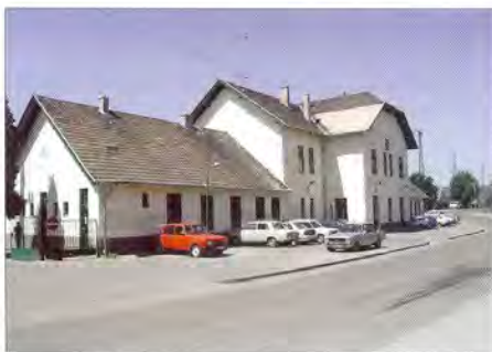
3. ábra. Szob állomás utcai homlokzata
