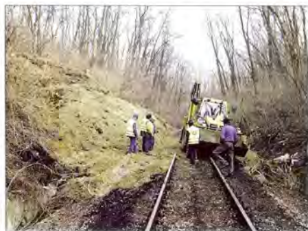
3. ábra. Ideiglenes helyreállítás – a lecsúszott rézsű kiszélesése
