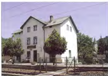
1. ábra. Zebegény felújított felvételi épülete
