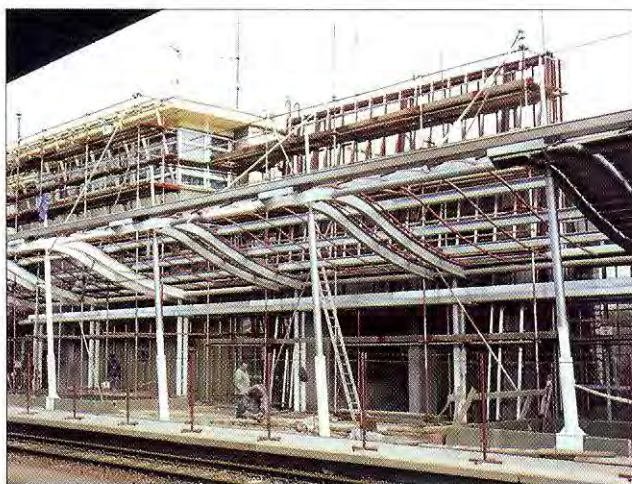
17. ábra. A főperontető acélszerkezete (2002)
