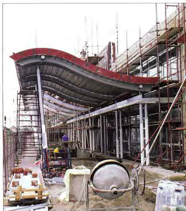
16. ábra. A főperont fedő új perontető (2002)
