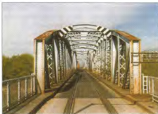
2. ábra. A vasúti híd mederszerkezete Pusztataksony felől
