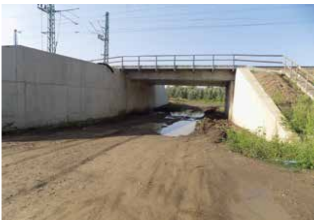
18. kép. Az első ütemben, 2014 júliusában készült el Szajol felől a 1092-es szelvényben lévő teknőhíd. Érdekessége, hogy az építés idejére a jobb vágányban 26,6 m-es acél-provizóriumot helyeztek el, azon zajlott a vonatforgalom, az engedélyezett sebesség 40 km/h volt.
