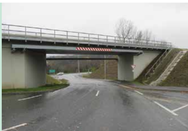
8. ábra. A 17,90 m nyílású tartóbetétes vasbeton lemezhid, Terranova közúti aluljáró a 203+39 szelvényben
