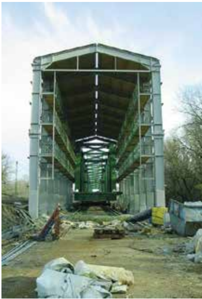
7. kép. A festő-sátorban került sor az acélfelület tisztítására és az összehegesztett híd többretegű mázolására. Végleges színe rezedazöld lett.
