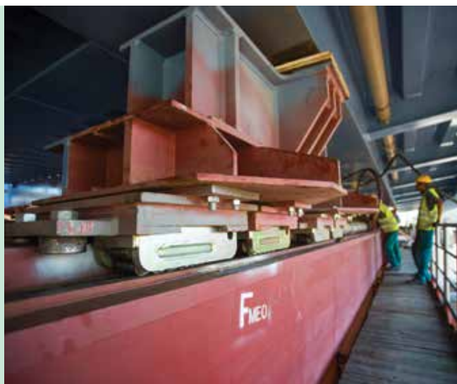
10. ábra. A görgős kocsikon előrehaladó felszerkezet
