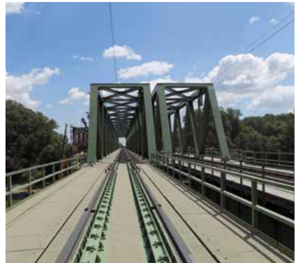
16. kép. Az új, egyvágányú, karcsú hídszerkezetek
