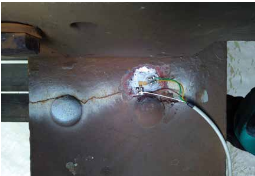
5. ábra. Nyúlásmérő bélyeg telepítés közben a DÖVH hossztartó felső övén
