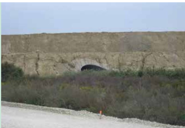
18. ábra. A 7,07 m nyílású hullámosított acéllemez közötti felüljáró a vasúti pályán kívül, a 112+10 szelvényben
