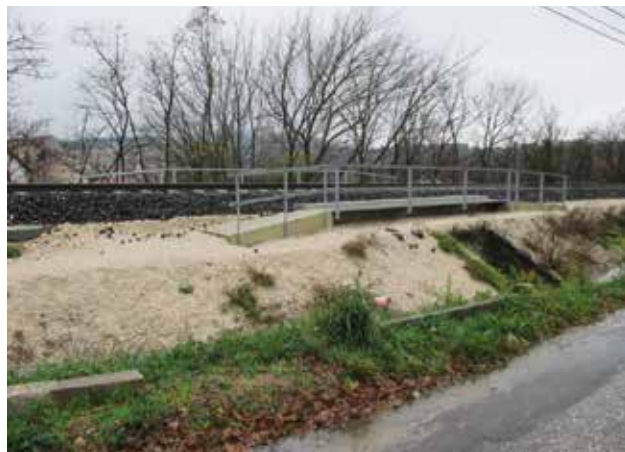
12. ábra. A 2,00 m nyílású boltozat előre gyártott, összefeszített vasbeton teherelosztó lemezzel megerősítve a 243+32 szelvényben
