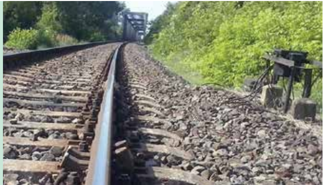
2. ábra. Az algyői Tisza-híd, előtérben a tengelyszám-láló fejjel, jobbra a sínáramkörü Drosszel-transzformátor
