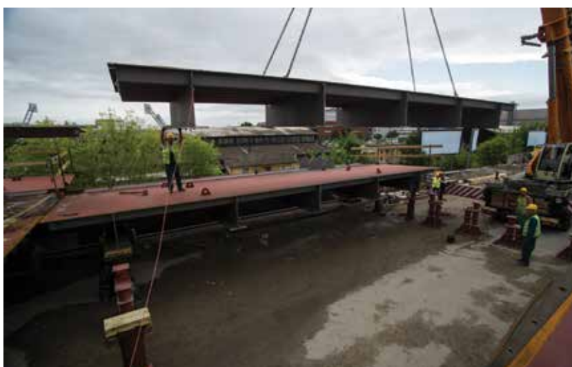
6. ábra. Ortotróp pályalemez helyszíni illesztése
