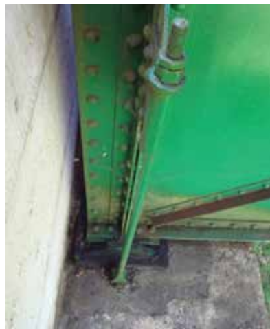
12. ábra. A Mélyvölgyi híd alátámasztása a hídfőkönél
