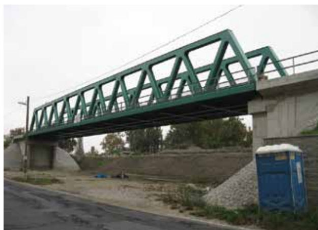
14. ábra. Az 50,80 m nyílású, Jégtörő utcai alsópályás rácsos acélhíd a 33+44 szelvényben
