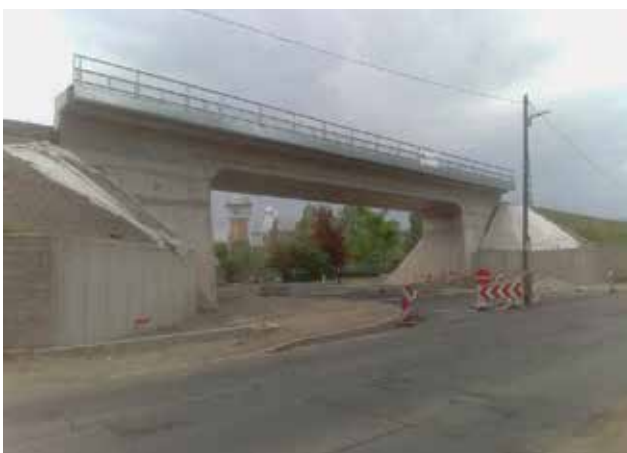
13. ábra. A 20,58 m nyílású szegélybordás vasbeton lemez híd a 30+06 szelvényben
