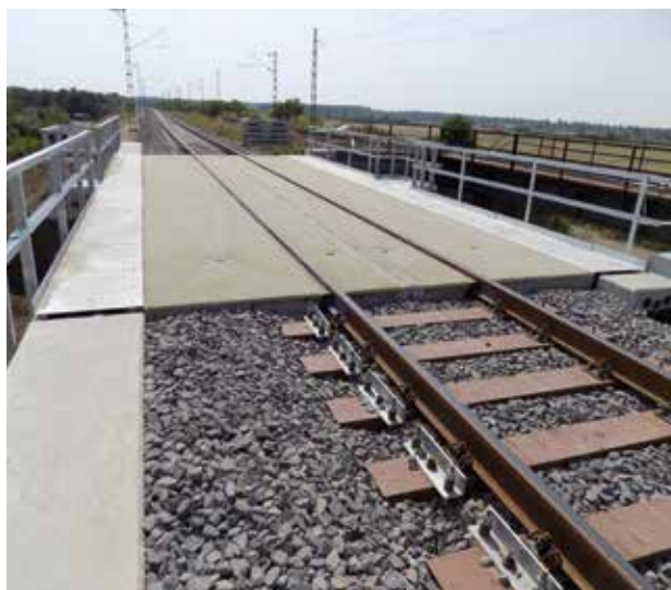
21. kép. A beépített új vasbeton áthidaló szerkezet
