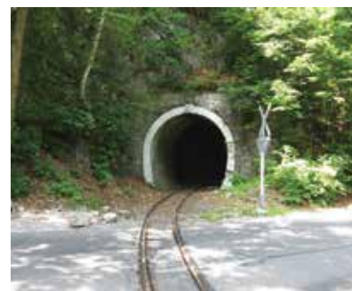
23. ábra. A Lillafüred állomás utáni alagút a kezdőpont felől (74+85,40–76+05,40 hm szelv.)
