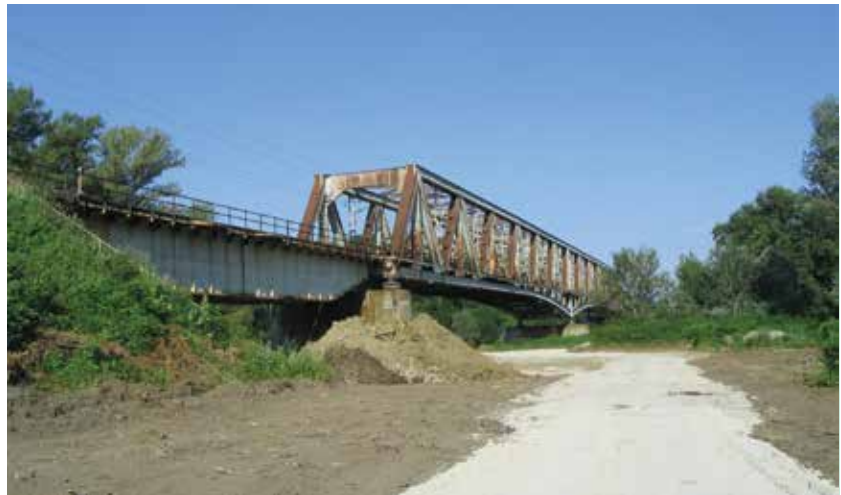
2. kép. Az átépítési munkák megkezdéséhez szükség volt az ideiglenes utak megépítésére Szolnok és Szajol felől mindkét oldalon
