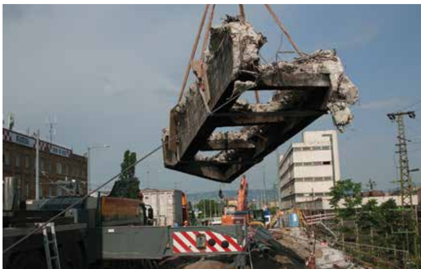
4. ábra. A fő- és keresztartó részek kiemelése autódaruval
