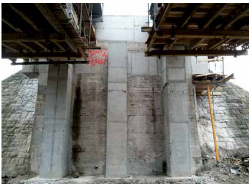
1. ábra. A VIII. hídfőnél elkészült erősítő bordák
