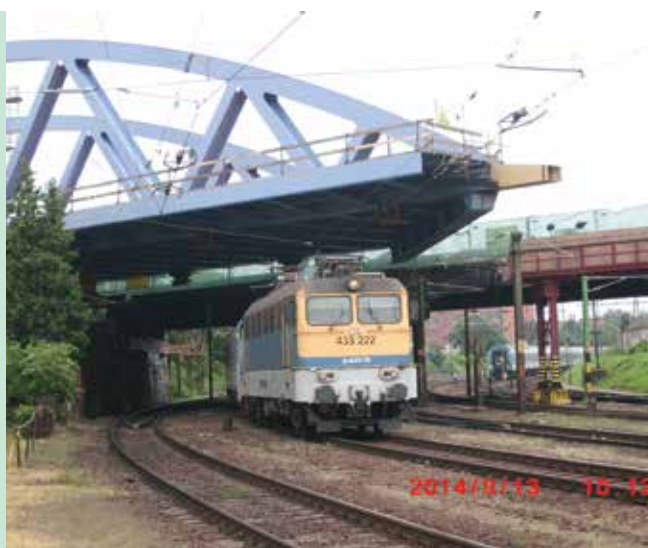
9. ábra. A felszerkezet betolása a vasút felett
