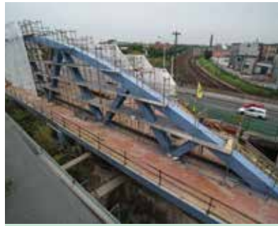
11. ábra. Korrózióvédelem készítése a betolás közben
