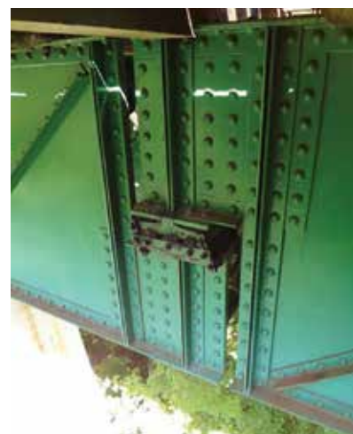
14. ábra. A befüggesztett rész mozgó saruja
