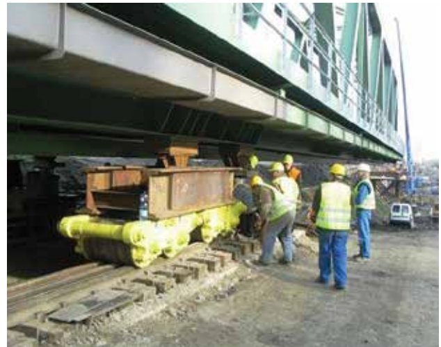
10. kép. A tolopályát sínen futó görgőkkel alakították ki, és villamos csörlő segítségével húzták keleti irányba Szajol felé az elkészült hidat, amelynek tömege elérte a 900 t-át
