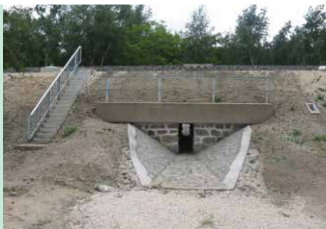
7. ábra. A 0,60 m nyílású kőfedlapos áterezsz a 311+23 szelvényben
