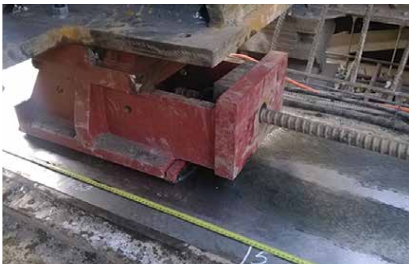
7. ábra. Az V. pilléren a „csúszószánkó” munka közben
