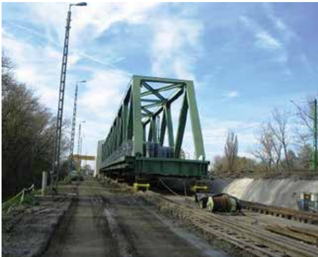
9. kép. A hídszerkezet alátámasztását jármokkal és segédjármokkal biztosították
