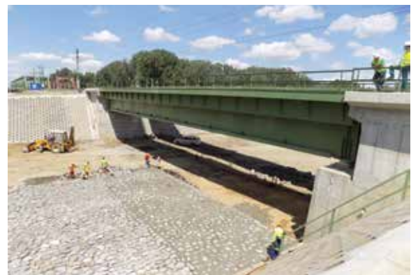
17. kép. Millér-Szajol bal vágányára elrendelt sebességkorlátozás idejére elkészült, és beemelték a 2 db új, egyenként 40 m-es ártéri szerkezetet a 1076-os szelvényben
