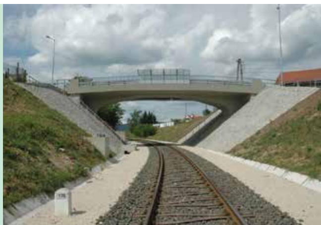
10. ábra. A 17,21 m nyílású monolit vasbeton lemez felszerkezetű, Kálvária utcai közúti felüljáró a 176+34 szelvényben
