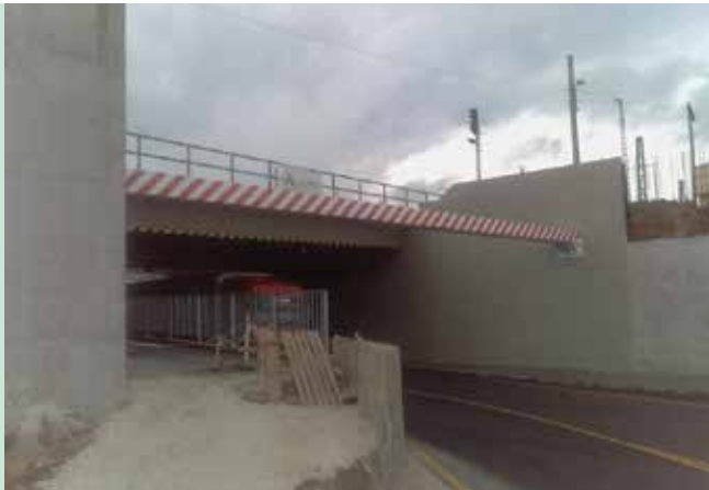
17. ábra. A 16,12 m nyílású tartóbetétes vasbeton lemezhid, Pilisvörösvár közötti aluljáró, valamint a kapcsolódó tám- és résfalak a 168+46 szelvényben
