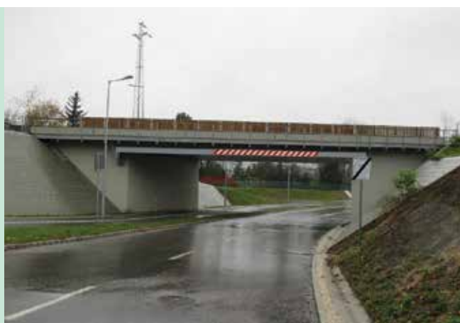
9. ábra. A 14,03 m nyílású tartóbetétes vasbeton lemezhid, József Attila utcai közúti aluljáró a 252+84 szelvényben
