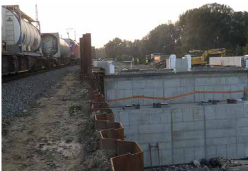
4. ábra. Az épülő hídfő (Fotó: Főmterv)
