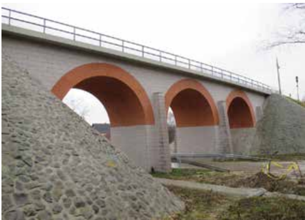
11. ábra. A 3 \times 7,60 m nyílású, Tó utcai boltozott híd a 172+56 szelvényben
