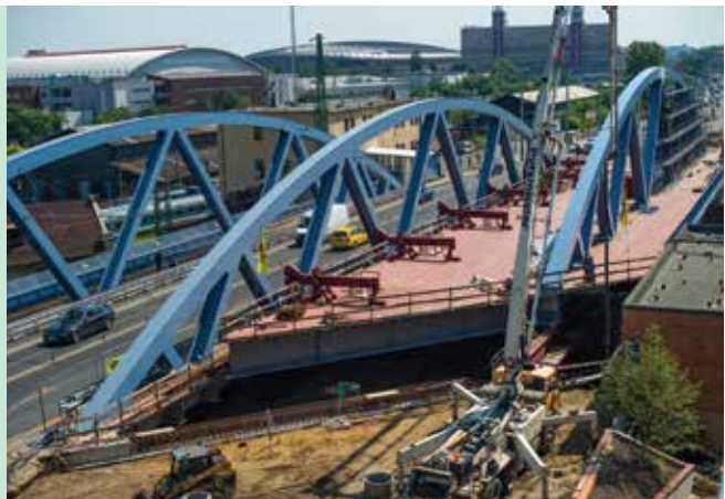
16. ábra. A déli oldali aszimmetrikus hídrész betolása
