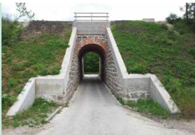
4. ábra. A 3,00 m nyílású, megerősített boltozat a 294+36 szelvényben
