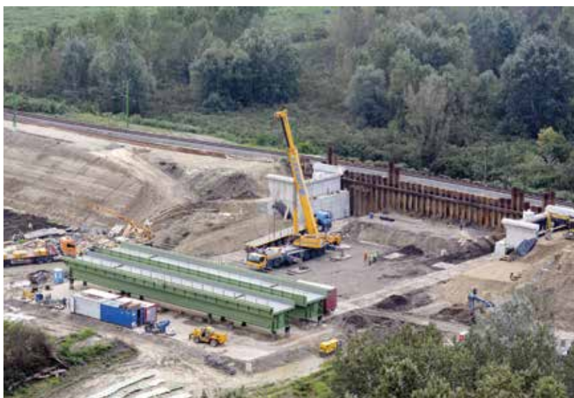
5. ábra. Szádfal és szerelőtér (Fotó: Mészáros János)
