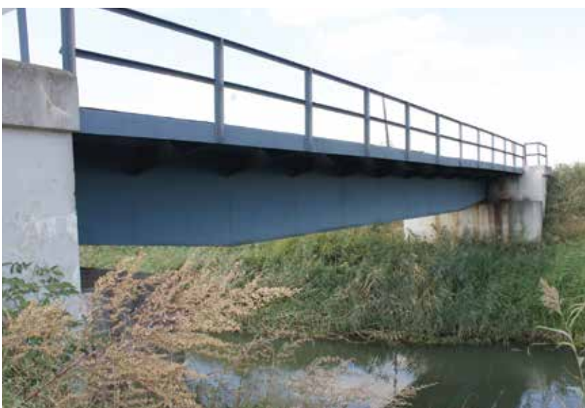
1. ábra. A bősárkányi Rábca-híd oldalnézete (Fotó: Gyurity Mátyás)
