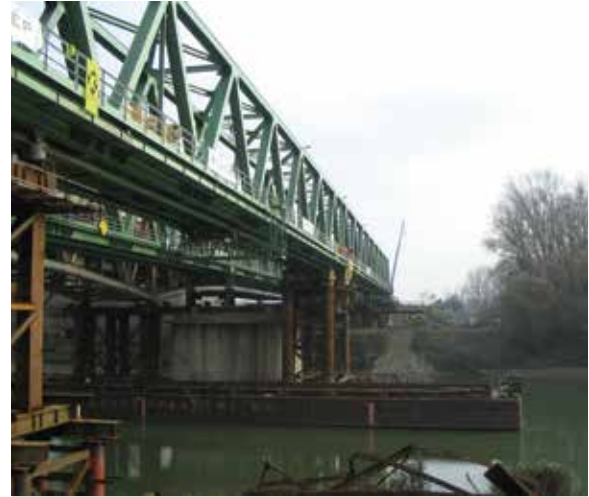
15. kép. A Tisza-híd másik, déli (jobb vágányos) szerkezete 2014. november 20-án került a helyére, majd a betolás 2014. november 29-én volt. A forgalomba helyezés 40 km/h sebességgel történt. Ezzel mind a két új Tisza-híd külön-külön egyvágányos szerkezettel üzembe állt, jelenleg már 80 km/h sebességgel közlekedhetnek rajta a vonatok.
