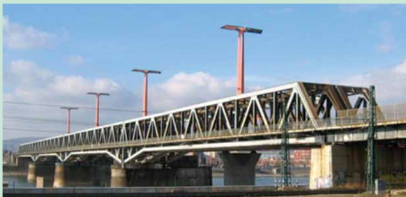
Déli összekötő vasúti Duna-híd
