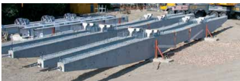
8. ábra. Előre gyártott, nagy szilárdságú feszített vasbeton keresztartók [10]
