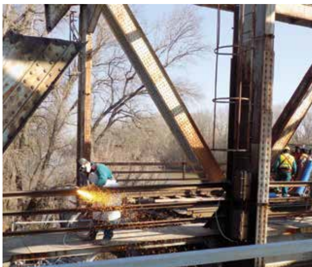
23. kép. A bontás hagyományos lángvágós technológiával folyik. A hídelemeket szállítható méretűre kell darabolni.
