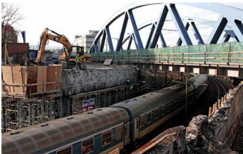
2. kép. Bontási munkák a második építési ütemben (Fotó: Szikszay Ágnes)
