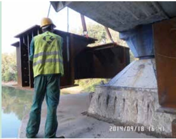
9. ábra. Mederpillér bennmaradó acélszerkezete
