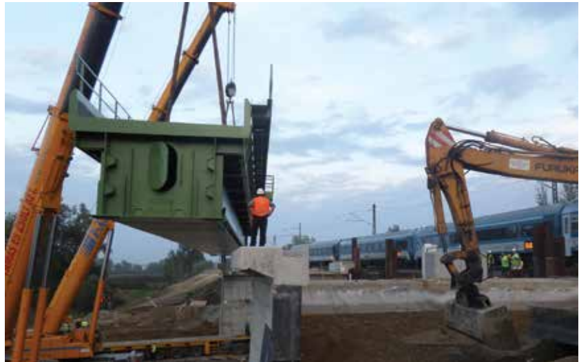
6. ábra. A felszerkezet beemelése (Fotó: Főmterv)
