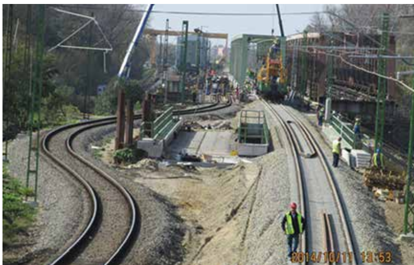
9. ábra. Az új ártéri híd a terelővágány mellett, háttérben az új mederhíddal
