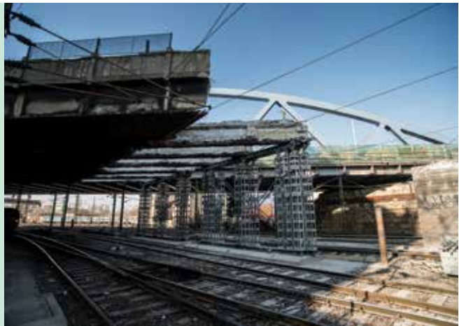
15. ábra. A részben elbontott híd alátámasztása nehézállvánnyal
