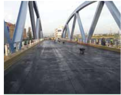
12. ábra. Befejező munkák a helyére került felszerkezeten
