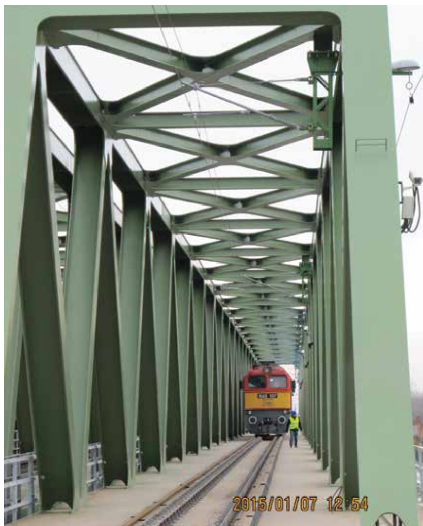
1. ábra. Mederhíd statikus próbaterhelése (Fotó: Barta János)
