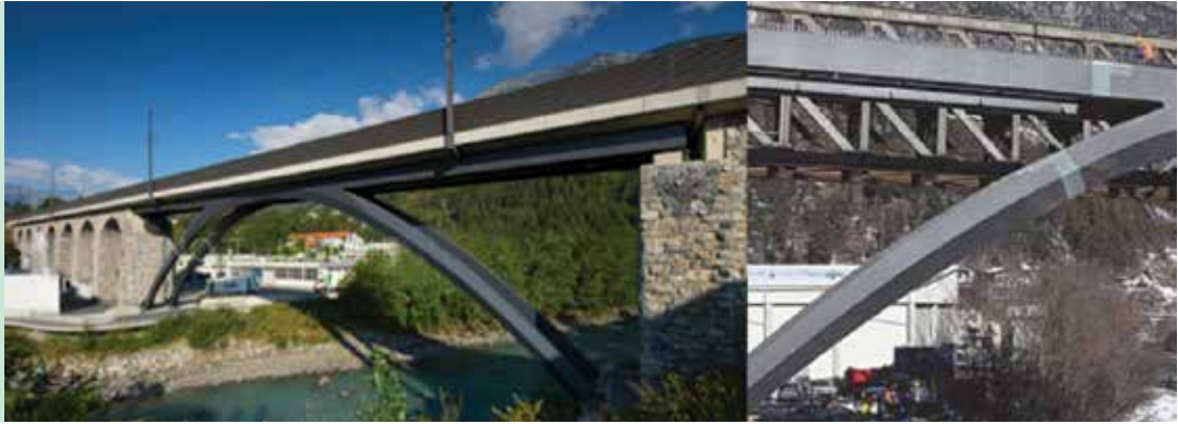
4. ábra. Híd az Inn folyó felett, Landeck (Ausztria) [9]
