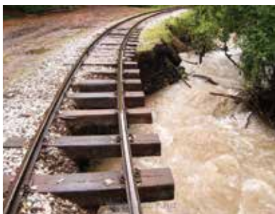
4. ábra. A 2006. júniusi árvíz kimosta a töltést
