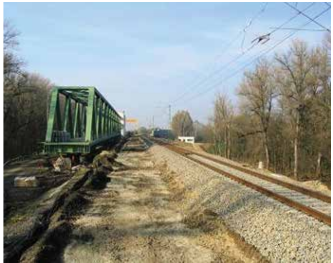
8. kép. A felületmázolás befejezése után folyamatosan húzták előre az új szerkezetet a Tisza-meder felé
