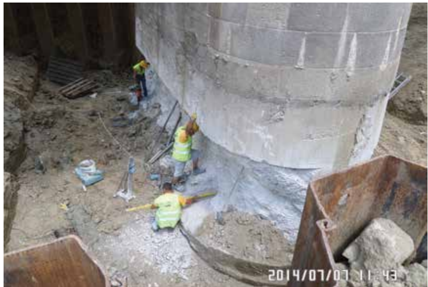
4. ábra. Pillérek erősítése/„gyengítése” forgalom alatt
