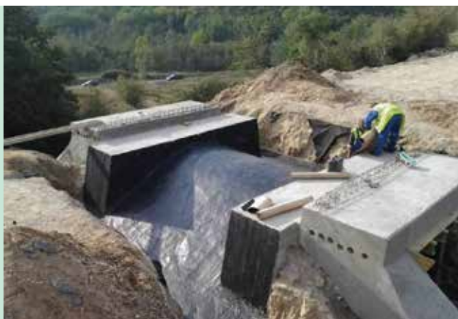
6. ábra. A 2,50 m nyílású boltozat megerősítése a 304+28 szelvényben
