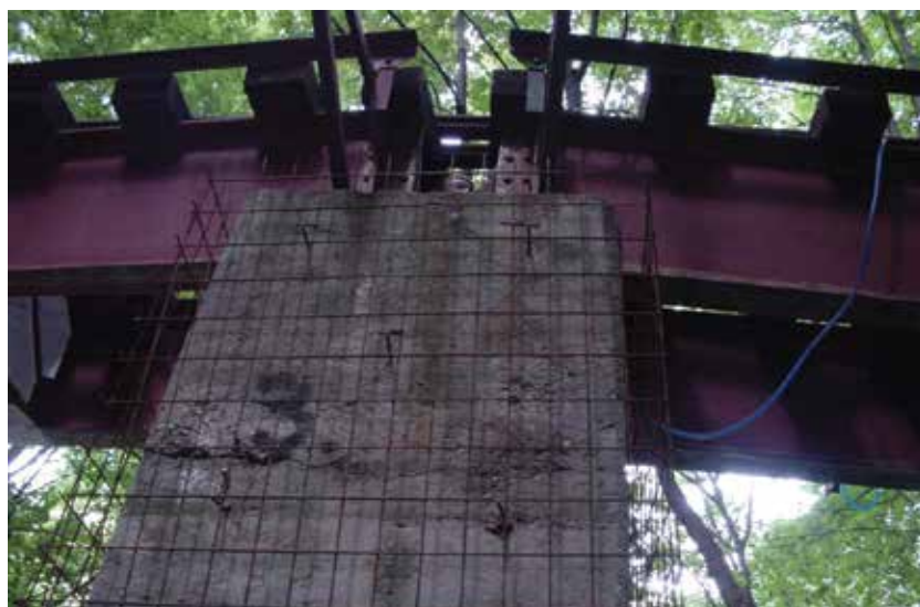
16. ábra. A Görbe híd pillérének megerősítése, 2002
