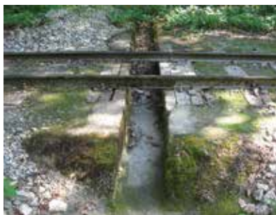
25. ábra. Nyílt átereszt – 0,3 m nyílású (100+03 hm szelv.)
