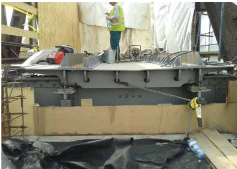
6. ábra. Az új pályalemez szerelés közben
