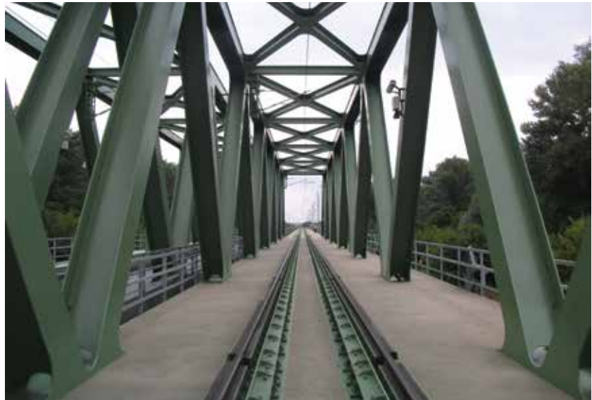
1. ábra. A kész mederhíd felszerkezete
