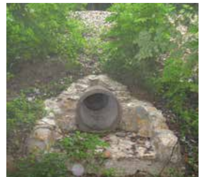
34. ábra. Új, 60 cm átmérőjű ROCLA csőátérés (64+76 hm szelv.)
