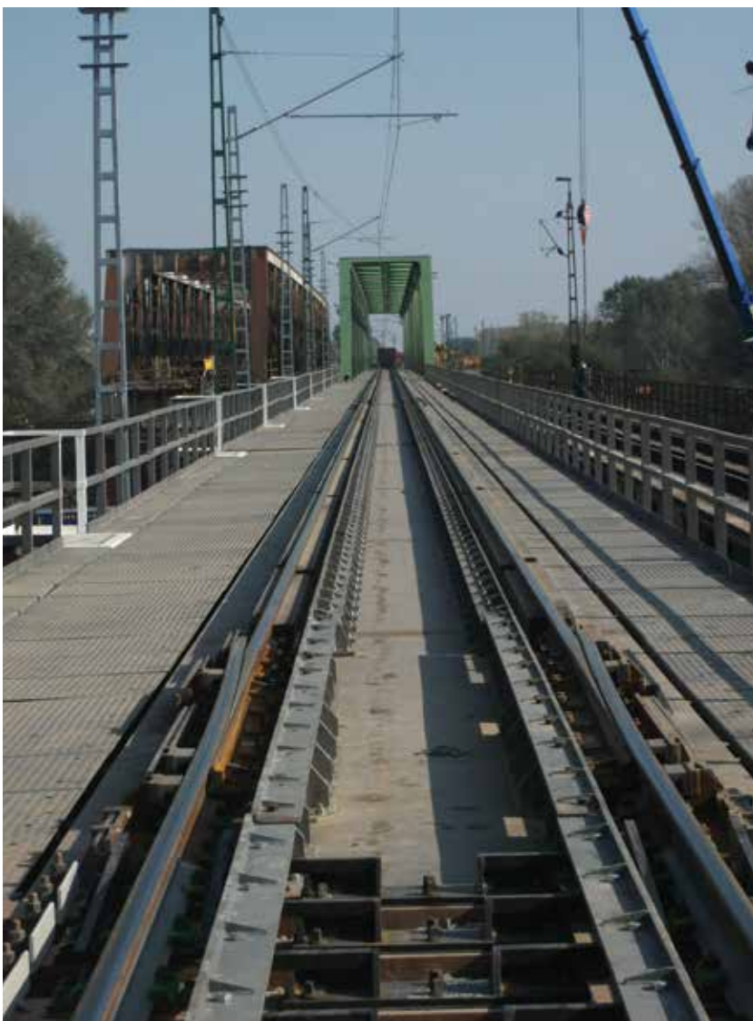
4. ábra. Síndilatációs szerkezetek
