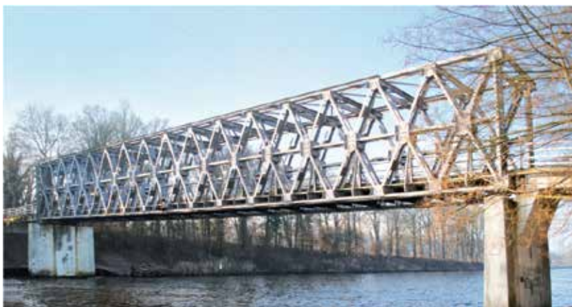
3. ábra. Ehzer-híd, Hollandia, 1945 (2007-ben, 42 év után mért horganybevonatvastagság: 69–219 \mu\text{m} ) [3]
