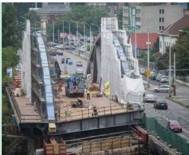
8. ábra. A betolásra kész felszerkezet
