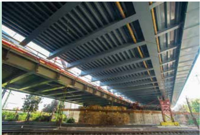
18. ábra. Helyszíni illesztésre váró keresztartók
