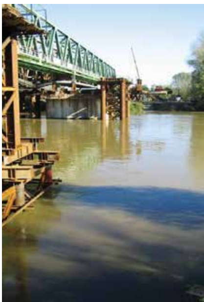
11. kép. Először az északi (bal vágányos) szerkezet hosszirányú mozgatása történt, itt aprólékos munkával kellett egyben mozgatni a nagy tömegű acélszerkezetet
