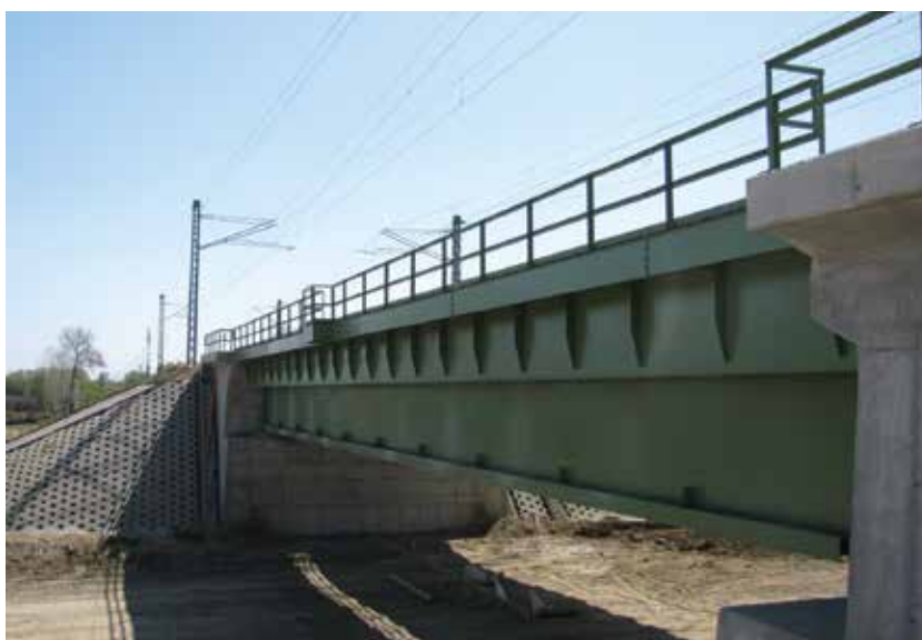
3. ábra. A szolnoki híd oldalnézete (Fotó: Gyurity Mátyás)
