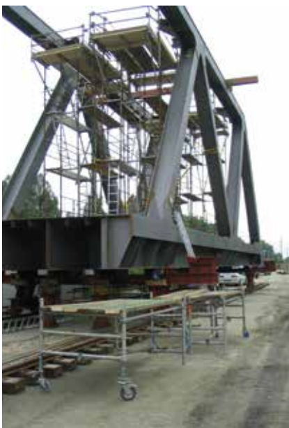
5. kép. A szerelőtérben 2014. május elején kezdődött a hídelemek érkeztetése, tárolása, összeállítása és hegesztése
