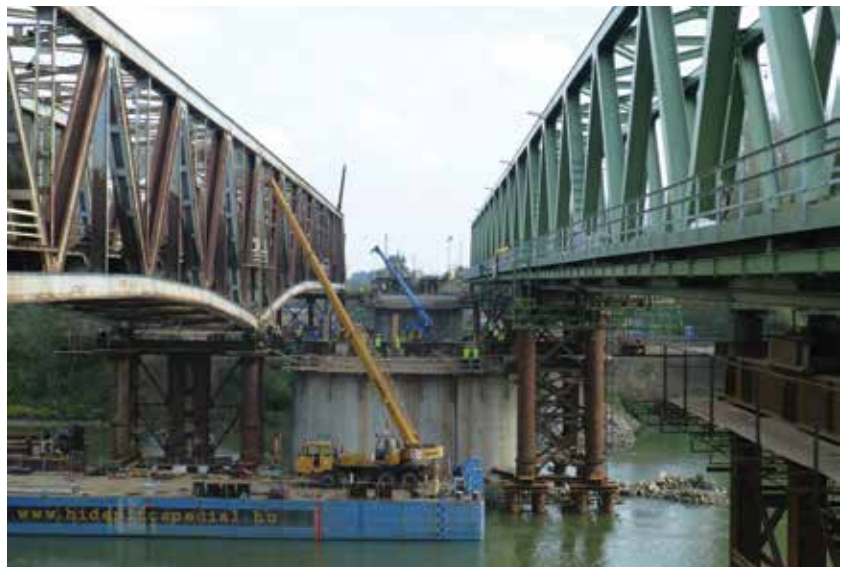
5. ábra. Hidak mozgatása közben
