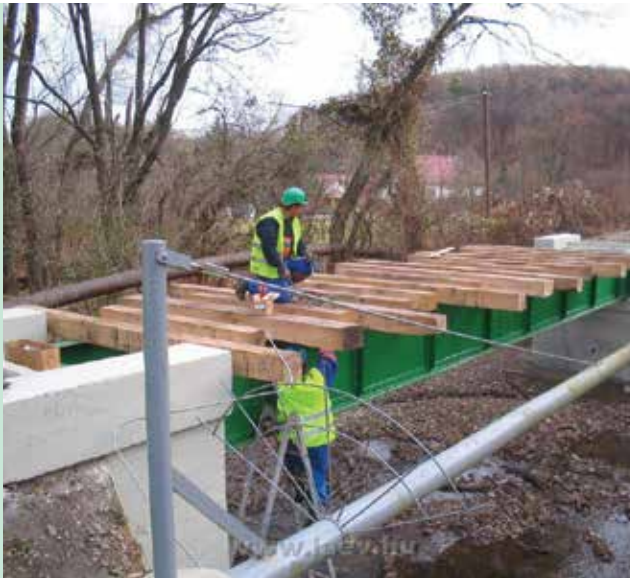
30. ábra. A mahócai szárnyvonalon lévő Szinva-híd felújítása, 2006
