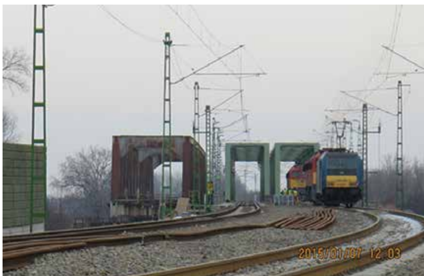
10. ábra. A próbatelhelés előkészületei
