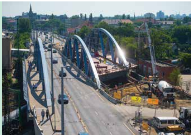
17. ábra. A helyére került déli oldal illesztése a már forgalomba helyezett északi hírhoz
