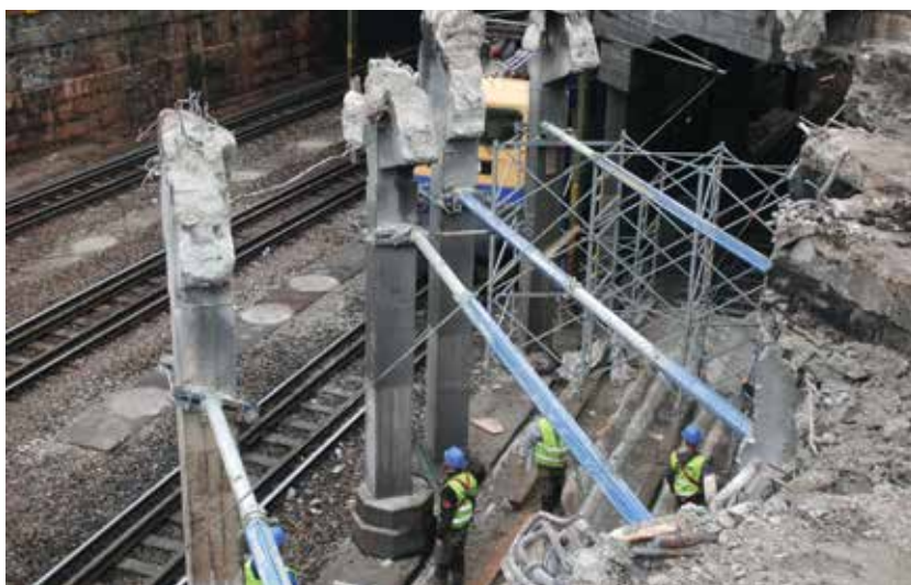
3. ábra. A bontásra váró pillérek ideiglenes megfogása
