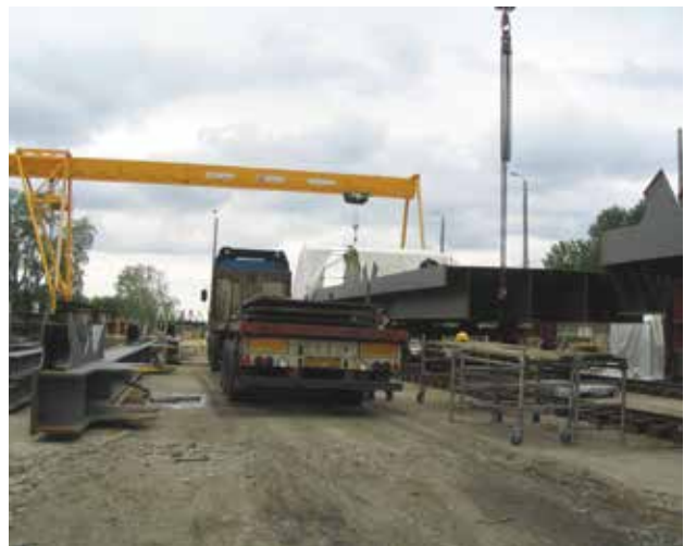
4. kép. A kábelkiváltásokkal egy időben megépült a szerelőtér Szolnok-Alcsi régi vasúti nyomvonal mellett (ez 600 m-re van a Tisza-medertől). A kiszolgáló emelőberendezés 2 db 20 t teherbírású bakdaru volt.
