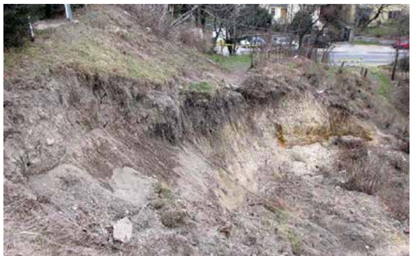
4. ábra. A rézsúcsúszás után kialakult meredek rézsű az Alsóhegy utca irányában
