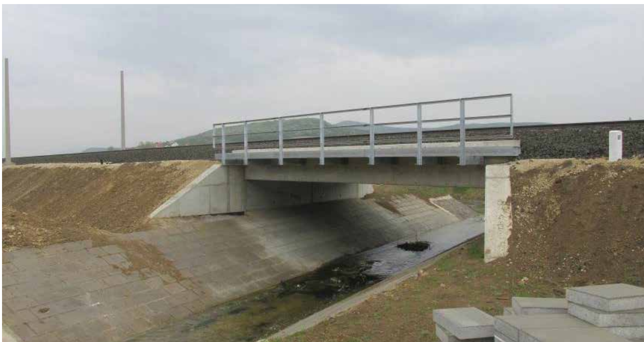
16. ábra. A 10,51 m nyílású, Aranyhegyi-patak feletti vasbeton lemezhid a 81+06 szelvényben
