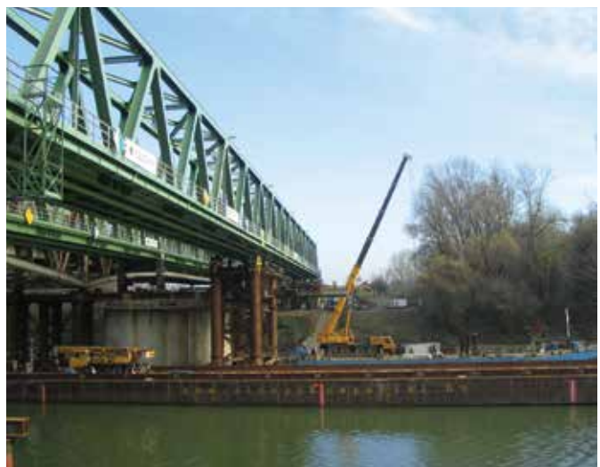
12. kép. Az elkészült 195 m-es hegesztett híd így került át a szajoli oldalra (bal part) 2014 szeptemberében
