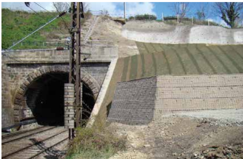
9. A megvalósult, ideiglenesen helyreállított részsű és alagútfalazat
