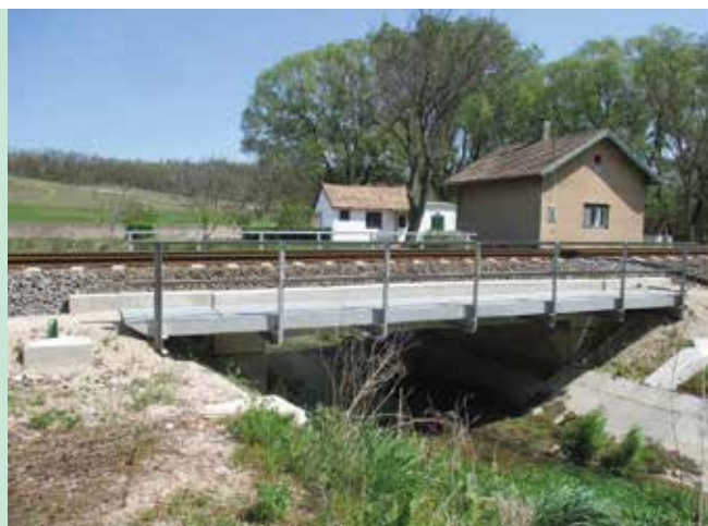
1. ábra. A 6,00 m nyílású, Kenyérmezői-patak feletti tartóbetétes vasbeton lemezhíd a 334+58 szelvényben
