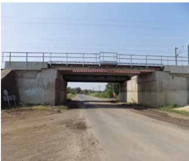
20. kép. A besenyszögi aluljárónál az acél hídszerkezetet kiváltották
