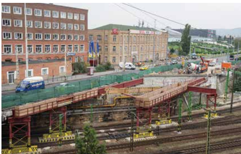
5. ábra. A tolopályaszakaszok beépítése
