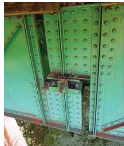
13. ábra. A befüggesztett rész fix saruja
