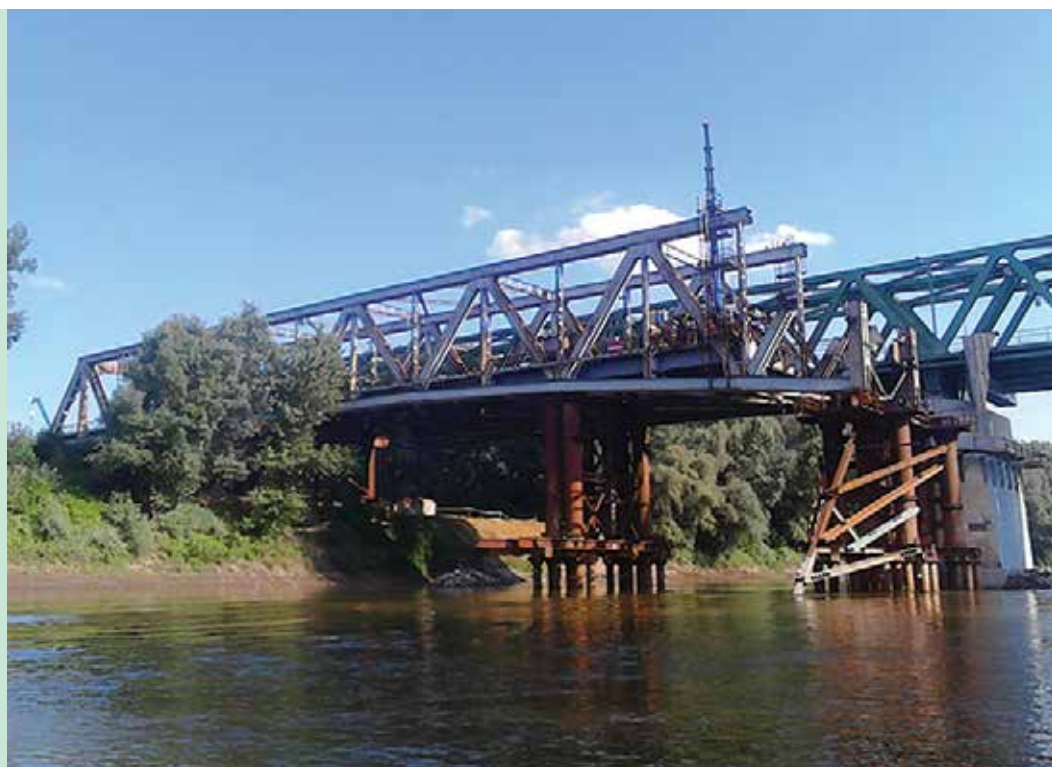
12. ábra. A régi hídszerkezet bontása: „már túl a felén”
