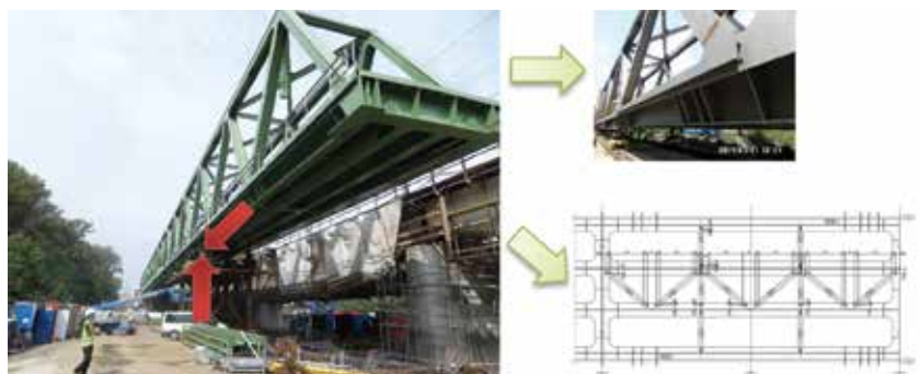
6. ábra. Konzolos állapot a jármok között
