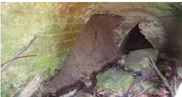
33. ábra. Beszakadt csőátérés (41+06,50)
