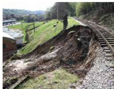
5. ábra. 2010-ben, a felhőszakadás miatt bekövetkezett rézsúcsúszás
