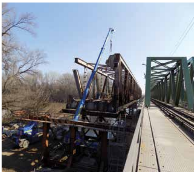
22. kép. A régi Tisza-híd bontása Szolnok felől kezdődött
