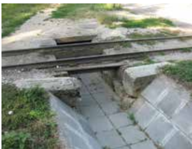
24. ábra. Fatartós átereszt – 1,0 m nyílású (14+62 hm szelv.)
