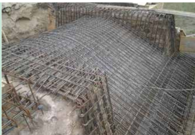
5. ábra. A 2,50 m nyílású boltozat megerősítése a 304+28 szelvényben
