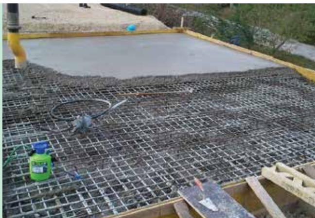
3. ábra. A 3,00 m nyílású boltozat megerősítése monolit vasbeton teherelosztó lemezzel a 294+36 szelvényben
