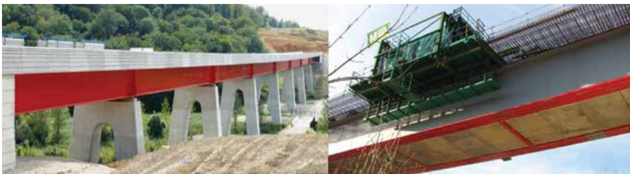
1. ábra. A Quenoche viadukt (TGV Rhine-Rhône) [7]
