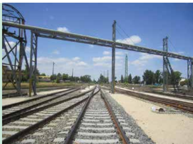
2. ábra. Az acél közmű védőhid az új vágányképhez igazodva, ferdekábeles felfüggesztéssel a 395+80 szelvényben
