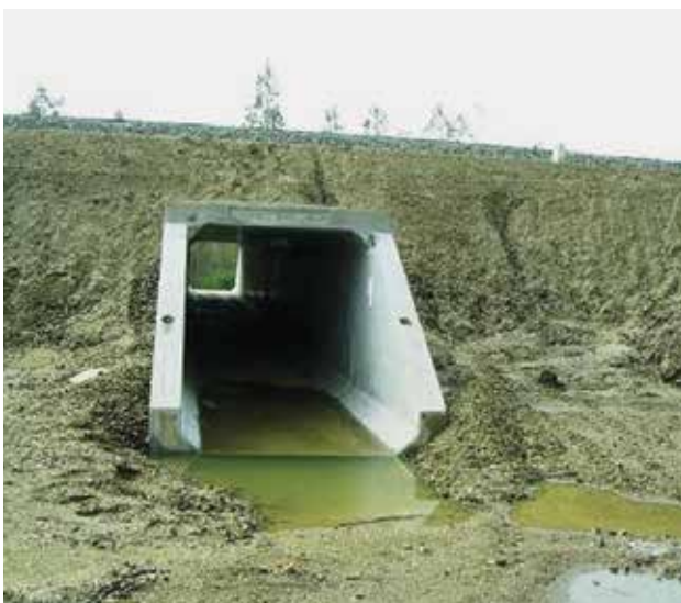
19. kép. Új vasbeton kerethíd épült a 1088-as szelvényben
