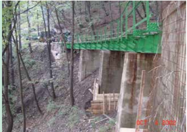
17. ábra. A Görbe híd felújítása, 2002
