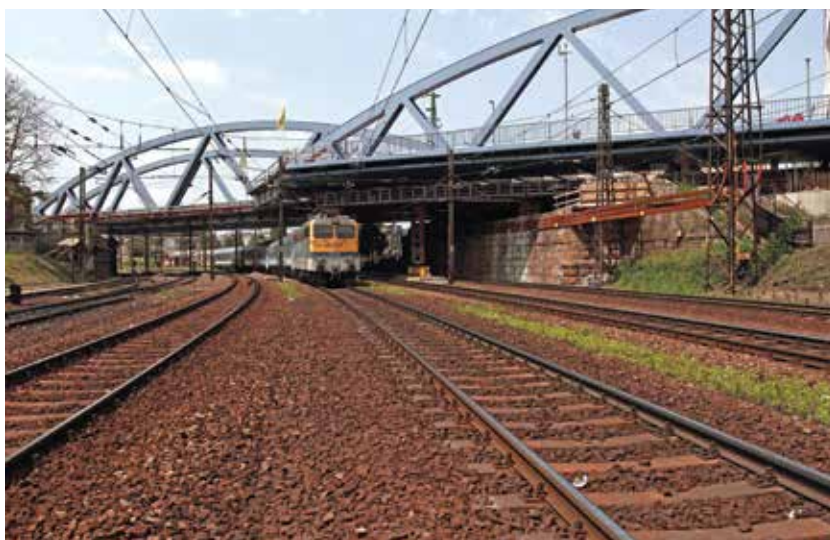
3. kép. A déli hídfél betolása a 2. építési ütemben, oldalról nézve (Fotó: Szikszay Ágnes)
