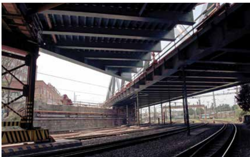
4. kép. A déli hídfél betolása a 2. építési ütemben, alulról nézve (Fotó: Szikszay Ágnes)
