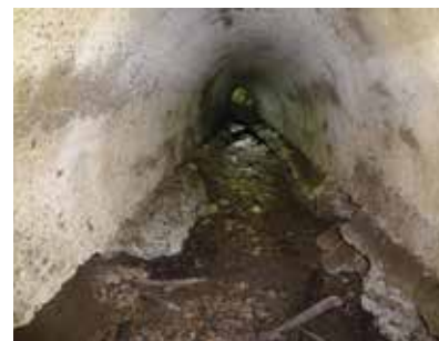
26. ábra. Csőátereszt alsó alaplemeze kimosódott (44+11 hm szelv.)
