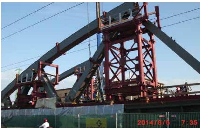
7. ábra. A rácsos főtartó helyszíni szerelése
