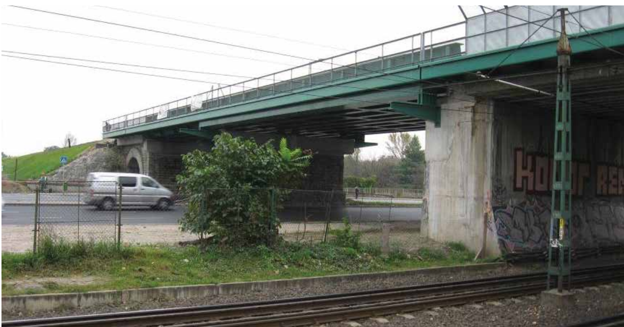
15. ábra. A 14,95 + 19,17 m nyílású, Szentendrei út feletti süllyesztett pályás gerinclemezes, folytatólagos háromtámaszú acélhíd a 37+82 szelvényben (építés alatti állapot)
