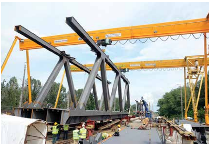
3. ábra. Szerelőtéren összeállítás
