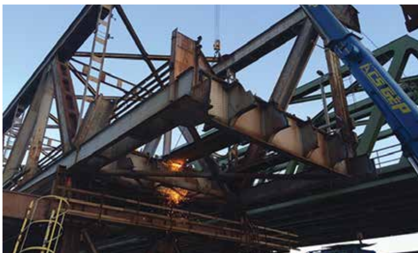
11. ábra. A régi hídszerkezet bontása: az első elemek vágása
