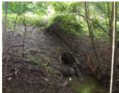
32. ábra. Alámosás az átérés kifolyási oldalán (33+53 hm szelv.)
