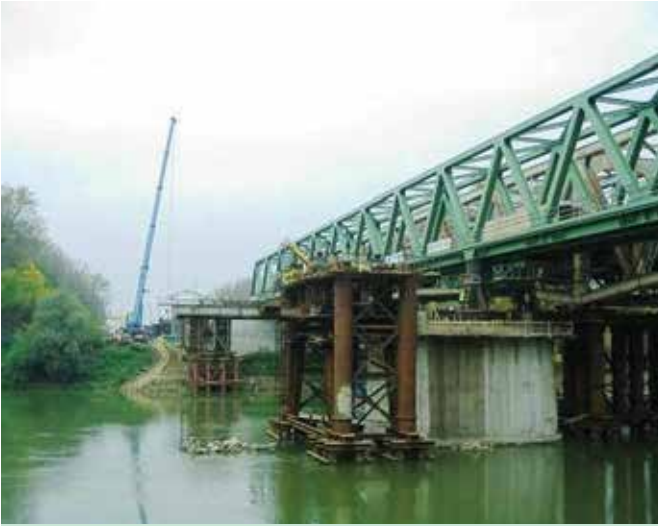
13. kép. Először a régi kétvágányos hidat kellett északi irányba kitolni a bontójármokra. 2014. október 6-án 6.30-kor a kitolás megtörtént. Másnap az új szerkezet betolása következett, ami már feleannyi ideig tartott, mivel oldalirányba kisebb távolságot kellett mozogni. Ez a művelet 2014. október 6-án 20.20-kor ért véget, és napközben 12 órát vett igénybe.
