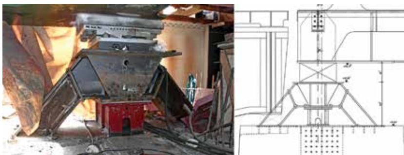
8. ábra. Parti támasz bennmaradó acélszerkezete
