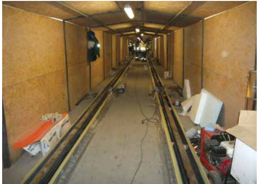
2. ábra. Hőszigetelt sátor a vágányépítéshez
