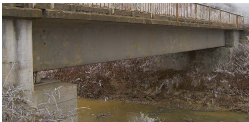
5. ábra – A recski Tarna-híd 2005-ben
