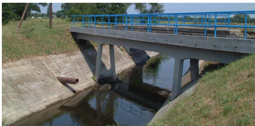
2. ábra – Az első közforgalmú vasúti vasbeton híd 2005-ben
