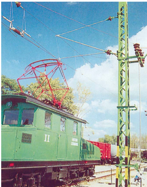
11. ábra – „F” típusú felsővezeték-tartó oszlop
