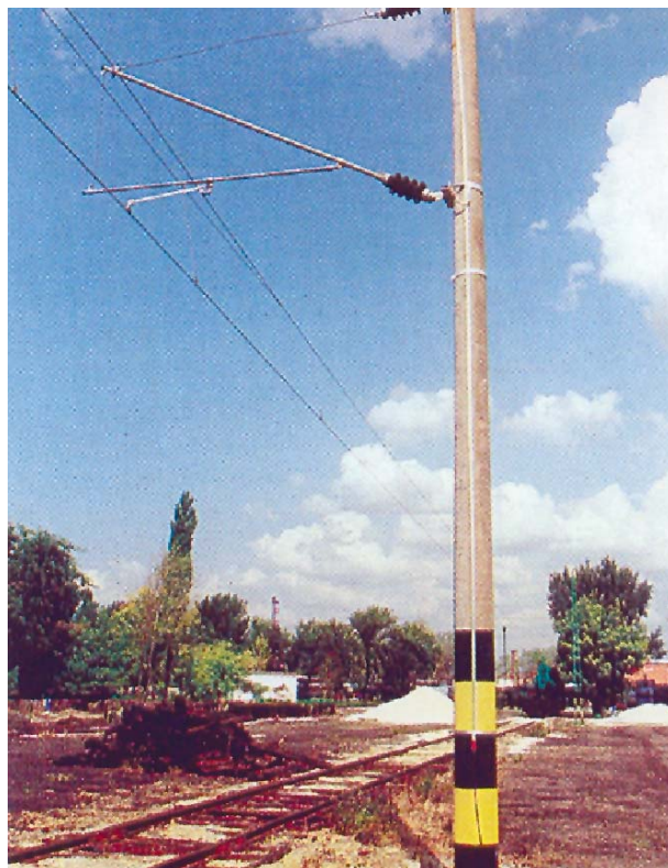
12. ábra – Körgyűrű-keresztmetszetű betonoszlop
