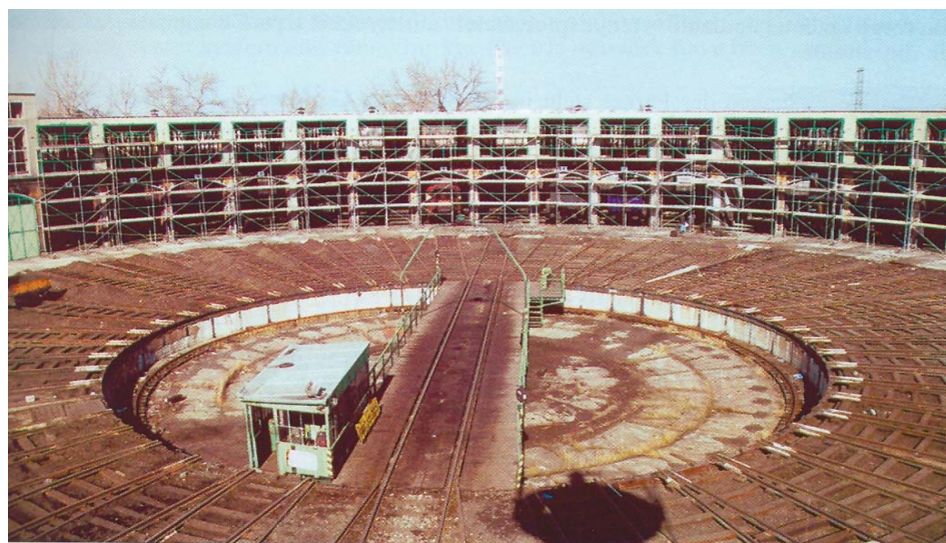
4. ábra – A körfűtőház felújítási munkái
