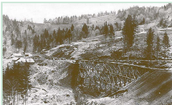
14. ábra – Brassó–Predeal-vonal felsőcsapjai híd építése
