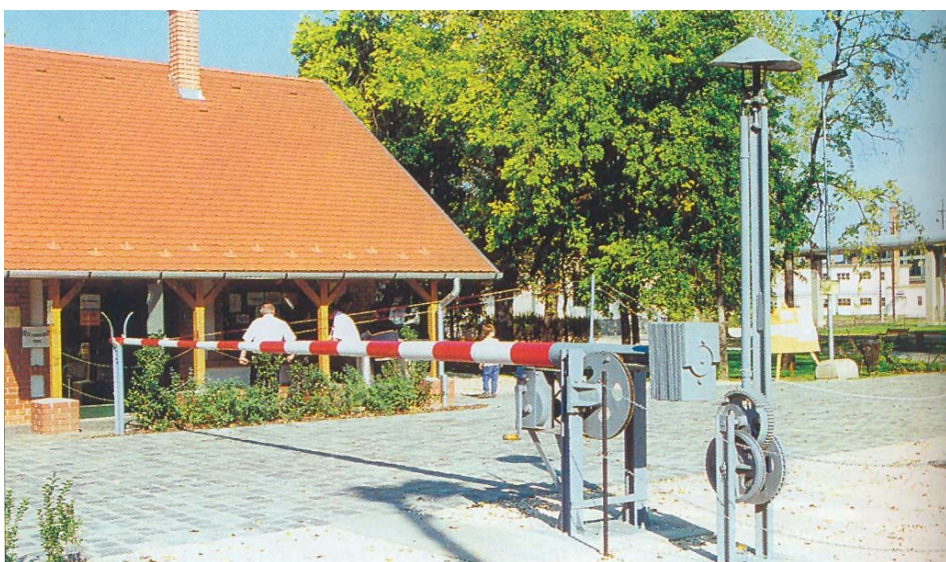
6. ábra – Bejáratú sorompó a portaépülettel
