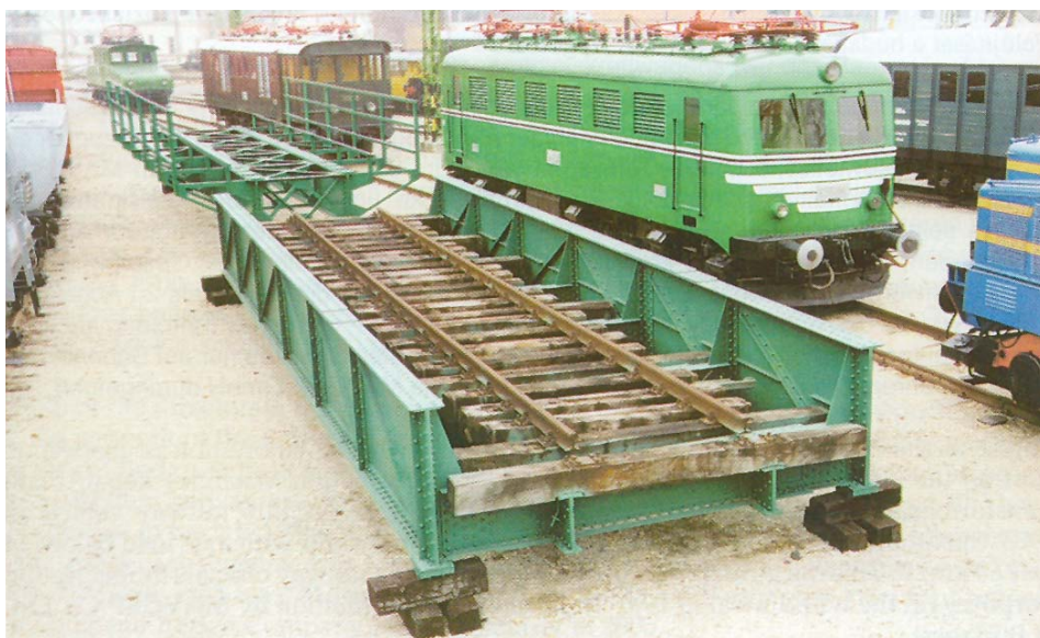
8. ábra – Vasúti hídszerkezet
