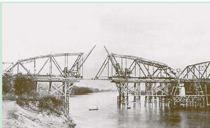
20. ábra – Dunaföldvári híd építése
