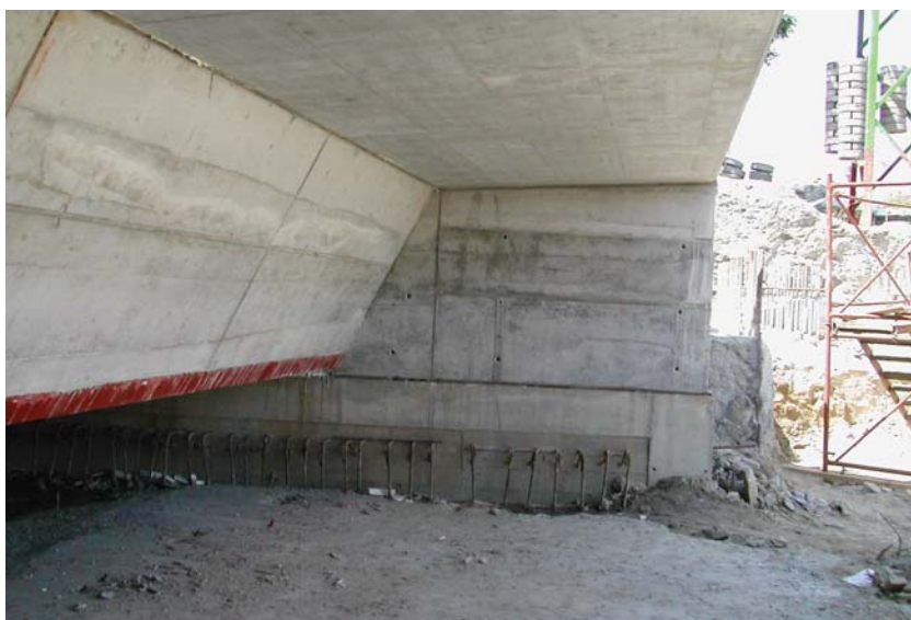
14. ábra – Elkészült felszerkezet (I. ütem)
