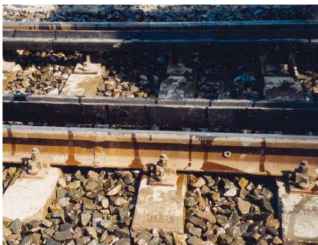
2. kép – A felső ágyazat felületi ragasztásának végeredménye
