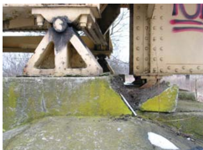
1 kép – A Kazincbarcika–Rudabánya vasútvonal 14+92 szelvényében többnyílású acélhíd közepő szerkezet végponti támaszánál szerkezeti gerenda lerepedése
