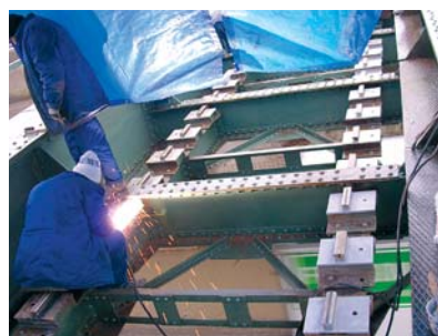
7. ábra – Hídfacsere a Szolnok-Besenyszögi úti hídnál
