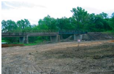
12. ábra – Provizorium az elbontott nyílásban
