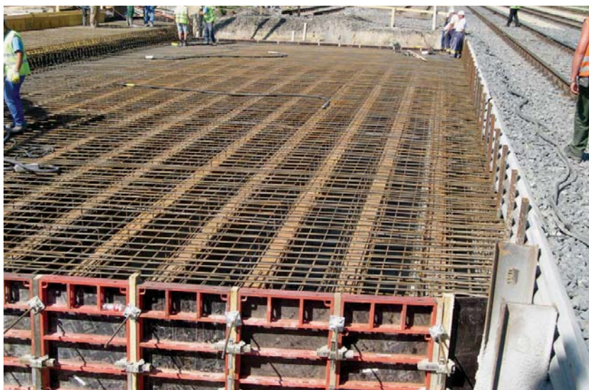
15. ábra – Felszerkezet betonozása (II. ütem)
