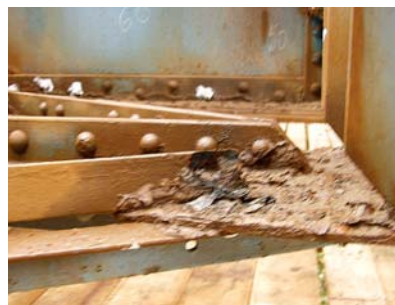
6. ábra – A szélrácsbekötés már nem működik
