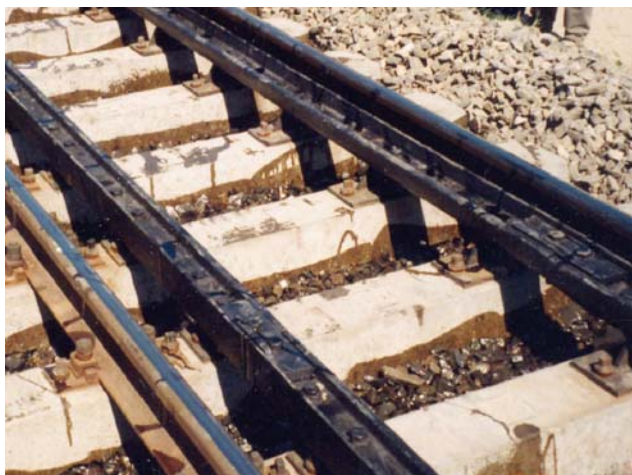
1. kép – Az alsó ágyazat alapragasztásának végeredménye
