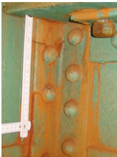
4. ábra – Fáradási repedés
