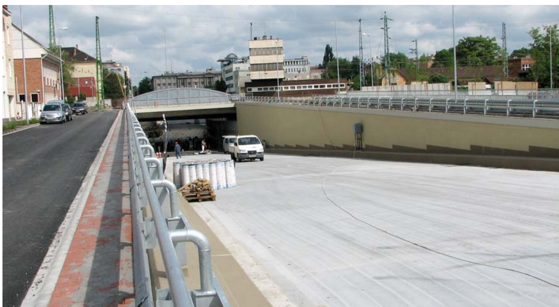
15. ábra – Felszerkezet betonozása (II. ütem)
