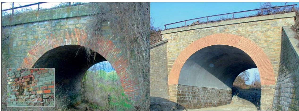
3. ábra. Pécsbányarendező–Magyarbóly vonal 43/44 sz., 5,70 m nyílású boltozott híd felújítása vékony lóttbeton kéreggel és injektálással
