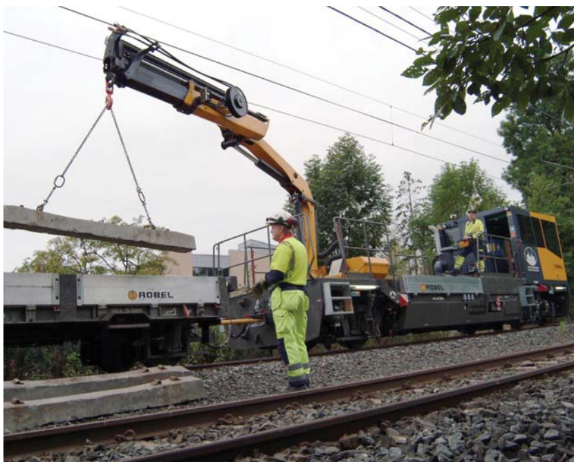
2. ábra. Az 54.17 típusú vágánygépjármű vasútépítési munkán
