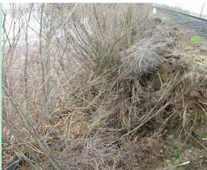
2. kép. Árvíz által rongálódott töltés
