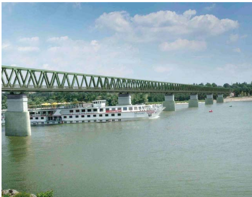
4. ábra. Meglévő K-szerkezet oldalnézete
