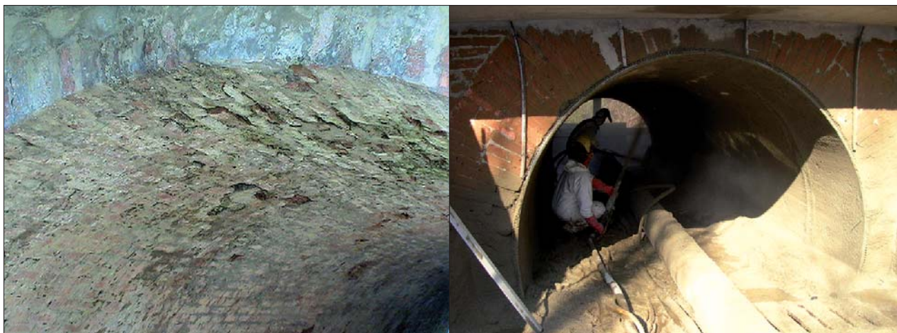
4. ábra. Pécsbányarendező–Barcs vonal 179+45 sz. 2,00 m nyílású boltozott átereszt felújítása vékony lőttbeton kéreggel
