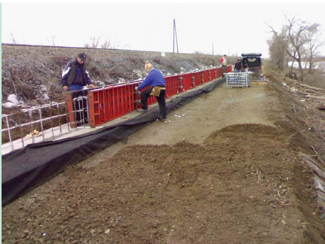
4. kép. Vasbeton gerenda építése
