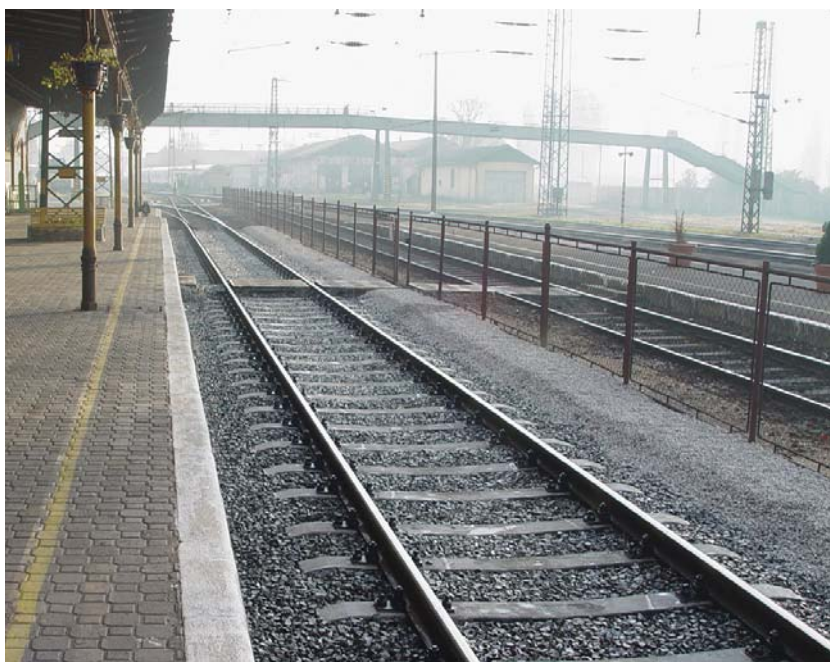
4. kép. Ragasztott ágyazat Pécs állomáson
