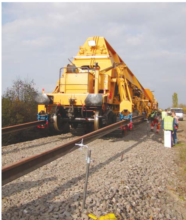
8. kép. SUZ-350 típusú fektetőszerelvény I.
