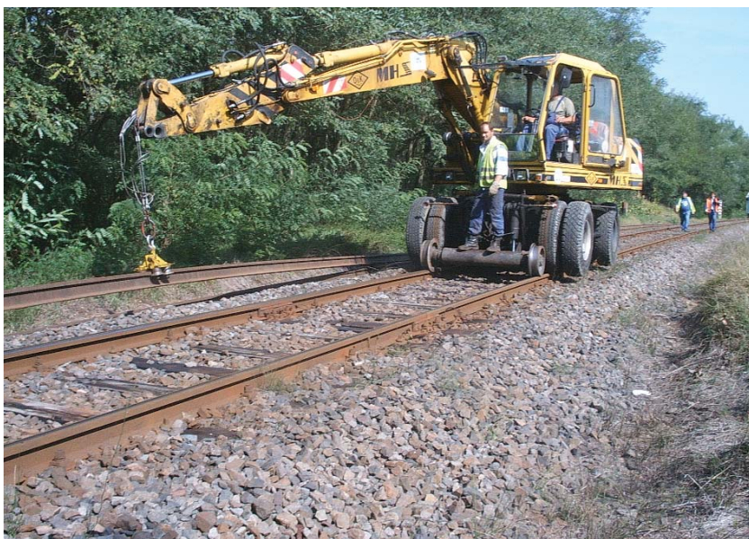
7. kép. A hosszúsín kihelyezése kotrógéppel
