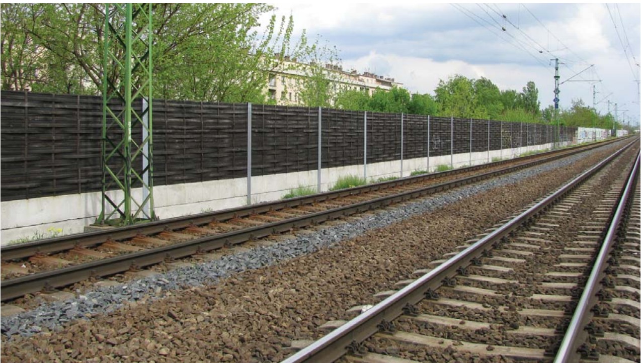
5. kép. Zajárnyékoló fallal védett lakóházak
