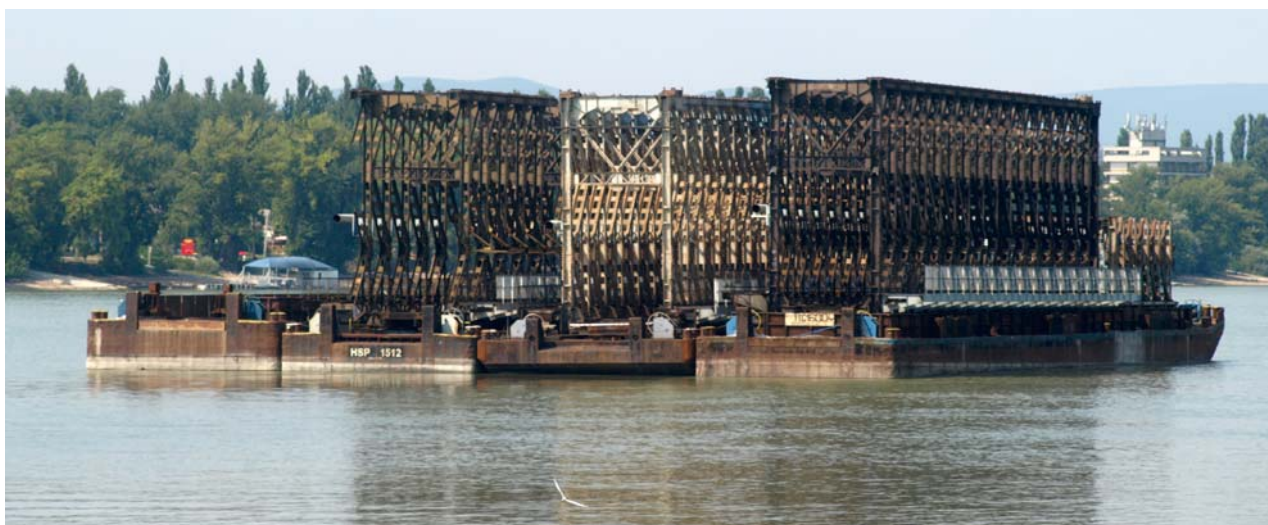
5. kép. A beépítési helyéről leemelt szerkezetek bárkára helyezés után küldetésüket teljesítve katonás rendben várják az elszállítást. Mennyi szén, brikett, kő, cement, betonelem, üvegáru, papírtermék, telített faáru, csillagó gépkocsi haladt át ezeken a szerkezeteken, hogy a Dorogi-medencéből az ország különböző részére jussanak. Az új hídszerkezet már más feladatokat lát el, mivel az áruszállítás helyett a személyforgalom gyors, kényelmes lebonyolítása lesz legfőbb feladata.
