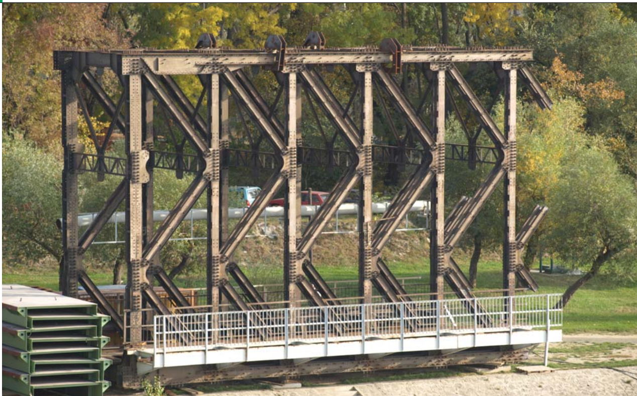
14. kép. Nem feledkezhettünk meg elődeinkről sem. Az általuk megtervezett és megépített hídszerkezet több mint ötven éven keresztül állta a sarat. Megérdemli, hogy a jövő generációja is megismerje a történelmét. Ennek érdekében a híd egy darabját (négy keretállást) a Vasúttörténeti Park területén tervezünk felállítani az esztergomi vasútvonal vágányai mellett. Ezzel szeretnénk emléket állítani azoknak, akik az előző „K” hídszerkezetet tervezték, építették és üzemeltették. ◀◀
