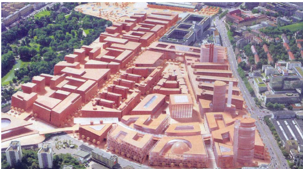
2. ábra. A mélypályaudvar felett a jelenlegi fejpályaudvar helyén épülő új üzleti negyed
