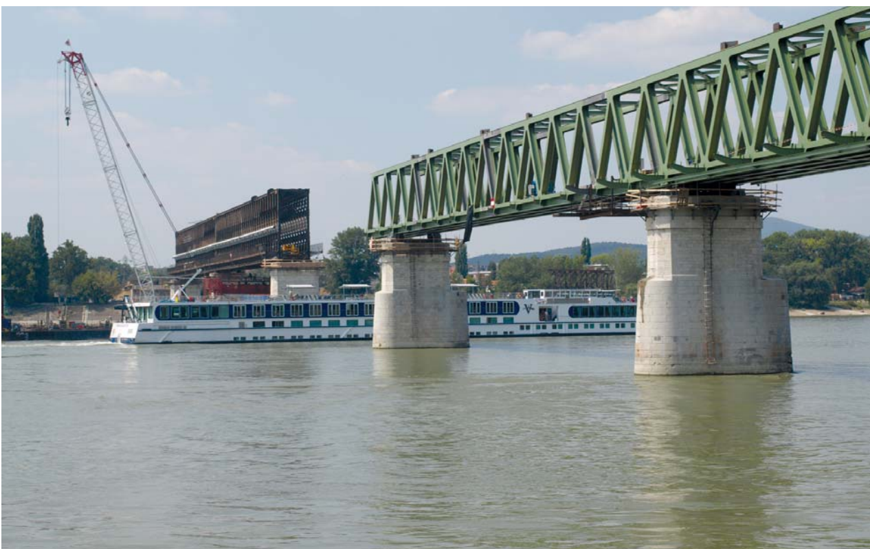
3. kép. A híd felszerkezetének átépítését megelőzően megerősített hídpillérek nem sokat pihenhettek. A régi szerkezetek leemelése és bárkára helyezése után rövid időn belül helyükre kerültek az új felszerkezeti elemek. Ezek az elemek már korszerű hídsarukra támaszkodnak, és szerkezeti kialakításukkal kedvezőbb hajózási űrszelvényt tesznek lehetővé. Ez utóbbinak elengedhetetlen feltétele volt a hídon a hosszszelvény megfelelő lekerekítéssel történő megemelése és rugalmasan ágyazott pályáátvezetéssel a szerkezeti magasság csökkentése.
