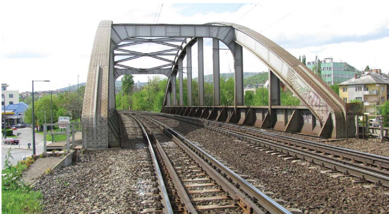
3. kép. Ágyazátátvezetéses vasúti híd
