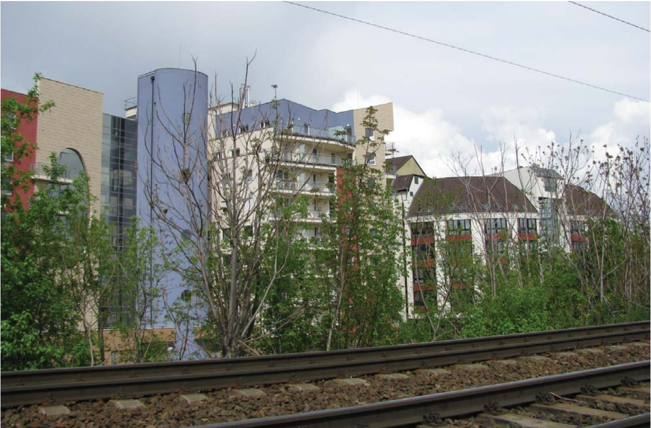
4. kép. Hamzsabégi úti beépítés
