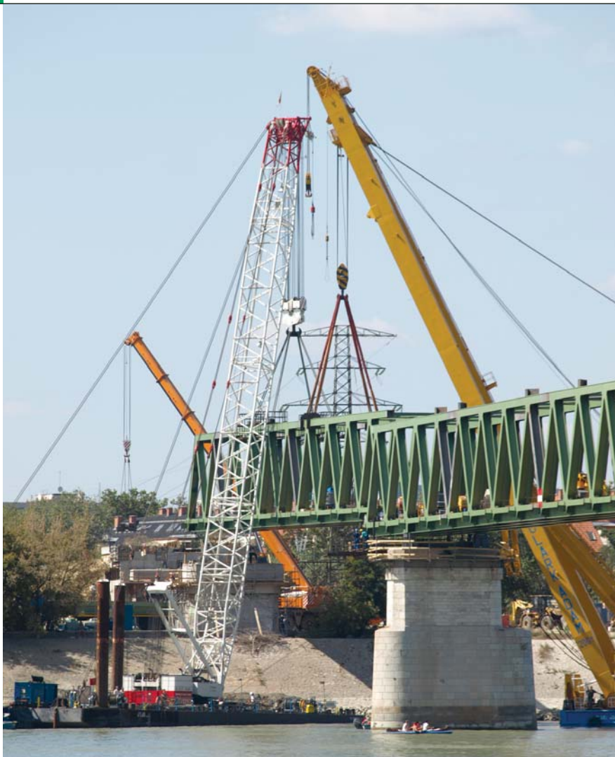
10. kép. Az utolsó elem beemelése 2008. augusztus 30-án történt. Az ilyen rövid idő alatt elkészült híd építése csak alapos előkészítéssel, szervezett munkavégzéssel, a tervező-beruházó, üzemeltető és kivitelező szoros és kiváló együttműködésével valósulhat meg. Ezzel 54 év után először épült vasúti hídszerkezet a Dunán. Megszületett hát a tervezők és kivitelezők munkája nyomán a négy vasúti Duna-híd közül a legifjabb, legkarcsúbb szerkezet.
