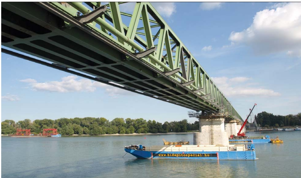
12. kép. Az utolsó elem beemelésével összeért a két partot összekötő hídszerkezet, de a hidászokra még nagyon sok feladat várt, hogy szeptemberben megindulhasson a vasúti forgalom a hídon. Nem véletlen, hogy a látványos ünneplés helyett szorgosan végezték a dolgukat.
