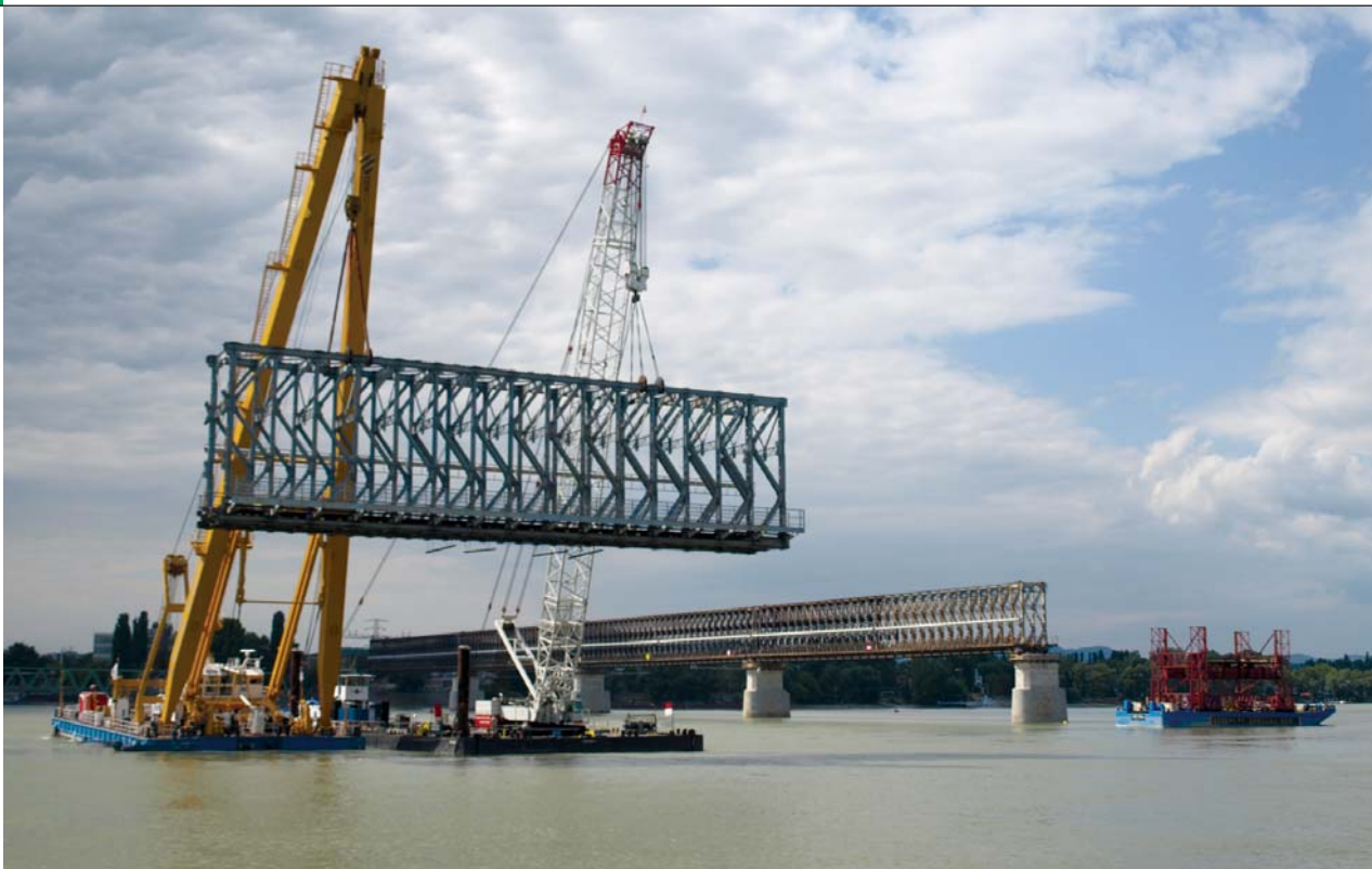
2. kép. A híd bontását óraműpontossággal együtt dolgozó úszódaruk, a Clark Ádám és az Atlas végezték. A bontott elemek elszállítását végző bárkák, vontatóhajók és úszódaruk mozgása a vízi balettre emlékeztet. A híd építését szemlélő érdeklődők talán nem is sejtették, hogy egy-egy emelési művelet előtt sokszor mekkora izgalmat jelentett egy szeles vagy csapadékos időjárás, és milyen feladatot a vízen közlekedő közforgalmú vízi járművek forgalmának fenntartása.
