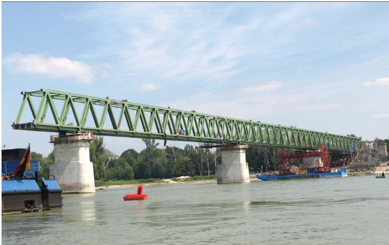
4. kép. A nagyobb szerelési egységekben összeszerelt és beemelt hídszakaszok látványos és gyors előrehaladást tettek lehetővé. A híd helyén korábban megépült és most elbontott hídszerkezet építésénél ez a módszer még nem volt ismeretes, így hatalmas állványzatra volt szükség a Duna-mederben, amelyen helyszínen összeállítva, egy nyílástól kiindulva konzolosan haladt a híd további szerelése. Természetesen az akkori módszer hosszabb építési időt és a hajóforgalom számára nagyobb akadályoztatást jelentett.
