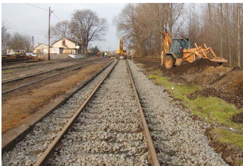
12. kép. Nyírmada III. vágány átépítése
