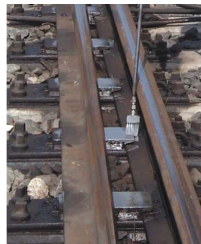
3. ábra. A magas szilárd anyag tartalmú kenőanyag használata megszünteti az ágyazati kövek szennyeződését
