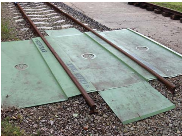
21. kép. Olajszennyeződés megelőzése olajfogó tálca felszerelésével
