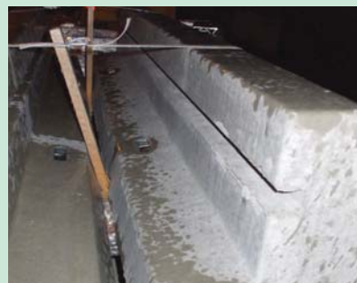
3. ábra. A ponthoz való T-szegélyborda, a különleges nűttal
