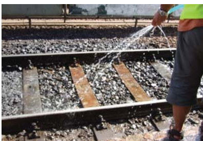
10. kép. Az ágyazat portól történő megtisztítása vizes mosással
