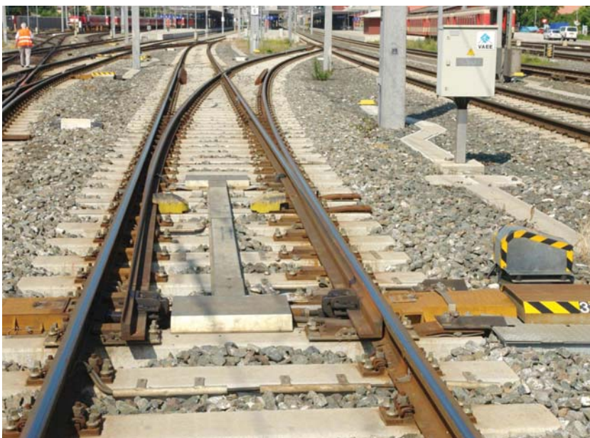
7. kép. 500-as rendszerű kitérővel kialakított vágánykapcsolás Klagenfurt állomáson
