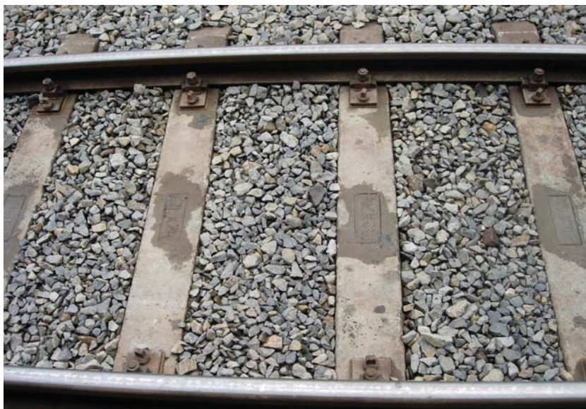
11. kép. A ragasztásra előkészített apróbb szemű felső ágyazati réteg
