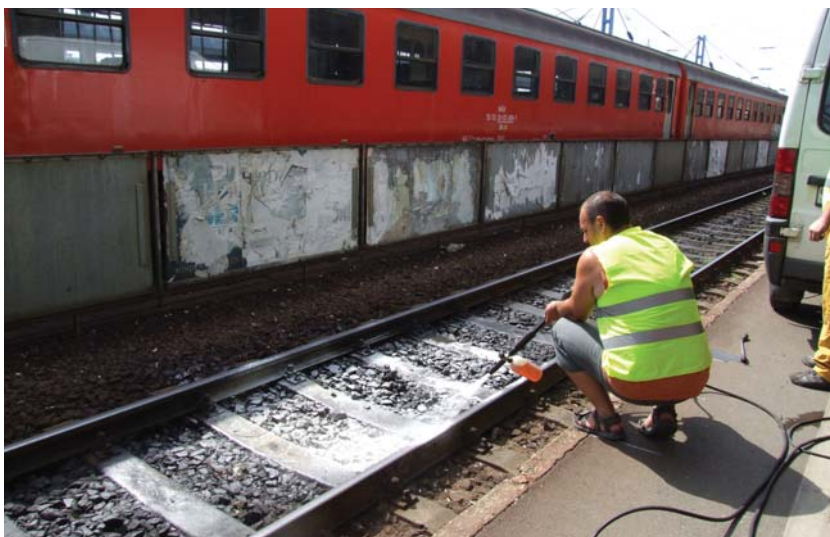
6. kép. Az enzimes porlasztás végrehajtása gőzborotva segítségével
