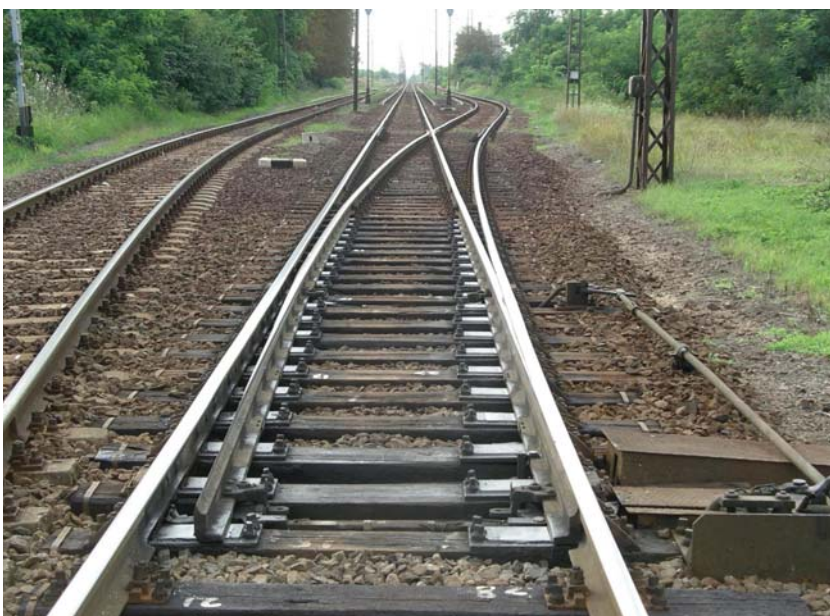
8. kép. A Tiszatenyő–Mezőtúr-vonalszakasz átépítése előtt, a régi Pusztapó állomáson az 54 500 1:14 rendszerű kitérő
