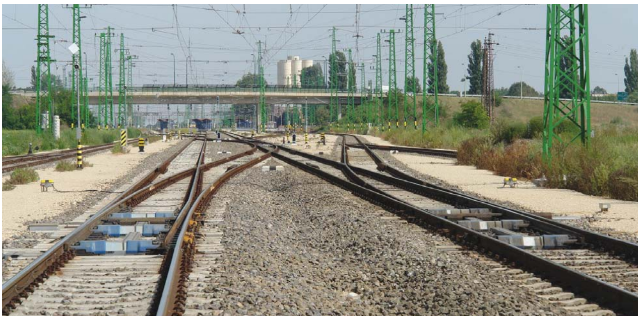
10. kép. 60-800 r. kitérőkkel kialakított elágazás Cegléd állomáson
