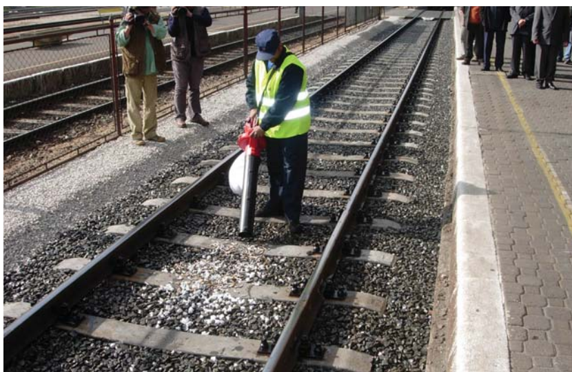
19. kép. Ipari porszívóval történő tisztítás (1)
