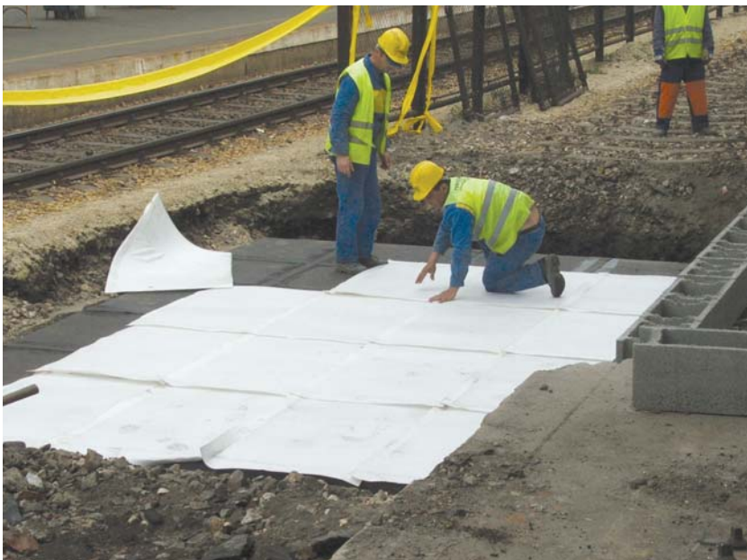
2. kép. Beépítés Győr állomáson
