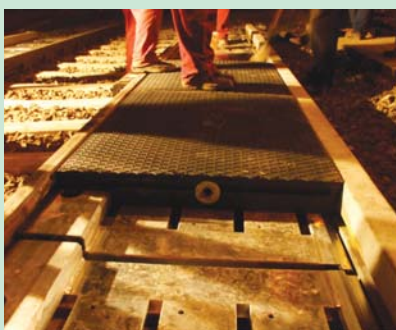
8. ábra. A gumi elemek „szokásos” egymáshoz rögzítése
