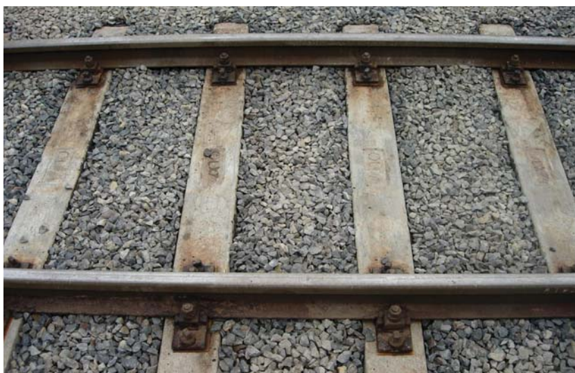
12. kép. A ragasztás előtt tömörített felső ágyazati réteg
