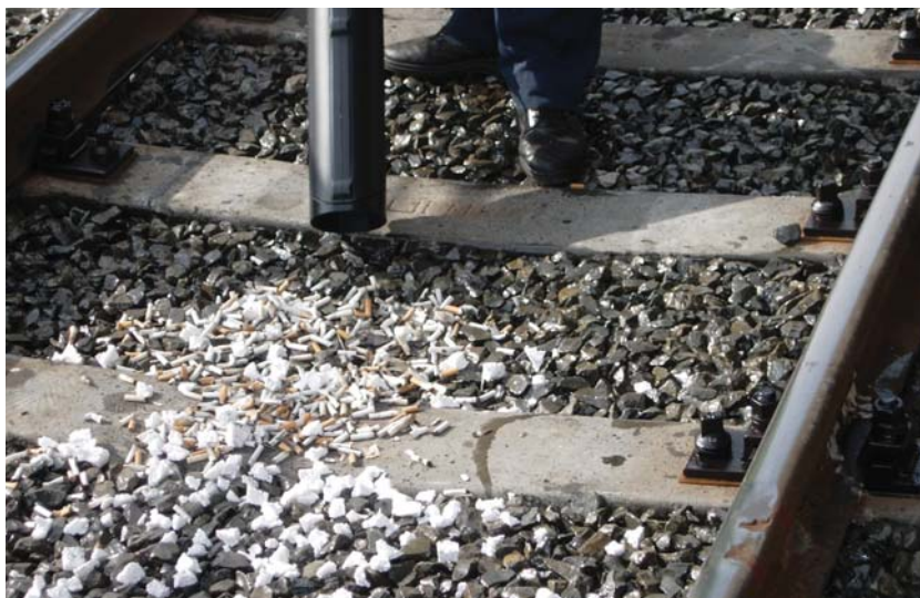
20. kép. Ipari porszívóval történő tisztítás (2)
