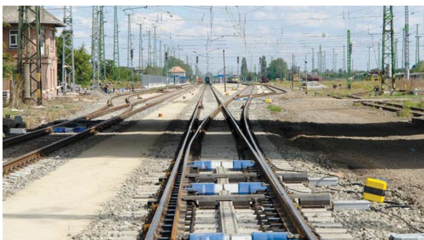
12. kép. 60-1800 rendszerű kitérőkkel kialakított vágányelágazás Szajol állomáson
