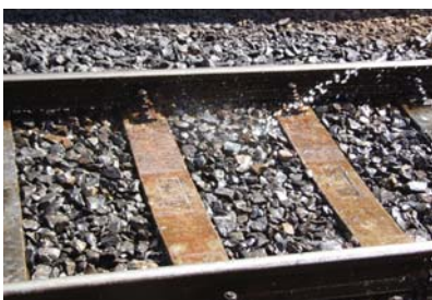
9. kép. Az olajszennyezéstől mentesített vasúti vágány
