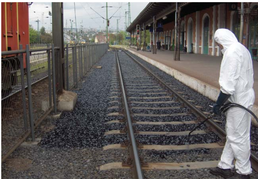
14. kép. A felületi ágyazatragasztás elvégzése gépi technológiával (2)
