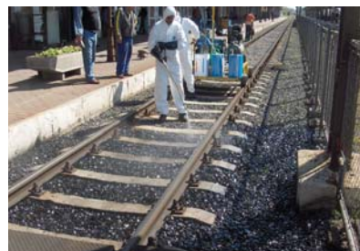
13. kép. A felületi ágyazatragasztás elvégzése gépi technológiával (1)
