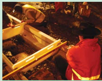
4. ábra. A szegélybordák 0,5 cm pontos beállítását segítik a műanyag sablonok
