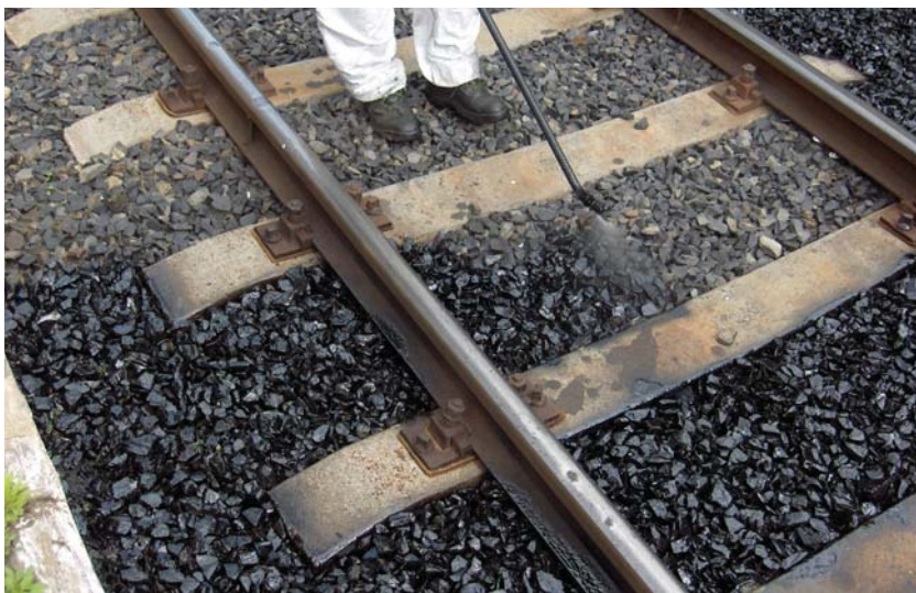
15. kép. A felületi ágyazatragasztás elvégzése gépi technológiával (3)
