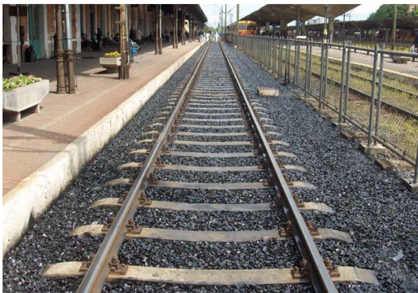
18. kép. Az állomási vágányban elvégzett felületi ragasztás végeredménye (3)
