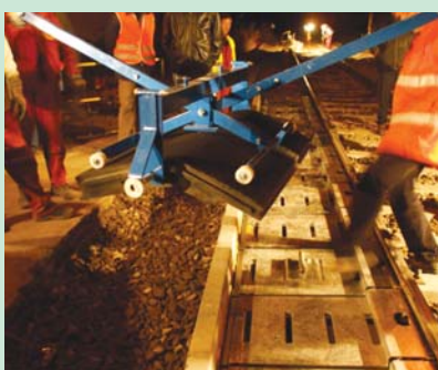
7. ábra. A gumi elemek beemelése
