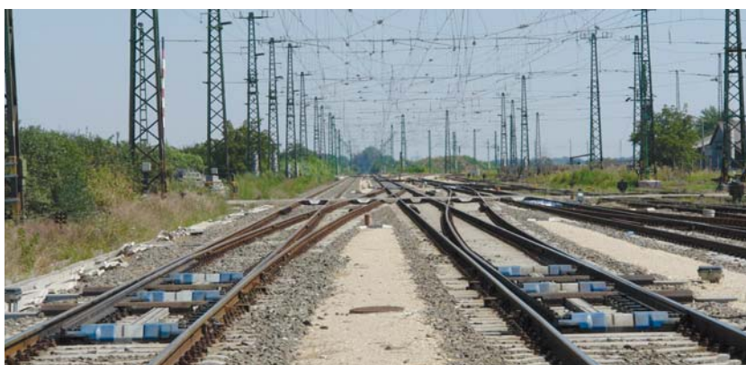
11. kép. 60-1800 rendszerű kitérőkkel kialakított vágánykapcsolások és elágazás Szajol állomáson
