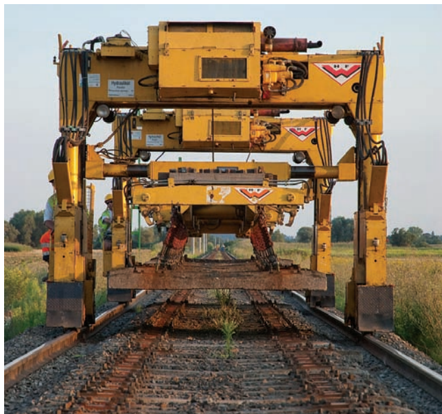
Vágánybontás Boba–Ukk állomások között
