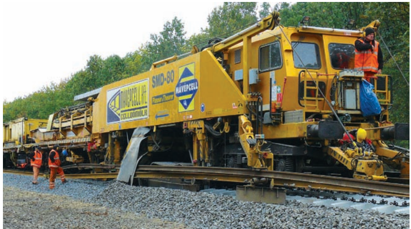
3. ábra. SMD 80 – vágányátépítés
