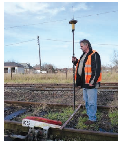
6. ábra. Kisiklasztó saru helyének meghatározása a VRS gánytengelyben
