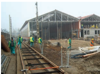
Villamosremíz építése, Szeged
