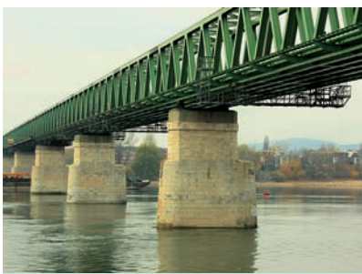
Az Északi vasúti Duna-híd építése 2007. február – 2009. május
