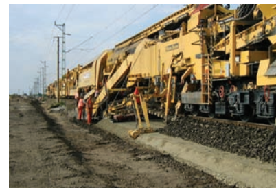
Alépitmény-átépítés RPMW géppel Kecskemét és Városhőd állomások között
