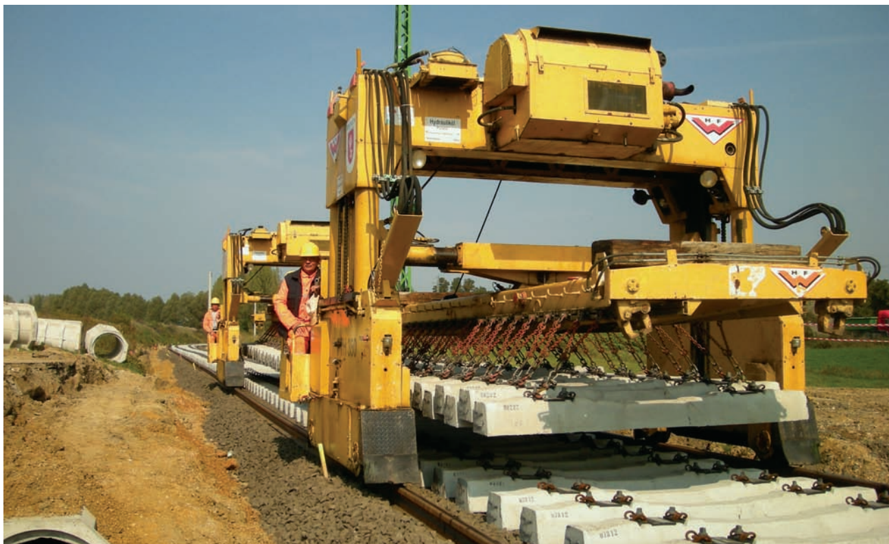
Vágányépítés Donnellvel Ukk és Boba állomások között
