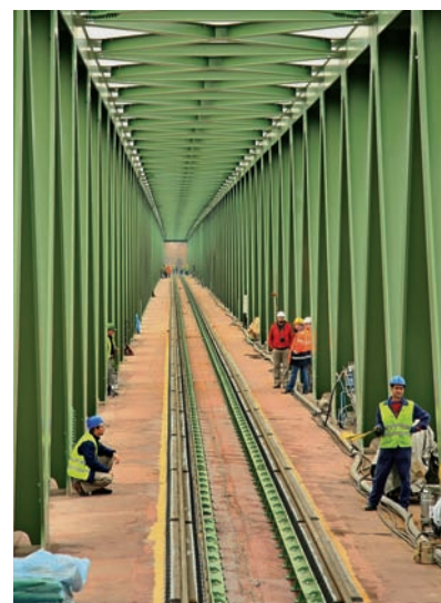
Az Edilon rendszerű vágány építése 2007. február – 2009. május
