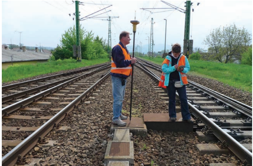
5. ábra. Akna mérése Topcon GNSS vevővel
