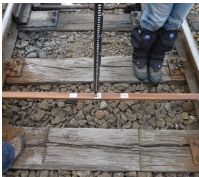
10. ábra. A vágánytengely meghatározása a kitérő elején
