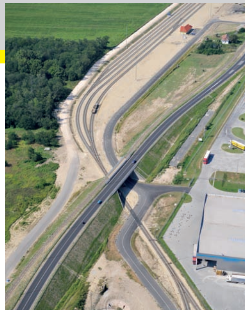
Győr-Gönyű Intermodális Központ építése
