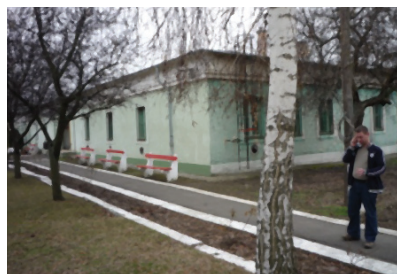
3. ábra. A soroksári szakaszmérnökségi épület
