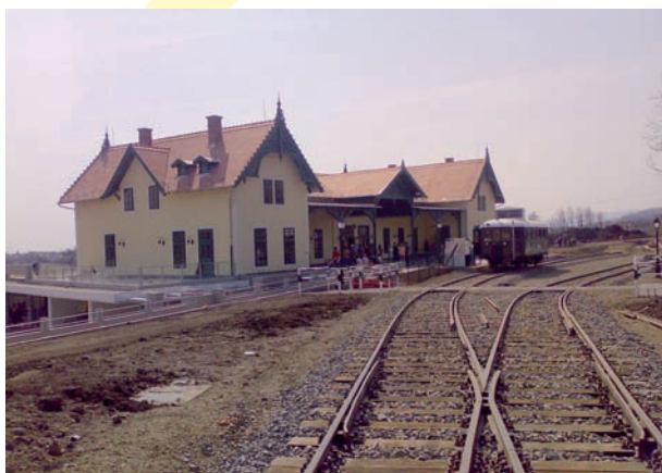
Szentendrei Skanzenben vasút építése
