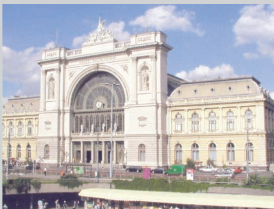
A Keleti pályaudvar a 4-es metró építésének megkezdése előtt
