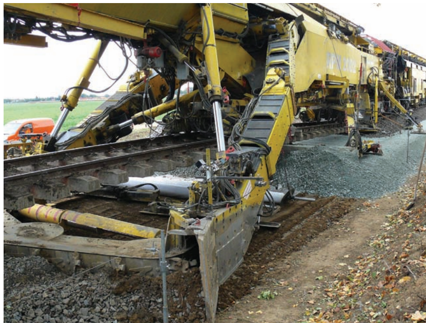
2. ábra. RPM 2002 – védőréteg beépítése
