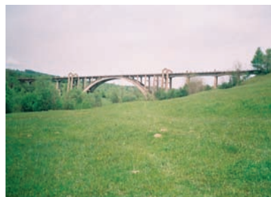
4. ábra. A sinkai viadukt a Fogaras–Brassó vasútvonalon
