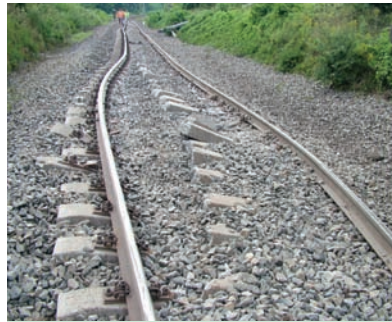
12. ábra. A szétszakított betonraljak
