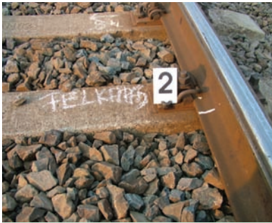
11. ábra. A felkapás helye a kinyomódás közepén
