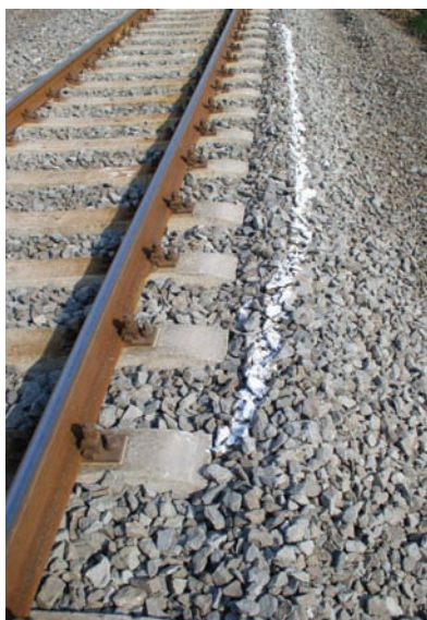
8. ábra. Az ágyazatra felfestett kivetődés megjelölése
