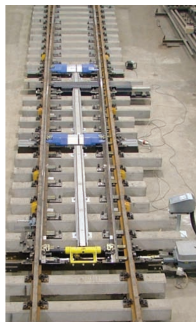
8. ábra. B60-800 rendszerű kitérő Spherolock zárszerkezetekkel és Hydrolink erőátviteli berendezéssel
