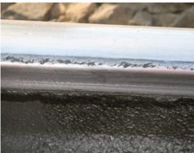
15. ábra. A repedések jelentős hosszban egységes repedéssé fejlődtek
