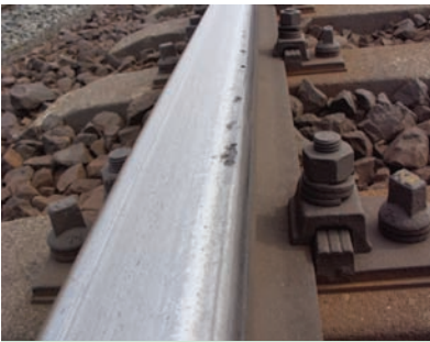
12. ábra. Head Checking repedések kipattogzódása az érintkezési felületen
