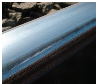
11. ábra. Repedési hibák megjelenése a sín vezetési felületén, az ív külső sínzálában
