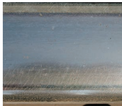
10. ábra. Head Checking repedések a futófelületen
