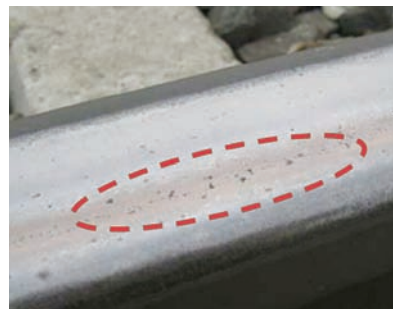
9. ábra. Barna elszíneződések, ahol nagy valószínűséggel megjelennek a Head Checking repedések
