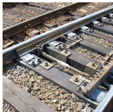
4. ábra. Integra rendszerű zárnyelves csúcssínrögítő
