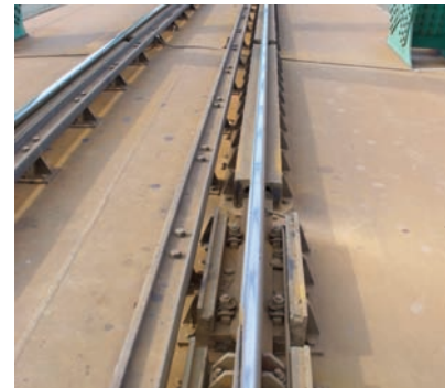
12. ábra. Edilon felépítmény acélszerkezetű hídon
