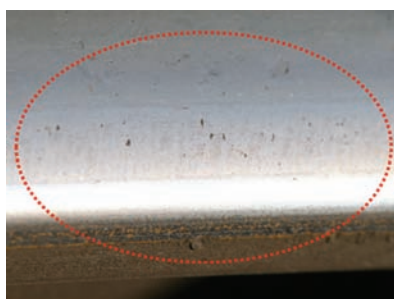
19. ábra. A sínfejrepedés előjele a futófelület barna elszíneződése
