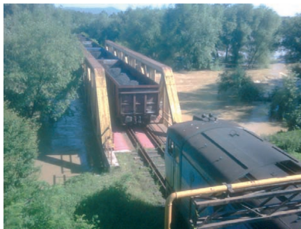
2. ábra. Hidasnémeti Hernád-híd
