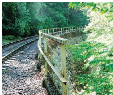
11. ábra. Támfal a vasútról nézve
