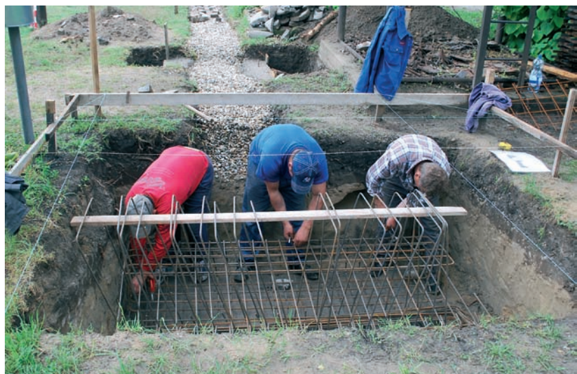
4. ábra. A hídfő vasszerelése
