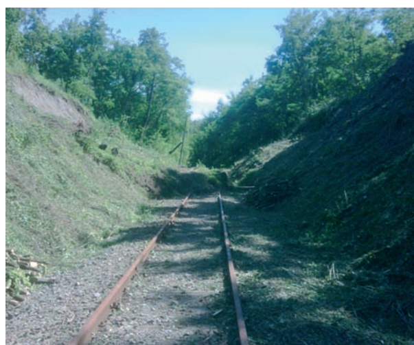
17. ábra. Az 520–521-es szelvény – rézsűcsúszás
