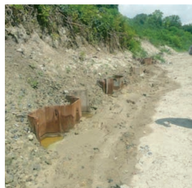
6. ábra. A levert támasztófal
