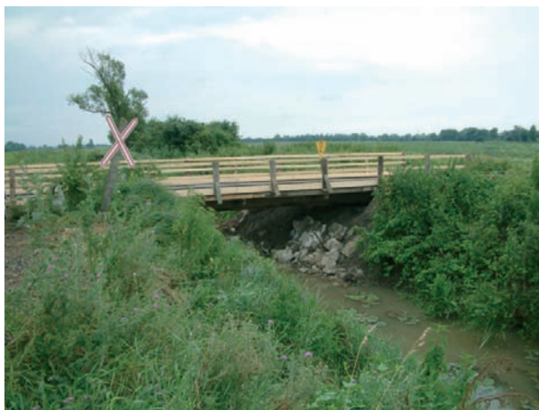
9. ábra. A beépített provizórium
