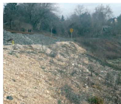
2. ábra. Rézsumozgás miatt bekövetkező fekszinthiba
