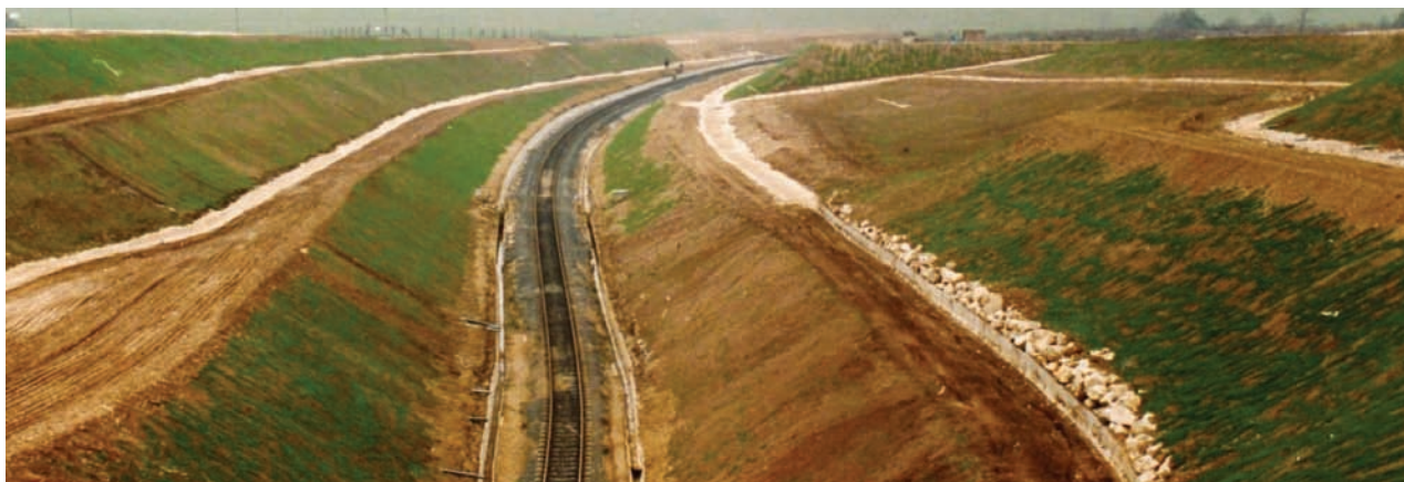
16. ábra. A IV. számú alagúthoz csatlakozó bevágás a töltéscsúszások helyreállítását követően
