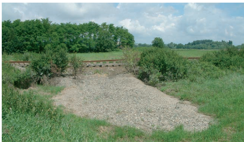
13. ábra. Az elmosott pályaszakasz a 482+00 – 482+30-as szelvényben
