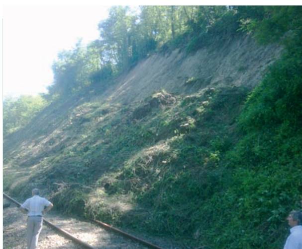
16. ábra. Az 520–521-es szelvény a növényzet kétoldali kitermelése után
