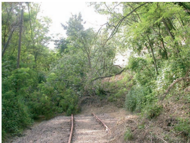
14. ábra. Az 537–539-es szelvény megcsúszás után
