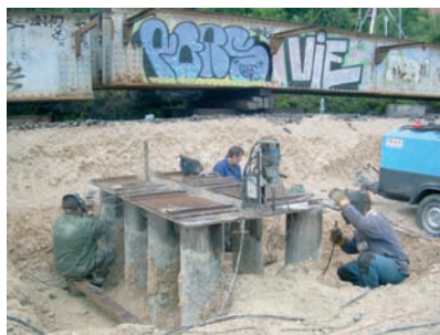
8. ábra. Közberső alátámasztás kialakítása
