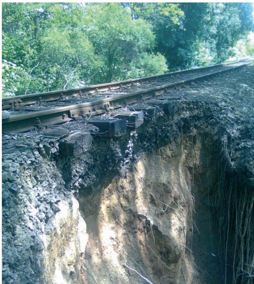
5. ábra. Nógrádkövesd és Magyarnándor között lecsúszott a részsífelület, a földtömeg magával sodorta az átereszt is
