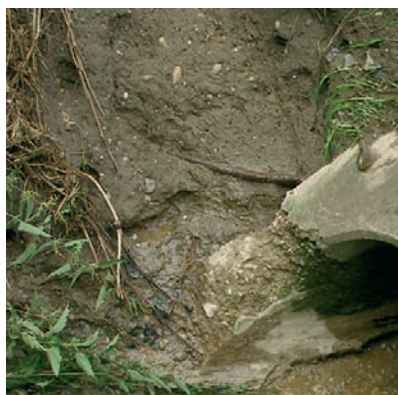
5. ábra. Csőáteresz fejelemének elmosása
