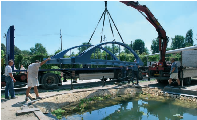
8. ábra. A szerkezet beemelése
