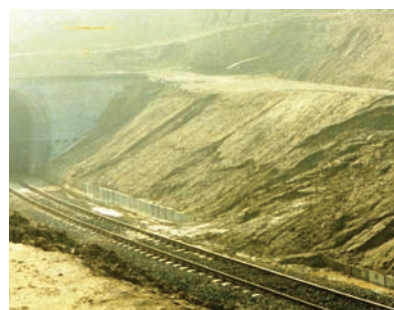
14. ábra. A IV. számú alagúthoz csatlakozó bevágás építés közben, a pálya jobb oldalán, a kapuzat előtt
