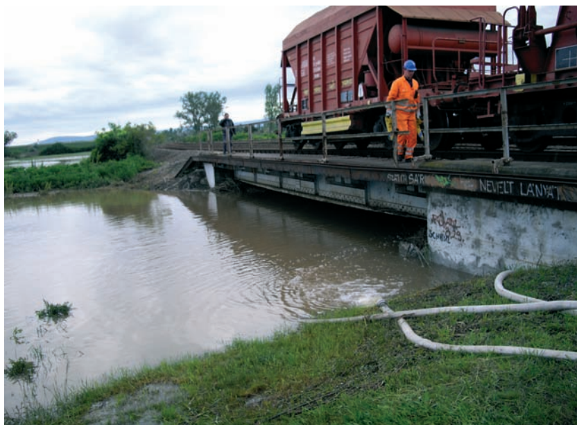
4. ábra. A Heréd patak zúzottkővel megrakott kocikkal leterhelt hídja
