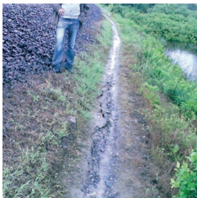
19. ábra. Repedés a padkán június 2-án (forrás: Ill. Szm)
