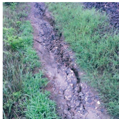
20. ábra. Roskadás a berepelt padkán június 22-én (forrás: Ill. Szm)
