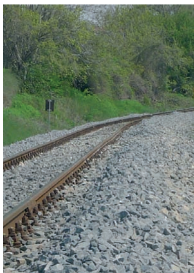
1. ábra. Forgalombiztonságot veszélyeztető pályahiba
