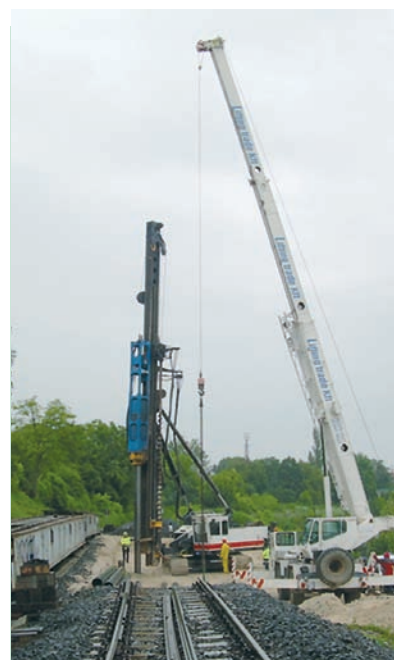
7. ábra. Előkészületek a provizórium beépítéséhez
