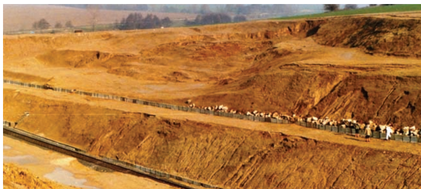
13. ábra. A IV. számú alagúthoz csatlakozó bevágás építés közben a pálya bal oldalán
