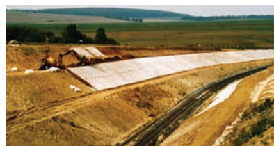
15. ábra. A IV. számú alagúthoz csatlakozó bevágás építés közben, a pálya jobb oldalán, humuszos gyepráccsal
