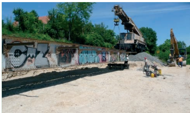
9. ábra. A provizórium beemelésének előkészítése
