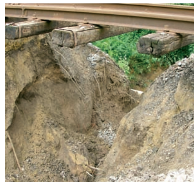
7. ábra. Oldalnézet a 471+42-es szelvénynél (3-4 m mélyen elmosott alépitmény) június 16-án
