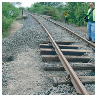
17. ábra. Fekszinthiba a 8+90 hm szelvénynél július 6-án (forrás: KfV Kft.)
