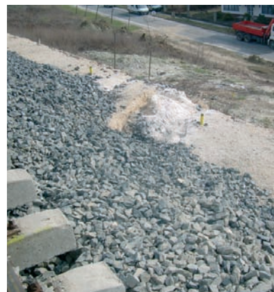
3. ábra. A fekszinthiba melletti ágyazathiány
