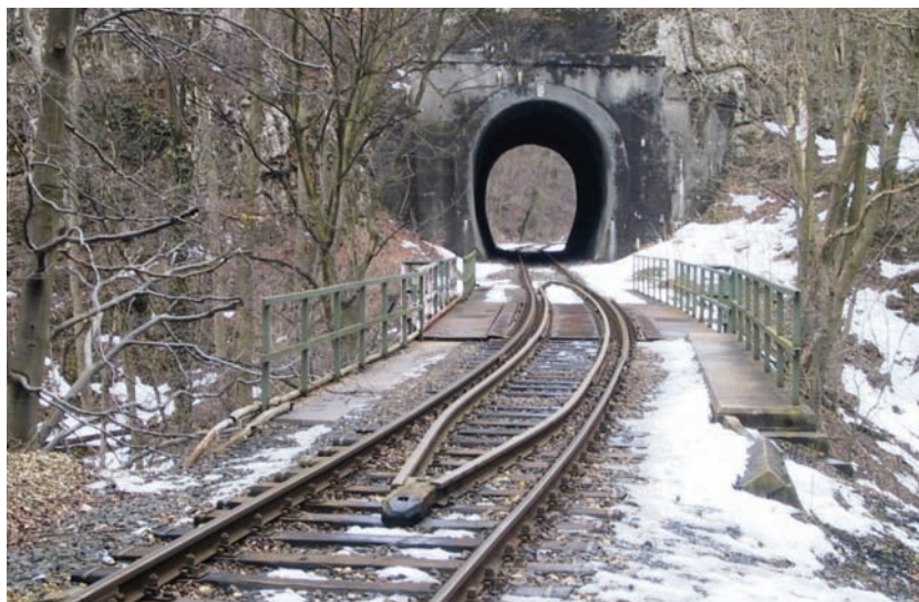
1. ábra. Az I. sz. alagút északi kapuzata, előtte a Cuha-patak hídja
