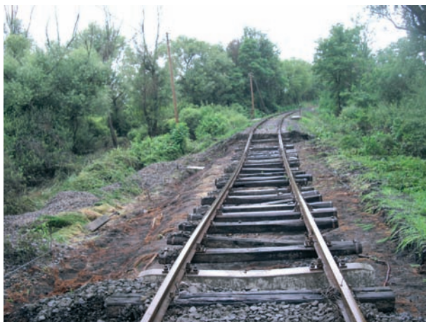
6. ábra. A pályán átfolyó víz által elmosott ágyazat Szécsény közelében, a 78-as vonalon
