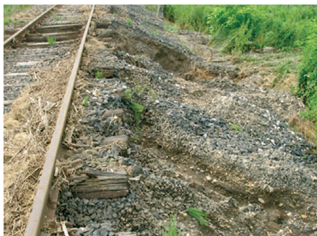
4. ábra. Pályaállapot Andocs megállóhelynél június 16-án
