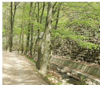
12. ábra. Támfal a Cuha-patak felől
