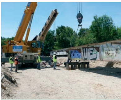
10. ábra. Provizórium beemelése
