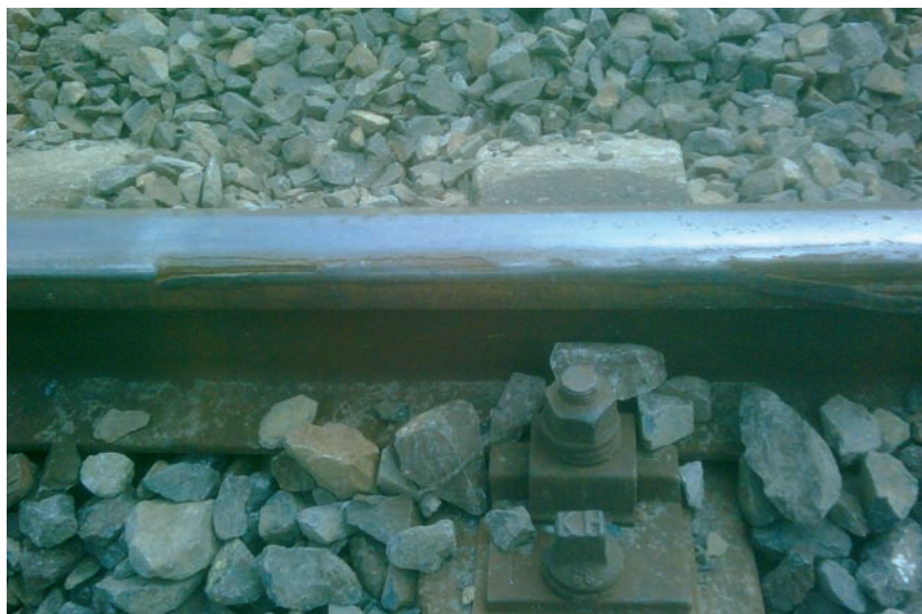
9. kép. 1966-ban gyártott és felújított sín-szal ET hegesztés melletti darabja
