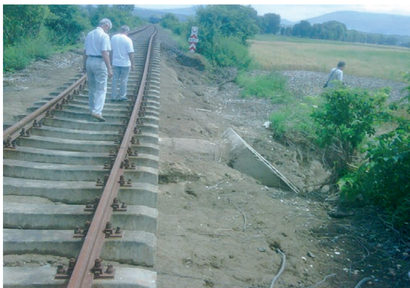
12. ábra. Az elmosott pályaszakasz a 484+100 – 484+48-as szelvényben
