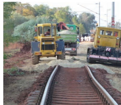
11. kép. Pufferréteg építése kis terhelésű járművekkel
