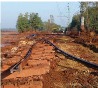
9. kép. Csak kisgéppel bontható pálya
