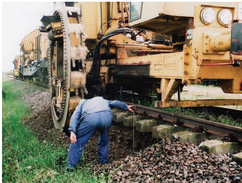
7. ábra. Meglevő ágyazat kikotrása, a kísérleti pálya előkészítő munkái
