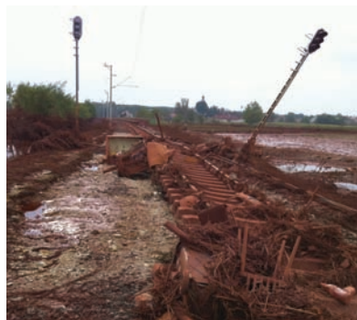
10. kép. Eddig soha nem tapasztalt szennyeződés a tönkrement vasúti pályán
