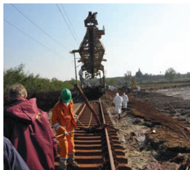
4. kép. Munkában a Platov vágány-építő gép
