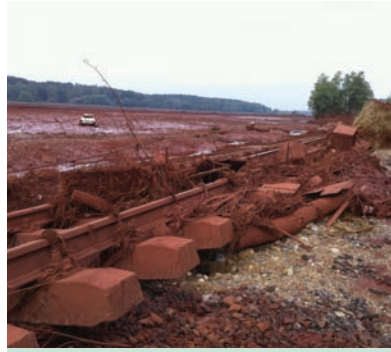
3. kép. Tengelyéből kimozdult vágány a hordalékokkal
