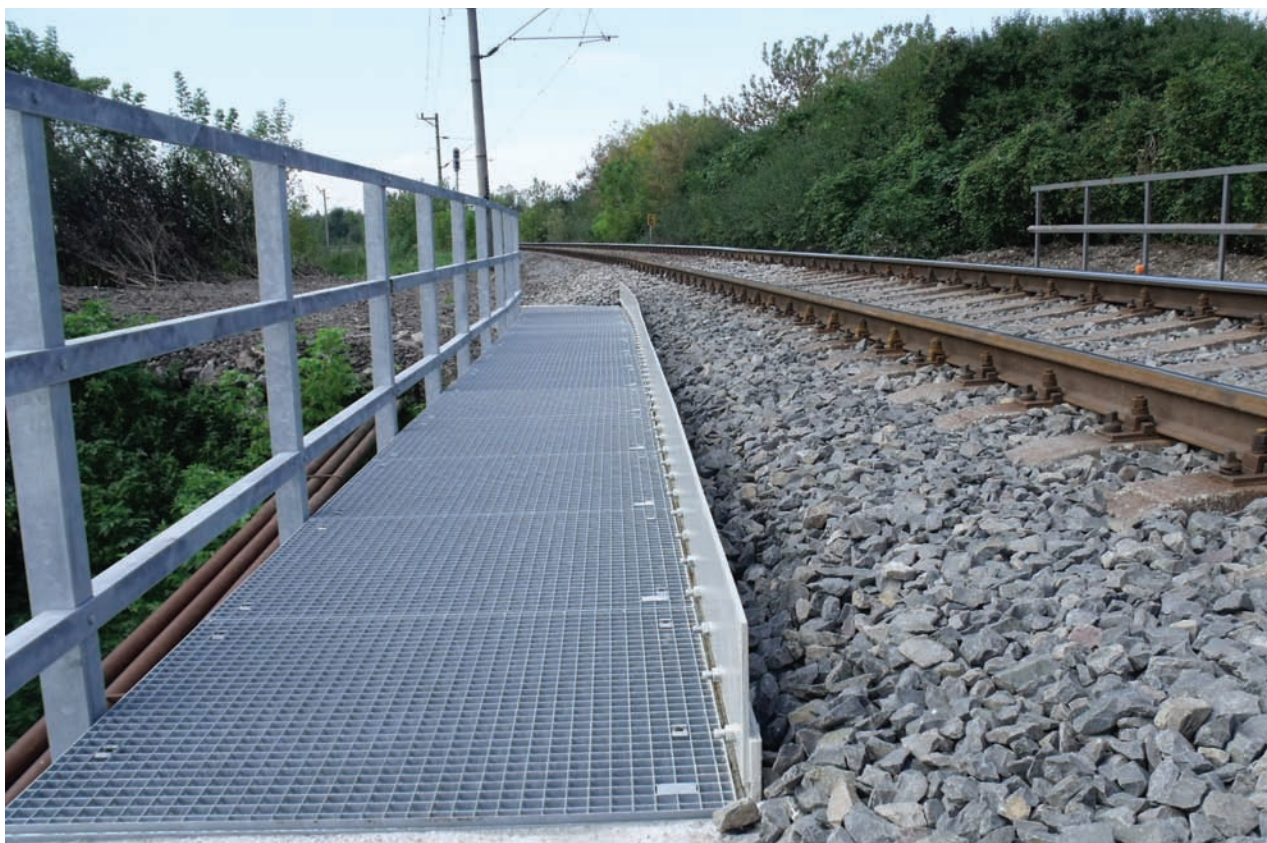
10. kép. Az elkészült új híd szegélye és a gyalogjáró
