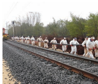
14. kép. kábelfektetés szokatlan módon
