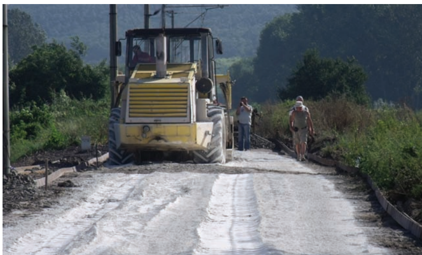
5. kép. Alépítmény-javítás Consolid eljárással a 40-es vonal, az 1378–1380 sz.-ben
