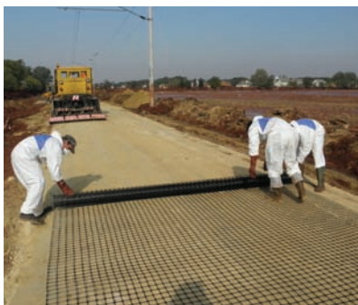
12. kép. Georács beépítése
