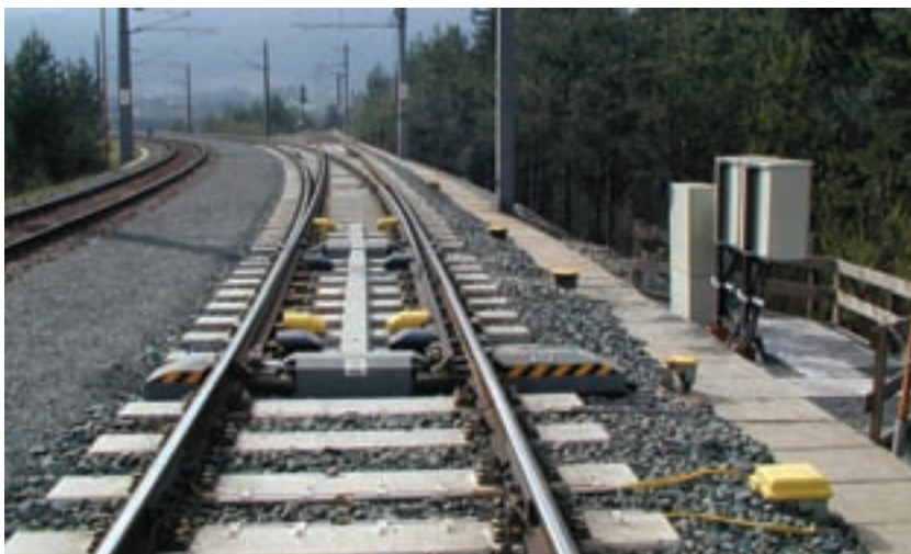
1. ábra. VAE Roadmaster 2000 diagnosztikai rendszerrel szerelt kitérő
