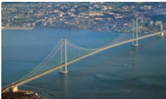
5. ábra. Az Akasi Kaikio híd [6]
