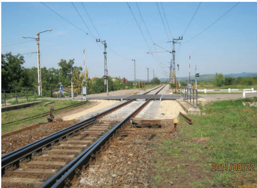
5. ábra. A rostálás, a csatlakozó felépítménycsere és az útátjáró-átépítés eredménye (Fotó: Nyitrai József)
