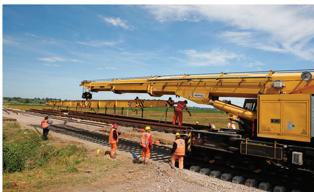
6. kép. Kitérő beépítése
