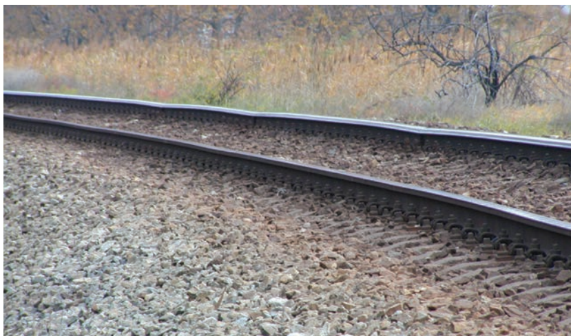
1. ábra. A felépítmény állapota átépítés előtt (Fotó: Szemerey Ádám)
