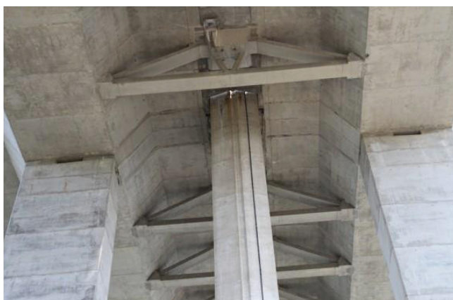
3. ábra. Középpilonos megoldás közvetlen pilon-merevítő- tartó kapcsolat nélkül
