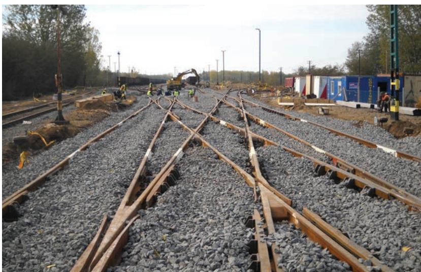
4. kép. Magasfogadó kettős vágány-kapcsolat építése
