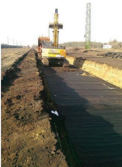
5. kép. Eperjeske rendező pályaudvar XII. vágány alépítmény-erősítés
