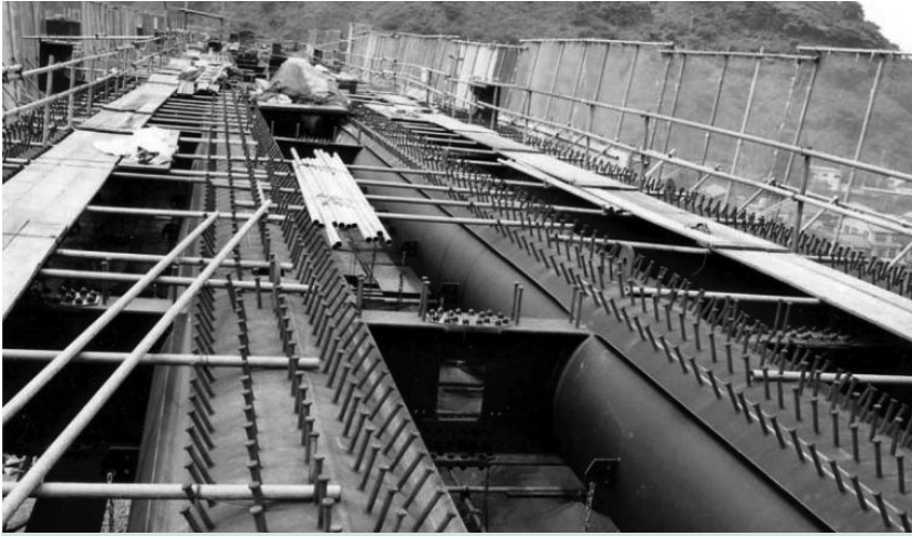
5. ábra. CFT híd építés alatt [3]
