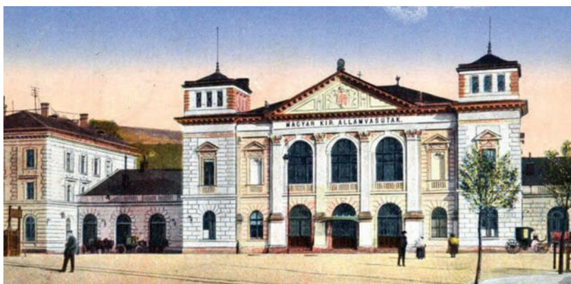
2. ábra. Pozsony állomás felvételi épülete, 1905
