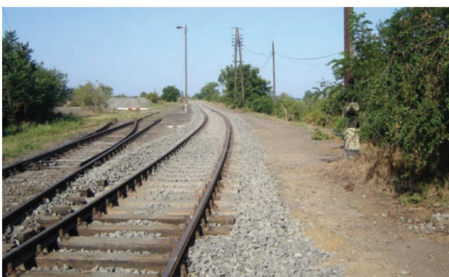
7. ábra. A vasútvonal az átépítés után
