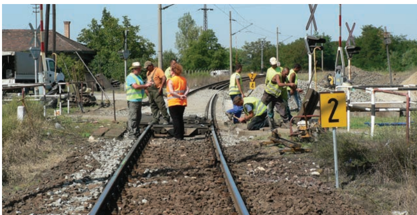
5. ábra. Vágányzár-ellenőrzés – útátjáró-átépítés Komáromnál
