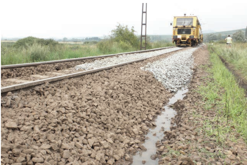
3. ábra. Az ágyazat állapotát jól mutatja a rostálás utáni kép (Fotó: Zomborszky György)
