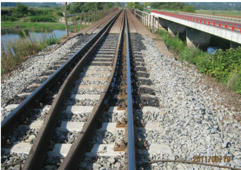
6. ábra. Ágyazatragasztás az Aranyos hídhoz csatlakozó pályán (Fotó: Nyitrai József)
