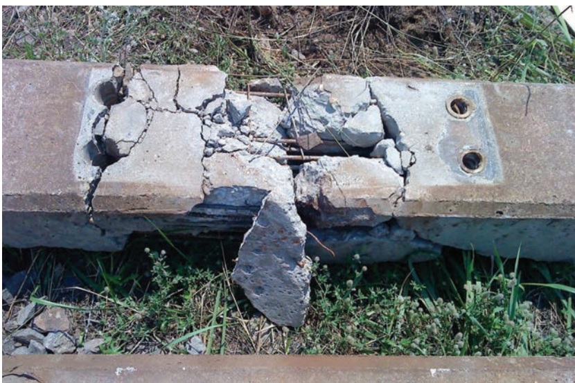
4. ábra. Csak kiemelve és az alátétlemez levétele után látszik, hogy a keresztvezés alatt teljesen tönkrement a vasbeton alj (Fotó: Kovács Csaba)
