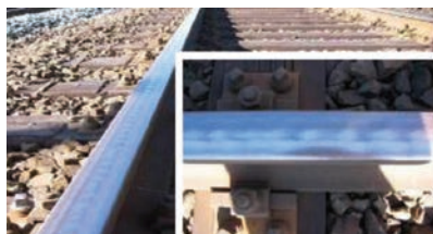
1. ábra. Futófelület egyenetlenségeinek eltávolítása
