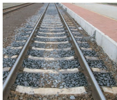
5. ábra. Zalabér-Batyk állomás átmenő fővágányában kialakított kísérleti szakasz
