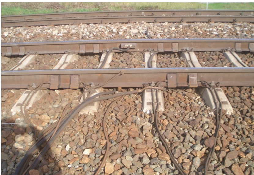
2. ábra. A sínszállakra ragasztott érzékelők, a rezgésérzékelő a sínfejen és a tengelyszámláló a sínkamrában
