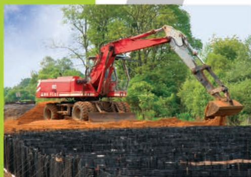
Töltésalapozás épített geocellával
