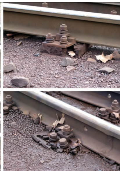
39–42. ábra. A rugalmas alátámasztás különböző tönkremenetelei
