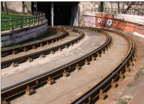
26. ábra. Kétvezetős kis sugarú ívek a Lánchíd előtt, a 19-es villamos vonalán
