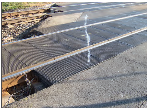
2. ábra. A kerékáthaladás kijelölése az Ikrényi úti átjáróban
