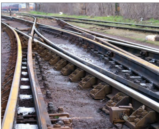
14. ábra. Az átszelési kitérő állapota
