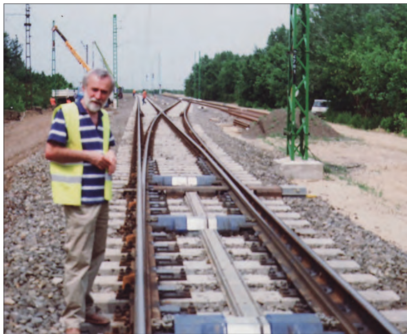
16. ábra. Nyíltvonal nagy sugarú vágánykapcsolat Déványa felé
