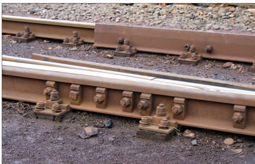
43. ábra. A 14. sz. kitérő jobb oldali leerősítései
