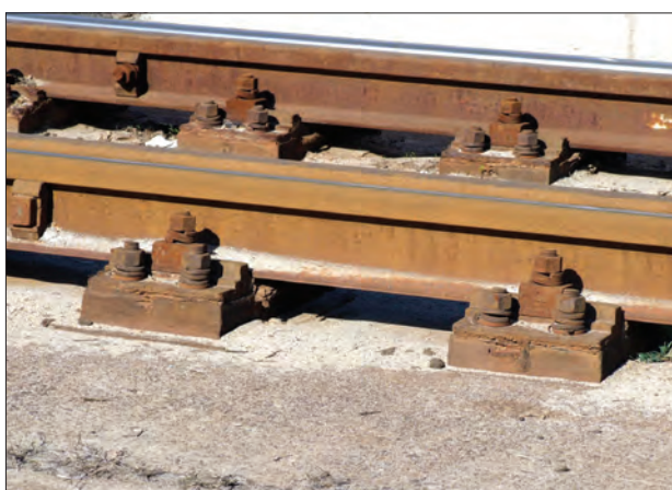
20. ábra. A megengedettnél vastagabb aláöntés
