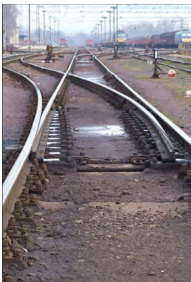
36. ábra. Az 5. és 13. sz. kitérők, előttük a KC-220-as ragasztású átszelési kitérő vége
