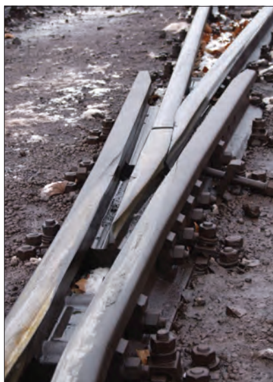
38. ábra. A 13. sz. kitérő kopott keresztezése
