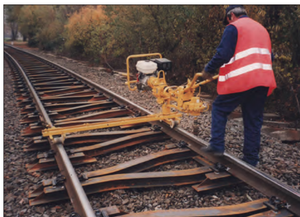
11. ábra. Y aljas vágány a Badacsonyi megállóhely utáni ívben
