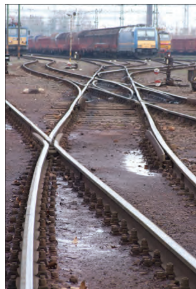
37. ábra. A 13. sz. kitérő mellékirányának vége
