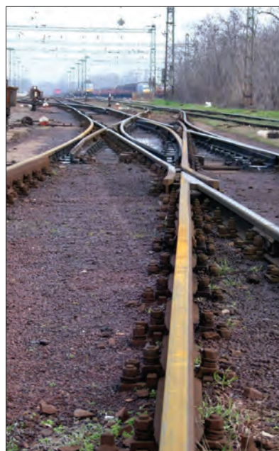
13. ábra. Az átszelési kitérő a szomszédos vágányról nézve
