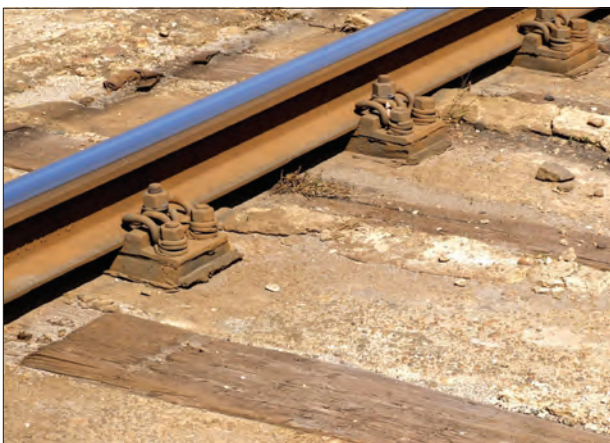
32. ábra. Ragasztott leerősítések a talpfák között
