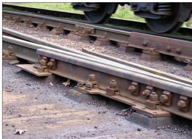
19. ábra. Az eredetitől eltérő sínzések okozta csavar-elhajlások és kitöredezés
