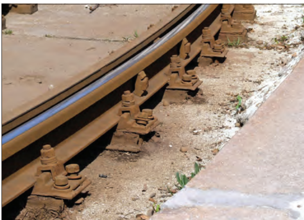
28. ábra. Az ív külső oldalán látható súlyos meghibásodások
