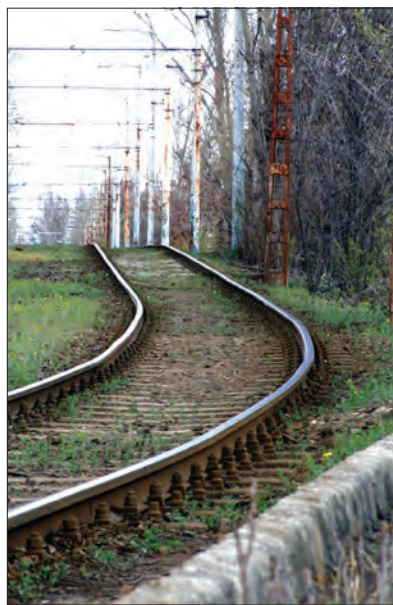
9. ábra. A csatlakozó zúzottkő ágyazatos felépítmény irányhibái
