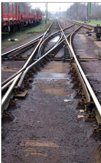
12. ábra. Átszelési kitérő az átmenő-vágányban
