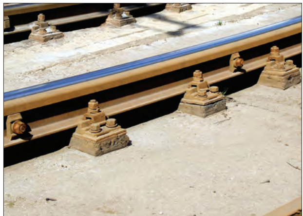
27. ábra. Túl magas alöntések, elvált alátétlemez
