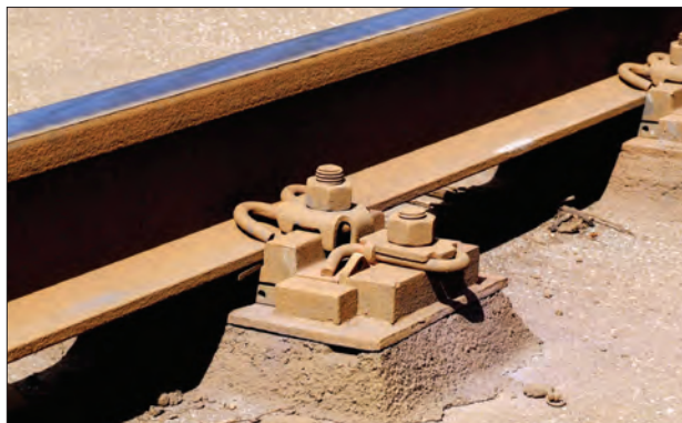
6. ábra. A 14-es villamos betonlemezre ragasztott leerősítése a Szilas-patak hídjának környezetében
