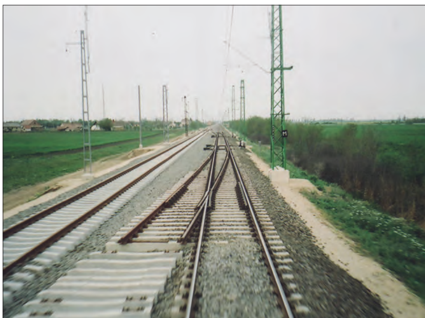
13. ábra. Nyíltvonali nagy sugarú vágánykapcsolat építése Tiszatenyő–Mezőtúr állomások között
