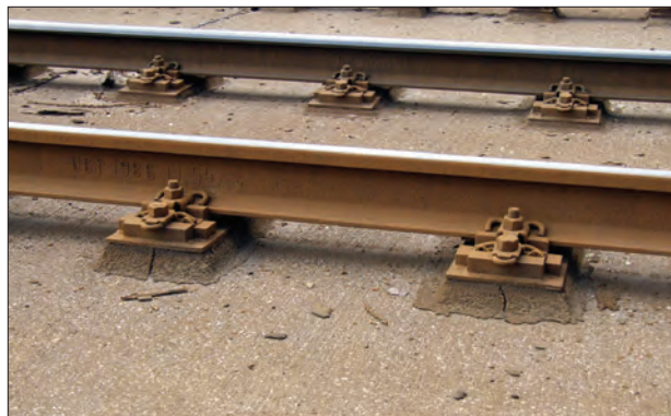
7. ábra. Jellegzetes repedések
