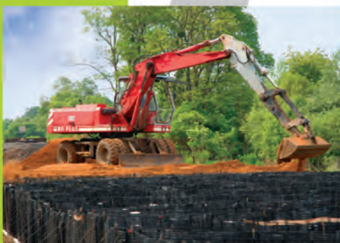
Töltésalapozás épített geocellával
