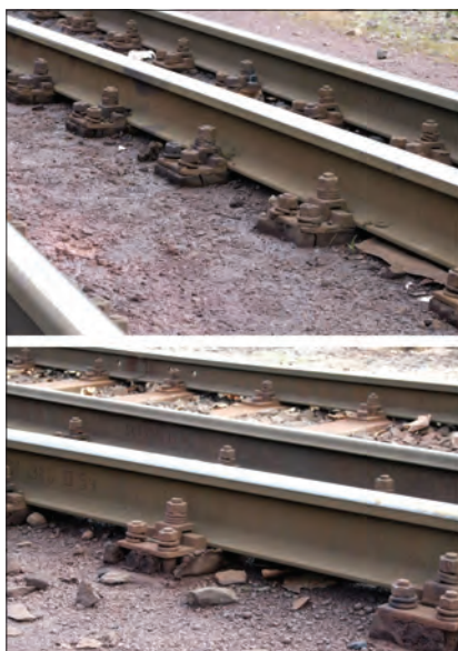
39–42. ábra. A rugalmas alátámasztás különböző tönkremenetelei
