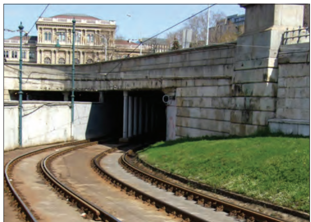
29. ábra. A 2-es villamos átvezetése a Lánchíd alatt
