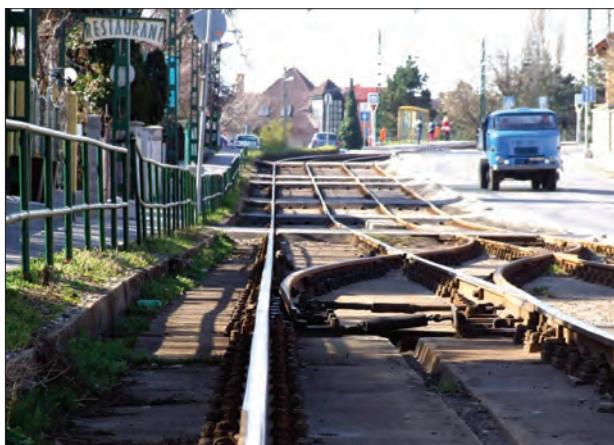
22. ábra. Egyszerű vágánykapcsolás egy kis emelkedésű szakaszon
