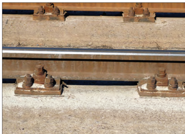
23. ábra. Az aláöntőanyag kismértékű kitüremkedése és elhajlott tőcsavarok
