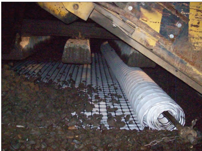
7. ábra. Georácsok beépítése Lébény-Kimle jobb vg. kísérleti szakaszon 2010. május 25/26. éjszakai vágányzárban
